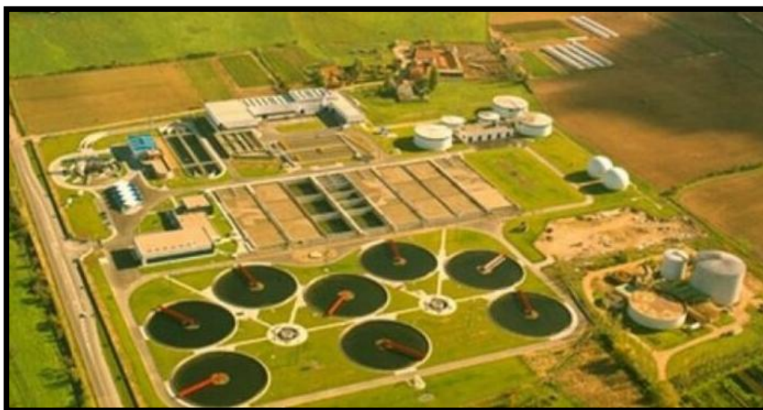
EDAR de la ciudad de Valladolid
