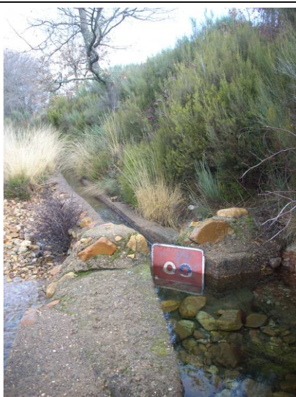
Captación para regadío. Salamanca.
