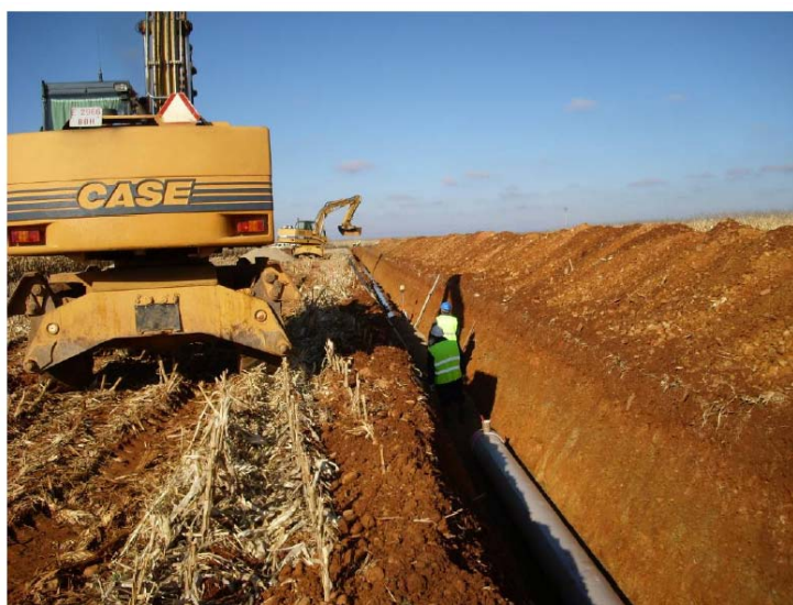
Montaje de tubería en la CR del Canal del Páramo Bajo
