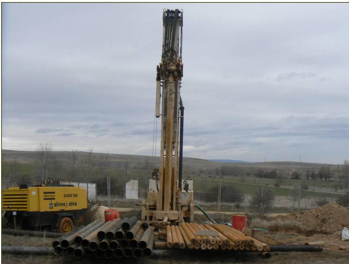
Figura 12. Trabajos de construcción de sondeos para el desarrollo de los programas de seguimiento del estado de las masas de agua subterránea en la cuenca española del Duero.
