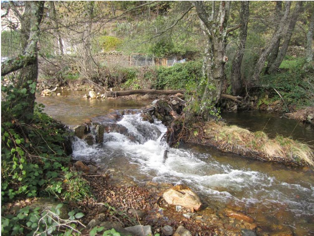
Figura 8. Río Fontarín. Azud de piedra con código 3055, franqueable y no tiene dispositivo de franqueo.
