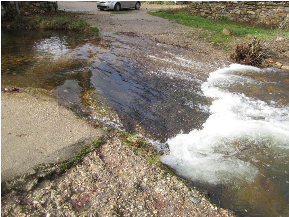
Figura 9. Río Fontarín. Paso para vehículos de hormigón con código 4328, franqueable y no tiene dispositivo de franqueo.
