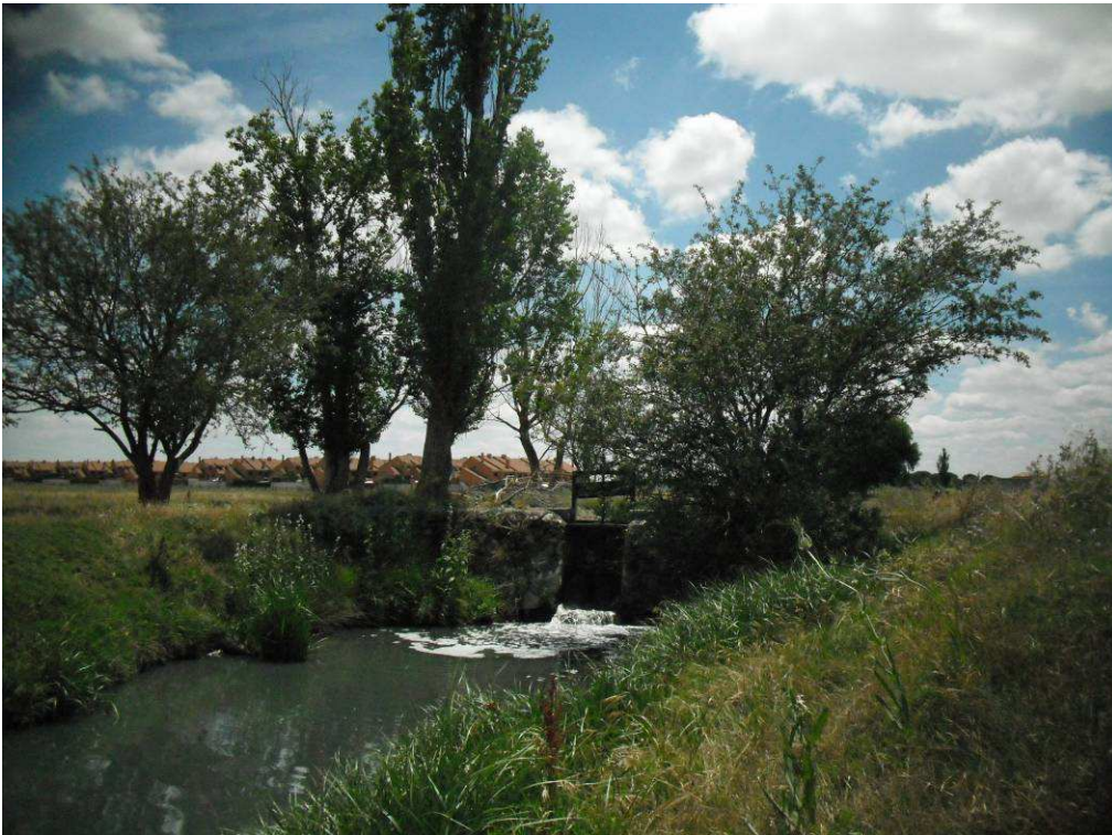
Figura 1. Azud en el arroyo del Molino con código 1645. Se utilizaba para canalizar agua APRA el riego. Es infranqueable y no tiene dispositivo de paso.
