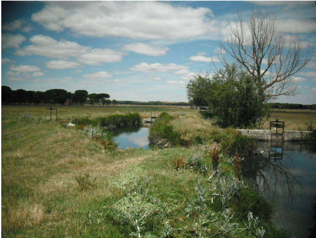
Figura 3. El único azud presente en este arroyo dentro del LIC, produce un remanso aguas arriba, al producir una retención de los caudales.
