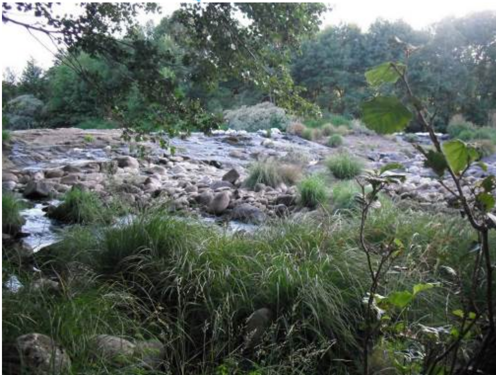
Figura 24. Río Tormes (Tramo alto). Azud con código 3871, de piedra y hormigón, que desvía agua para riego. Es infranqueable para algunos peces.
