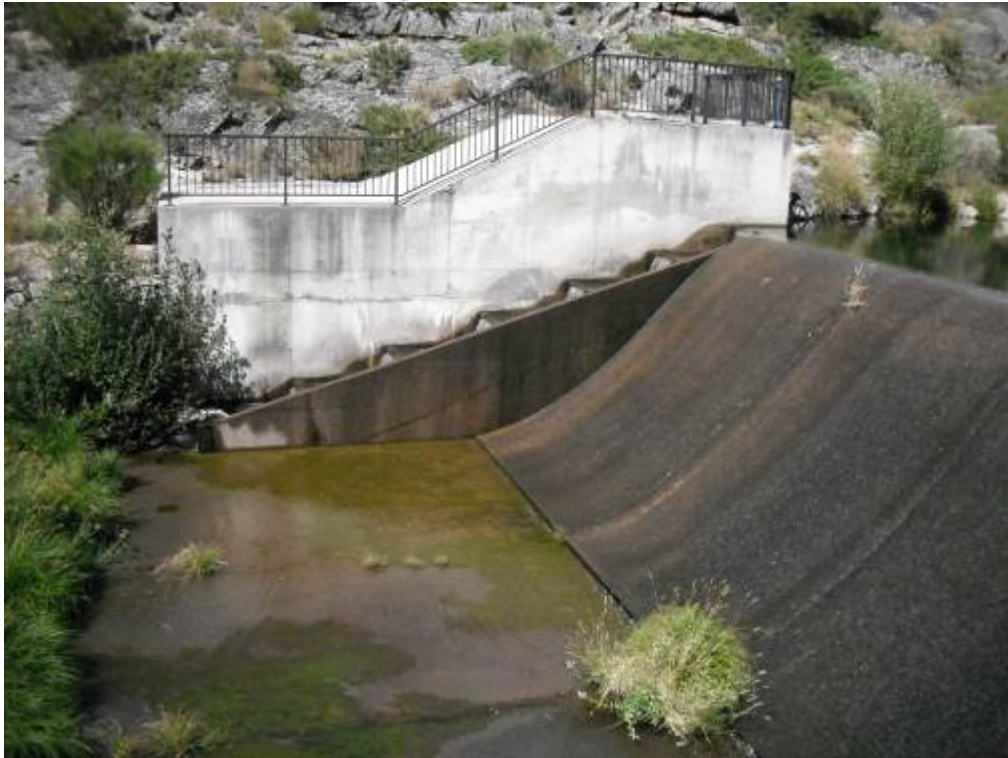
Figura 34. Río Corneja (Tramo alto). Presa con código 3932, de hormigón que desvía agua para riego. Es infranqueable, aunque tiene dispositivo de franqueo.
