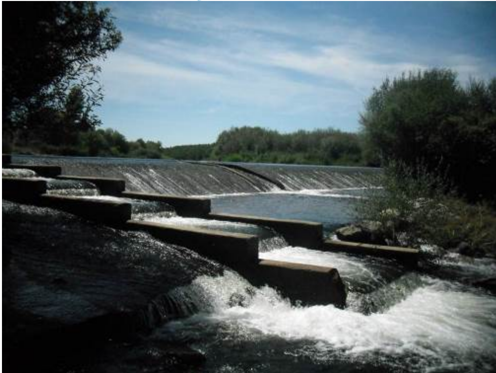
Figura 40. Río Tormes (Tramo medio). Azud con código 1261, de hormigón, que desvía agua a una piscifactoría. Es franqueable para algunos peces y tiene dispositivo de paso formado por estanques sucesivos.
