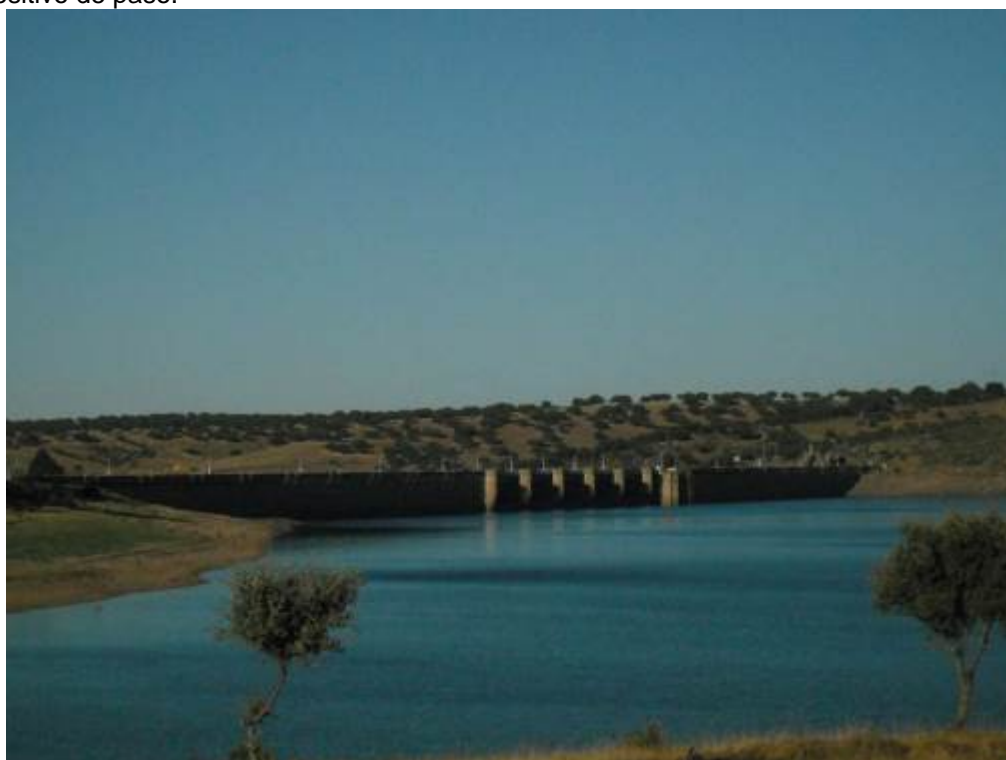
Figura 37. Río Tormes (Tramo medio). Presa con código 1274, de hormigón, que desvía agua para una central hidroeléctrica y riego. Es infranqueable y no tiene dispositivo de paso. Embalse de Santa Teresa.
