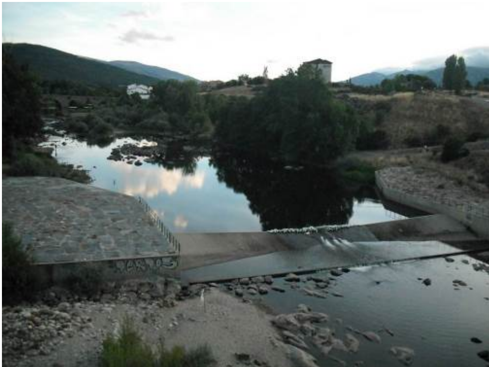
Figura 23. Río Tormes (Tramo alto). Estación de aforo con código 3873, de hormigón e infranqueable.
