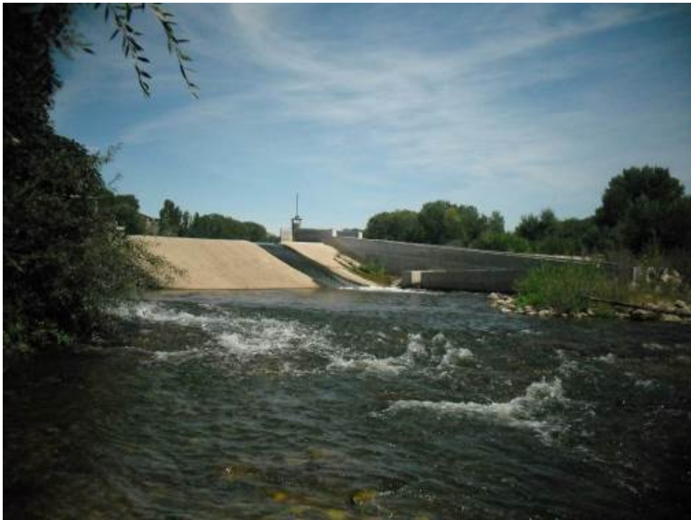
Figura 41. Río Tormes (Tramo bajo). Azud con código 1147, de hormigón que desvía agua a una central hidroeléctrica. Es infranqueable para algunos peces, y tiene dispositivo de franqueo.
