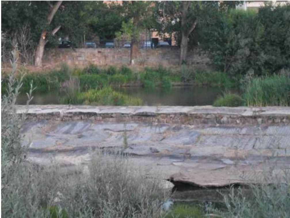
Figura 22. Río Tormes (Tramo alto). Azud con código 3874, de hormigón y piedra, que desvía agua para usos industriales, se encuentra en buen estado. Es infranqueable.
