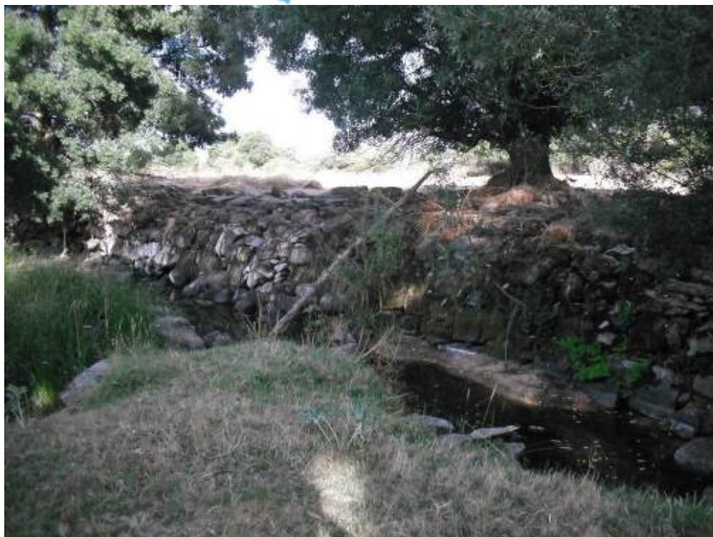
Figura 36. Río Corneja (Tramo alto). Azud con código 3940, de piedra, que desviaba agua para uso industrial y que actualmente se encuentra abandonado. Es infranqueable y no tiene dispositivo de paso.
