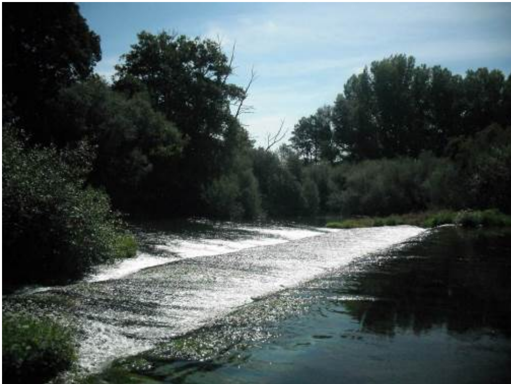
Figura 39. Río Tormes (Tramo medio). Azud con código 1263, de hormigón y piedra, que desvía agua a una piscifactoría. Es infranqueable y no tiene dispositivo de paso.
