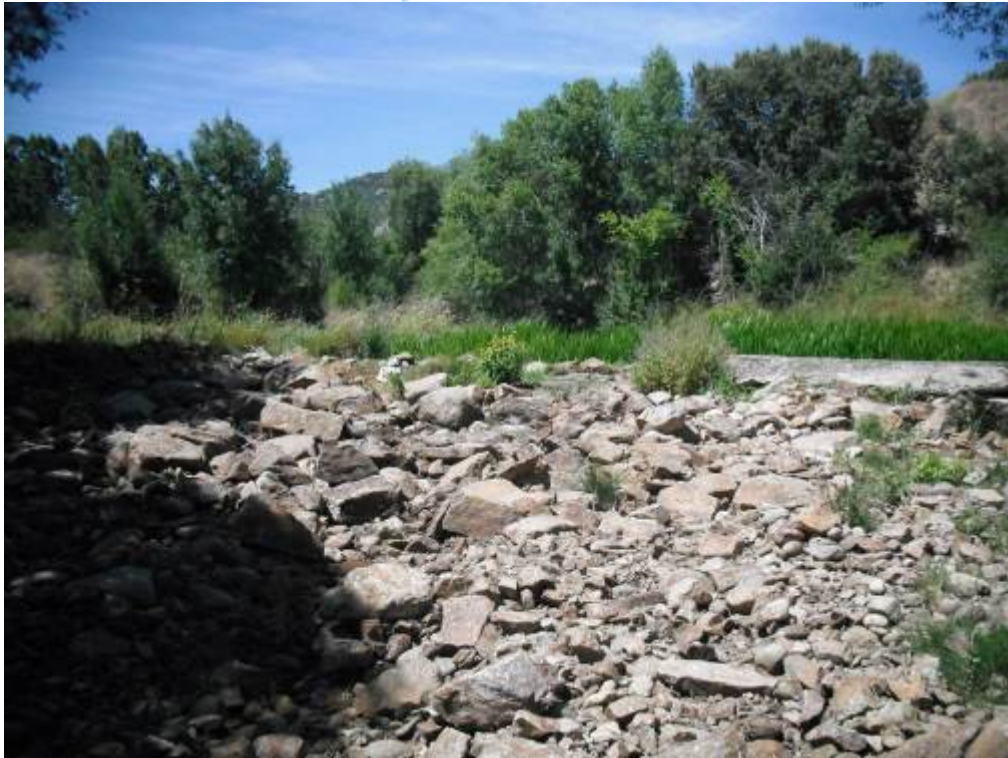
Figura 30. Río Becedillas (Tramo alto). Azud con código 3921. Es un obstáculo de hormigón y piedra, que desvía agua para riego.
