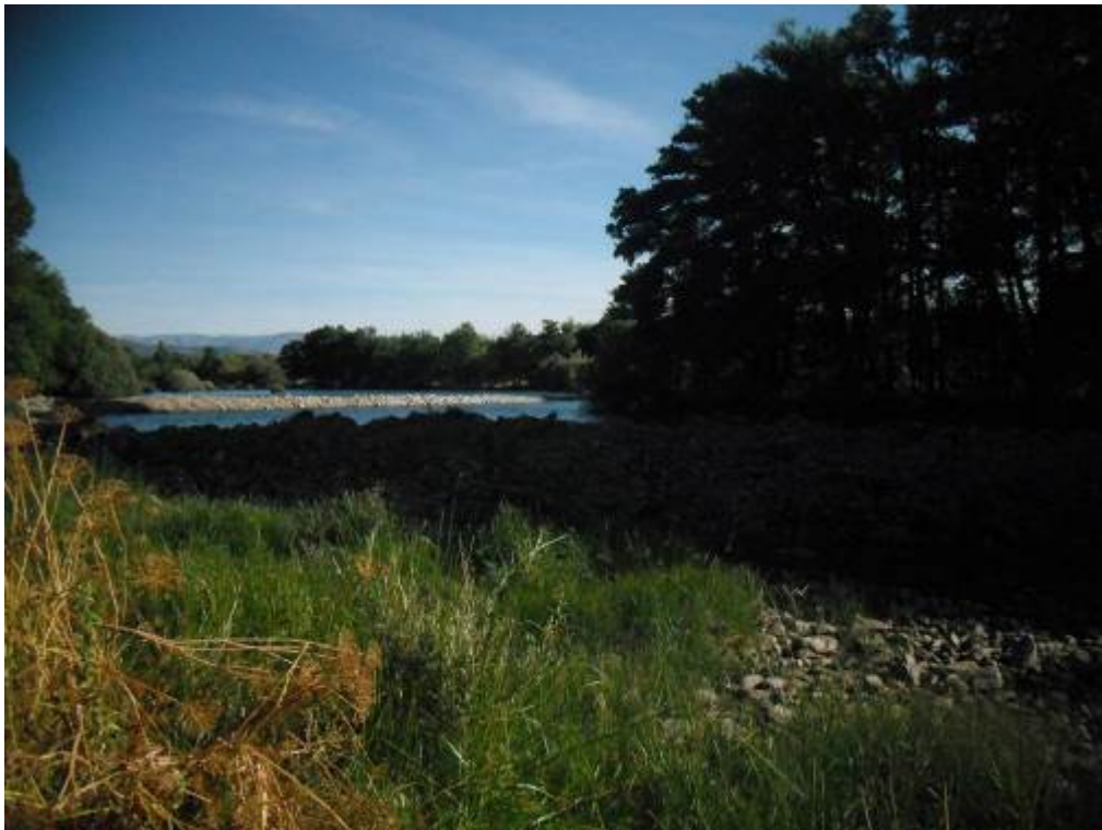
Figura 29. Río Tormes (Tramo alto). Azud con código 1267. Se trata de un azud que en el lado izquierdo es de hormigón y en el lado derecho es de piedra. Desvía agua para uso industrial y abastecimiento. Es infranqueable.
