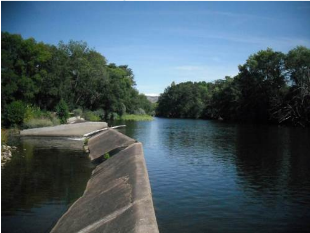
Figura 26. Río Tormes (Tramo alto). Azud con código 1272, de hormigón, que desvía agua a una central hidroeléctrica. Es franqueable para algunos peces y tiene dispositivo de franqueo.
