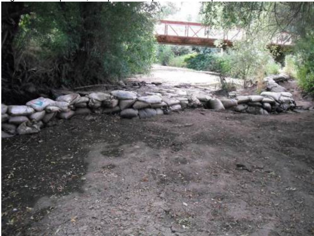
Figura 35. Río Corneja (Tramo alto). Obstáculo con código 3936, formado por sacos colocados de forma transversal al cauce del río, para desviar agua hacia zonas de riego. Franqueable para algunos peces.
