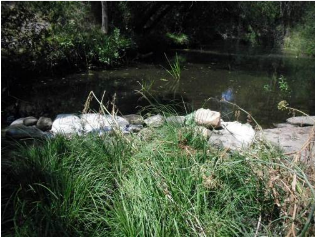
Figura 32. Río Becedillas (Tramo alto). Azud con código 3922, de piedra y hormigón, que desvía agua para riego. Es franqueable para algunos peces y no tiene dispositivo de paso.
