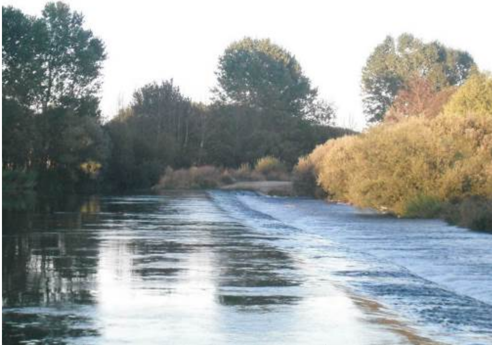
Figura 38. Río Tormes (Tramo medio). Azud con código 1264, de hormigón y piedra, que desvía agua a dos piscifactorías. Es infranqueable para algunos peces y no tiene dispositivo de paso.
