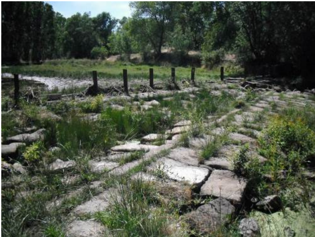
Figura 33. Río Becedillas (Tramo alto). Azud con código 3928, de piedra y hormigón que desvía agua para riego. Es franqueable para algunos peces y no tiene dispositivo de paso.
