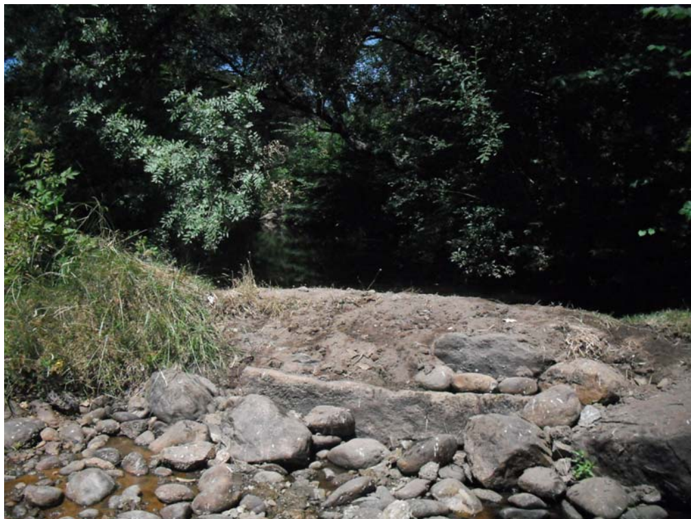
Figura 31. Río Becedillas (Tramo alto). Azud con código 4269, de tierra y piedras, que desvía agua para riego. Es franqueable para algunos peces y no tiene dispositivo de franqueo.
