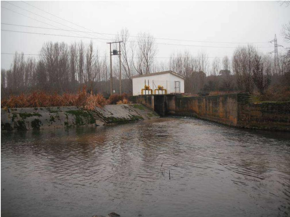
Figura 5. Azud de grandes dimensiones de Berlanga de Roa. Crea un embalsamiento en el que se han depositado una cantidad elevada de sedimentos, es capaz de producir una regulación del caudal al producirse el llenado del vaso del embalse. Es el único que está incluido en el Espacio Protegido, y es donde se inicia el canal de riego del Riaza.
