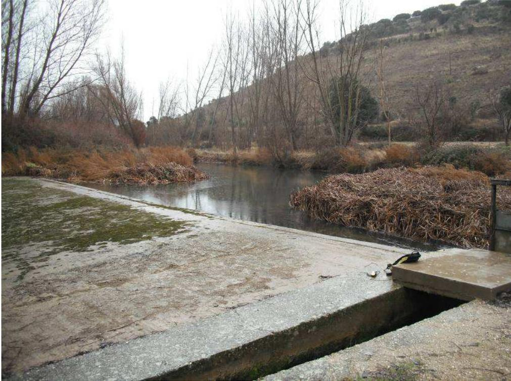
Figura 1. Azud de Adrada, ubicado dentro del casco urbano, el gran paramento aguas abajo impide la franqueabilidad.
