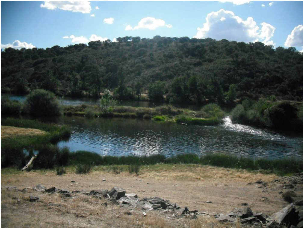
Figura 7. Río Águeda. Localidad: Castillejo de Martín Viejo. Azud con código 1129. Es un azud de mampostería, abandonado y roto por algunas zonas, lo que lo hace franqueable.
