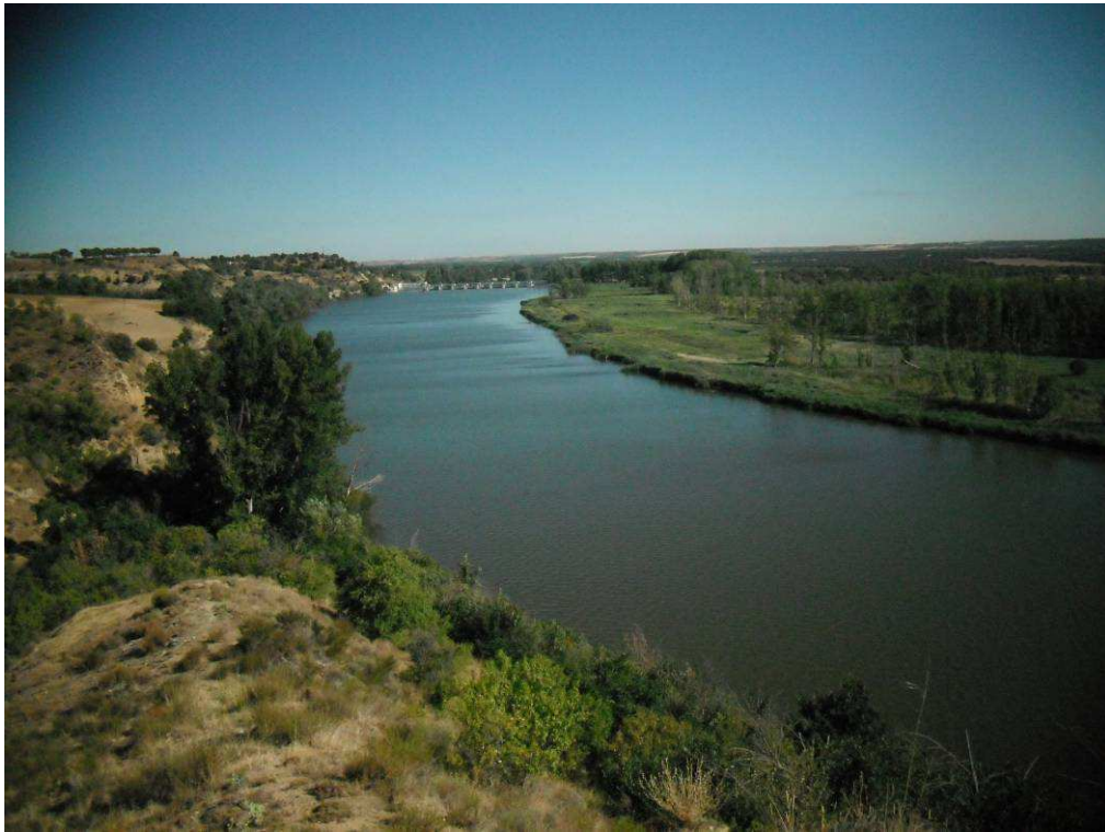
Figura 7. Vista de la presa de San José, al fondo de la imagen, y el tramo de río aguas debajo de esta, que sufre los desembalses y cuya morfología se ha simplificado, transformándolo en un canal único, recto y sencillo que conduce los desembalses.
