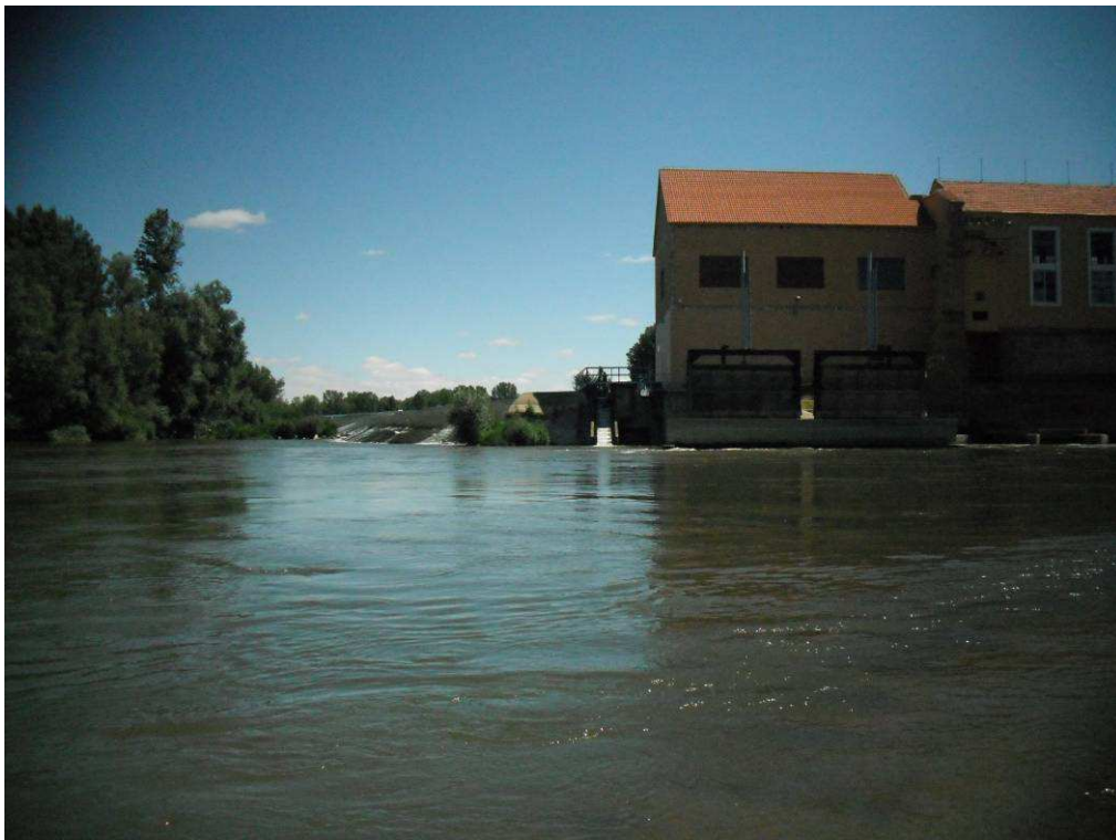
Figura 7. Vista de la presa de San José, al fondo de la imagen, y el tramo de río aguas debajo de esta, que sufre los desembalses y cuya morfología se ha simplificado, transformándolo en un canal único, recto y sencillo que conduce los desembalses.
