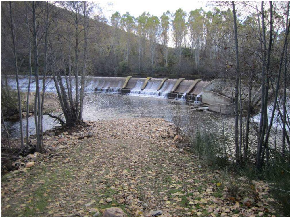
Figura 6. Río Trefacio. Presa de hormigón con código 2506, infranqueable y tiene dispositivo de franqueo.
