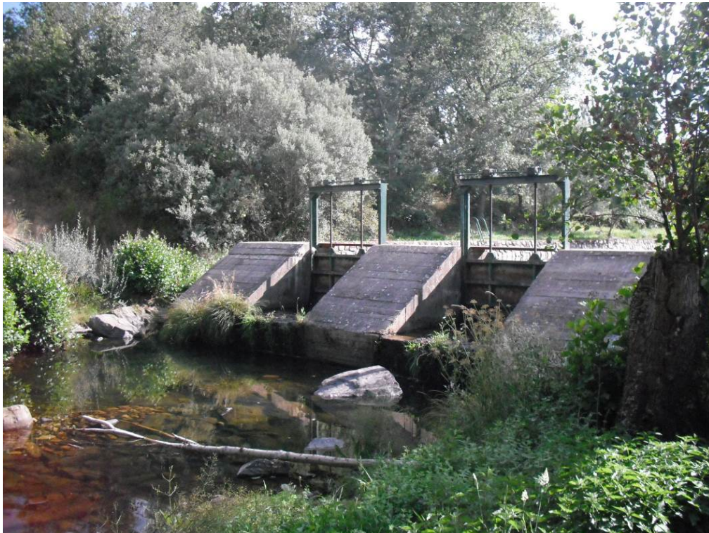
Figura 7. Río Barranca. Localidad: El Cabaco. Paso para vehículos con código 4522. Es infranqueable para algunos peces, y no tiene dispositivo de franqueo.
