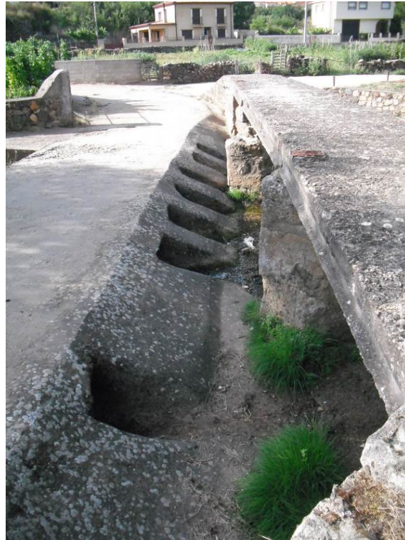
Figura 7. Río Barranca. Localidad: El Cabaco. Paso para vehículos con código 4522. Es infranqueable para algunos peces, y no tiene dispositivo de franqueo.
