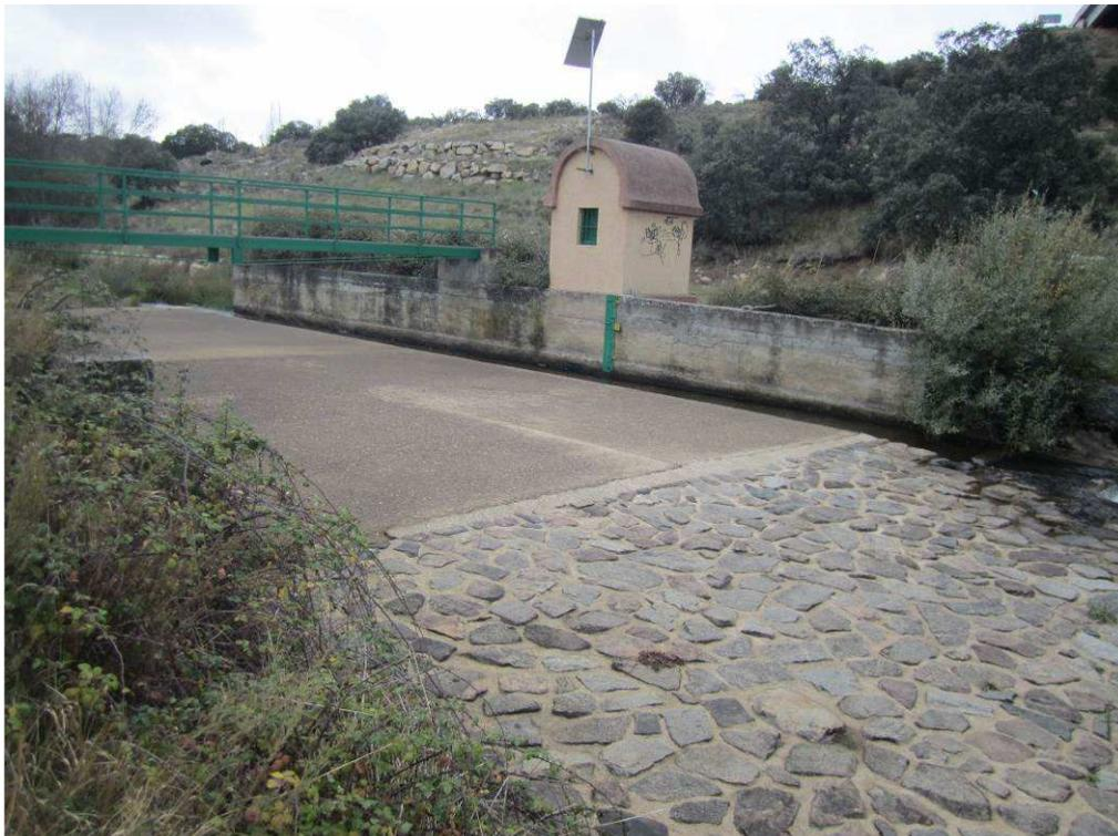
Figura 11. Río Voltoya. Localidad: Ojos-Albos. Estación de aforo con código 4508. Es franqueable y tiene dispositivo de franqueo que consiste en una escala de peces.
