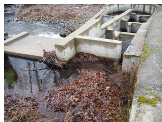
Figura 5. Ejemplo de un atrampón de hojas a la entrada de un paso para peces como consecuencia de un mantenimiento deficiente.
