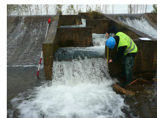
Figura 6. Ejemplo de un paso para peces que requiere de mejoras en su diseño.
