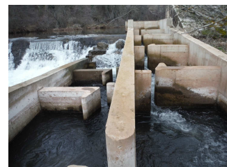
Figura 2. Escala de estanques sucesivos y hendiduras verticales evaluada para conocer su aptitud en cuanto al paso de peces en la cuenca Duero.
