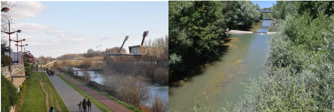
Presiones del río Bernesga: obras de canalización y traviesas de estabilización del perfil longitudinal
