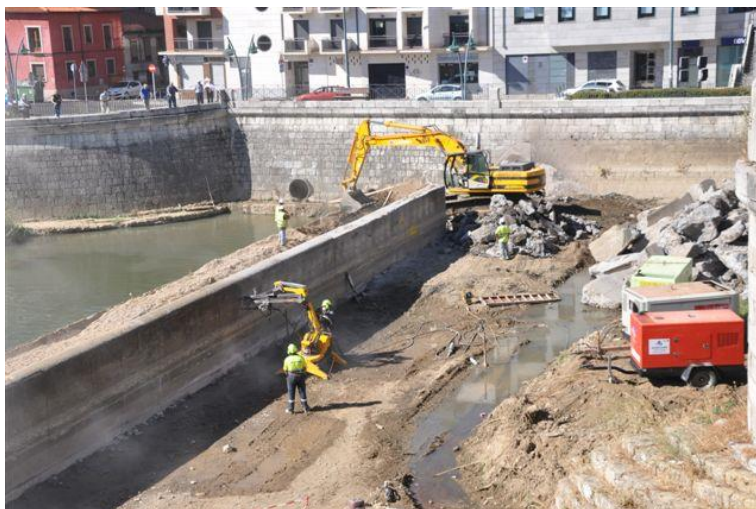
Obras de demolición parcial del azud de San Marcos (río Bernesga-León)
