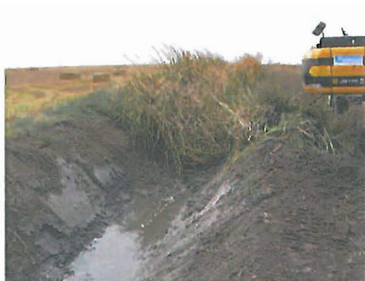
Ejecución de limpieza mediante medios mecánicos
