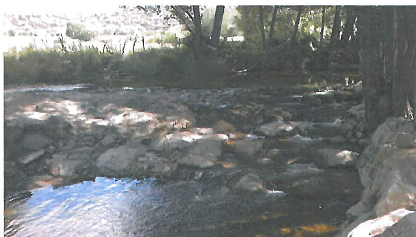
Rampa para peces construida en el azud de San Miguel. Fte: CHD
