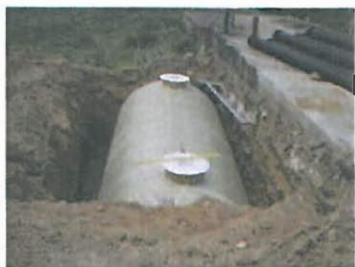
Fosa séptica prefabricada
