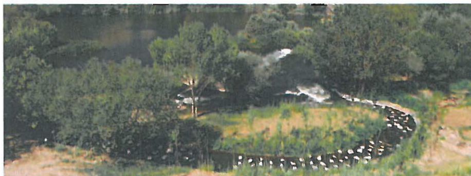
Rio artificial construido en el azud de El Marín en el río Tormes (Salamanca). Fte. CHD
