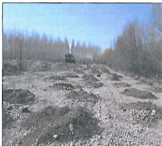
Plantación después del tendido del talud en el río Órbigo
