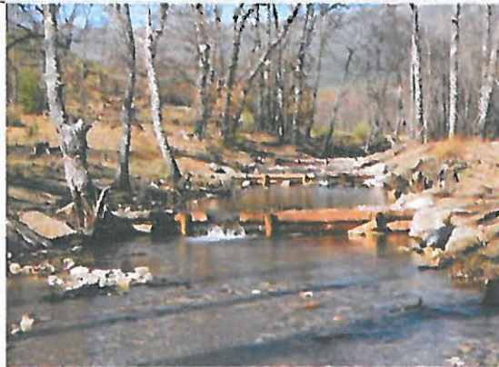
Arroyo Veganabos. Restauración de la "tabla" con tabiques de madera y vertedero lateral. Fte: CHD.
