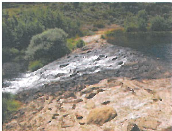
Construcción rampa piscícola en escollera de piedra en la presa de la Riberiña, río Negro (Zamora). Fte: CHD
