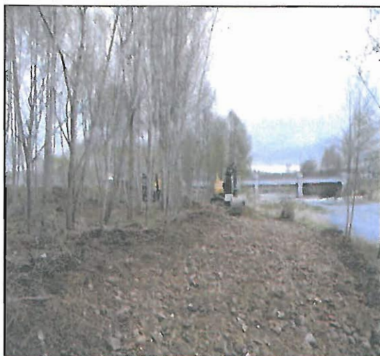
Acondicionamiento del talud previo a la plantación en el río Órbigo
