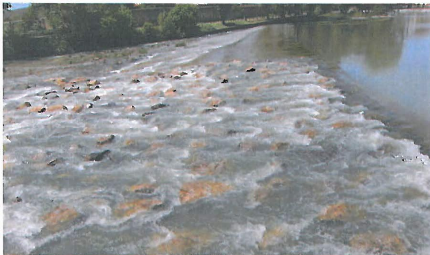
Permeabilización del azud de Aguilar de Campoo sobre el río Pisuegra, se realizó un rebaje de altura y un aumento de la rugosidad mediante rocas fijadas al azud. Fte: Infraeco
