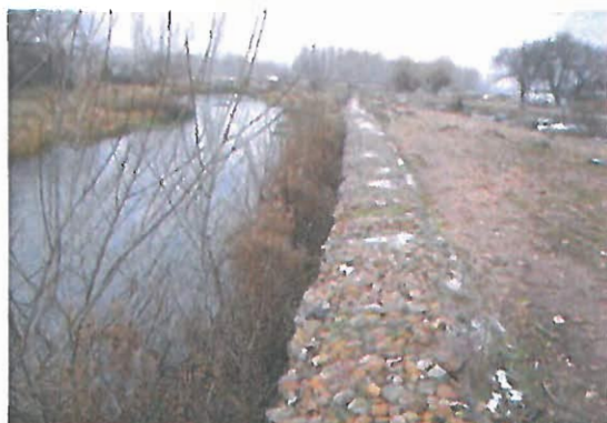
Vista de gavión y mota en el río Ucero
