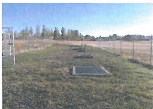
Fosa Séptica. Torreiglesias (Segovia)
