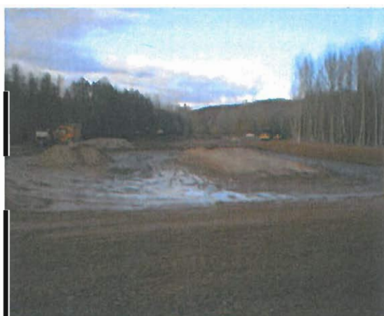
Vista donde se observa la retirada de la mota y la nueva mota ejecutada aguas arriba en el río Órbigo
