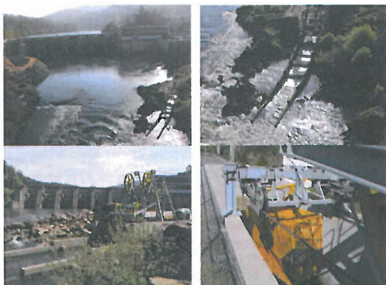
Fotografías de la presa de Frieira (Ourense) en donde se combina una escala de artesas con un ascensor para peces. Fte: Infraeco.
