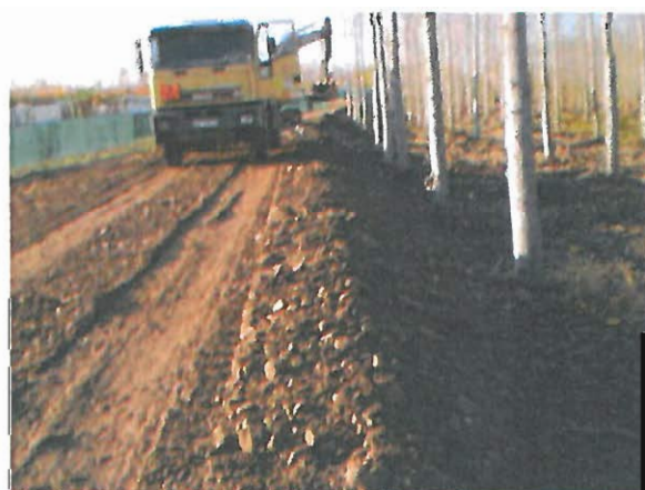
Trabajos de ejecución de la protección con coraza de la nueva mota en la inmediaciones del camping en el río Órbigo
