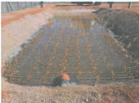
Laguna anaerobia con macrofitas en flotación
