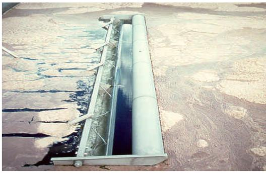
Un actuador tipo tornillo con un pequeño motor permite al decantador desplazarse verticalmente desde el nivel máximo hasta el nivel mínimo de agua. El motor dispone de un variador de frecuencia para adecuar la velocidad de descarga al ciclo con el que se esté trabajando (normal o de tormenta).
