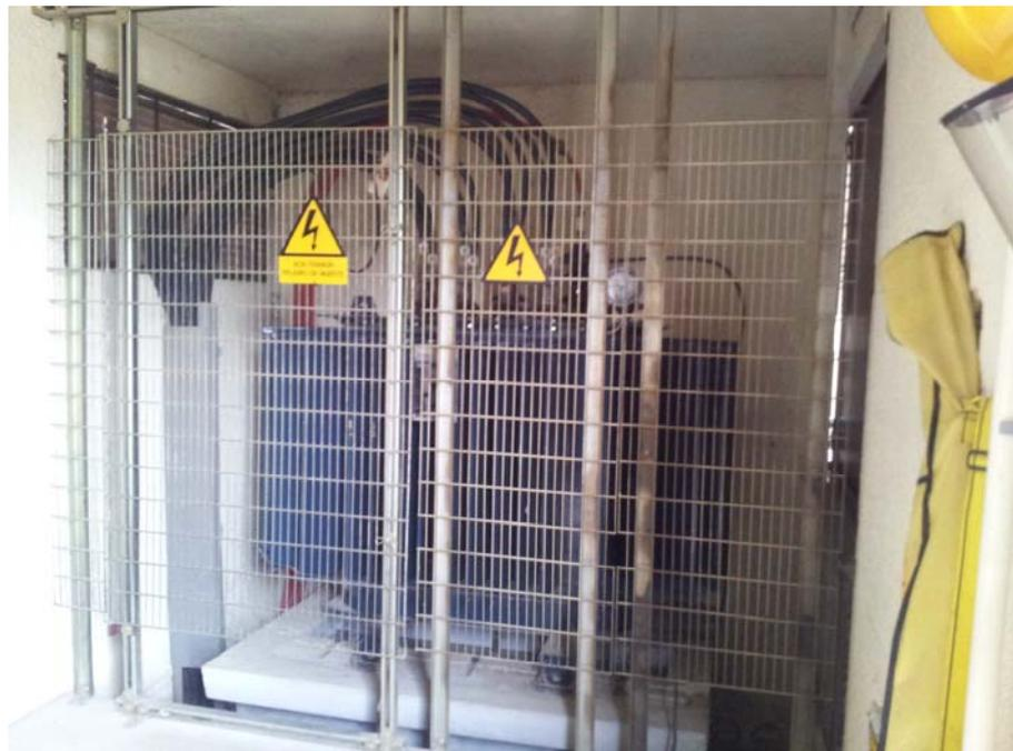
Figura 1. Transformador 630 KVA Existente.
