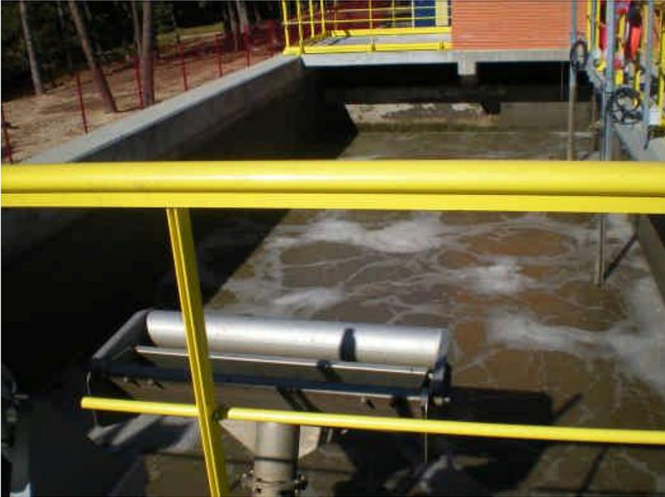
Se trata de un proceso biológico donde en cada reactor se alternan las fases de aireación, decantación y vaciado, como en un SBR, pero permitiendo la alimentación ininterrumpida de aguas residuales al reactor, lo que no puede hacerse en un proceso “por lotes”. La gran ventaja del proceso ABJ es que hace la función de:
