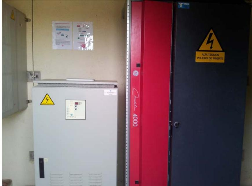
Figura 4. Equipo corrector de factor de potencia
