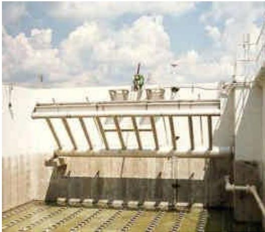
Este tipo de decantador-actuador permite extraer el agua clarificada manteniendo constantes el tiempo de decantación y el nivel mínimo de operación para permitir una operación estable del sistema. Esto se consigue gracias al actuador mecánico que puede llegar incluso a sumergir completamente el decantador para extraer el máximo caudal posible.
