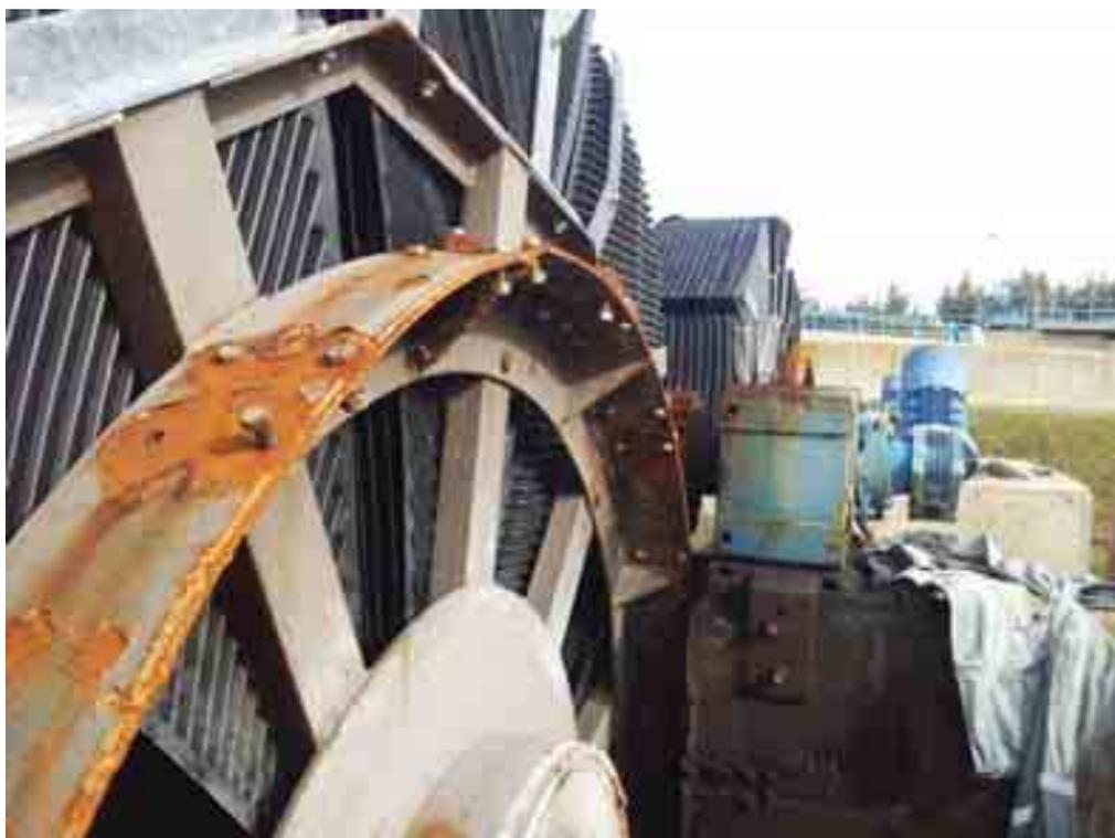
Detalle de desperfectos en sistema de accionamiento en biodiscos
