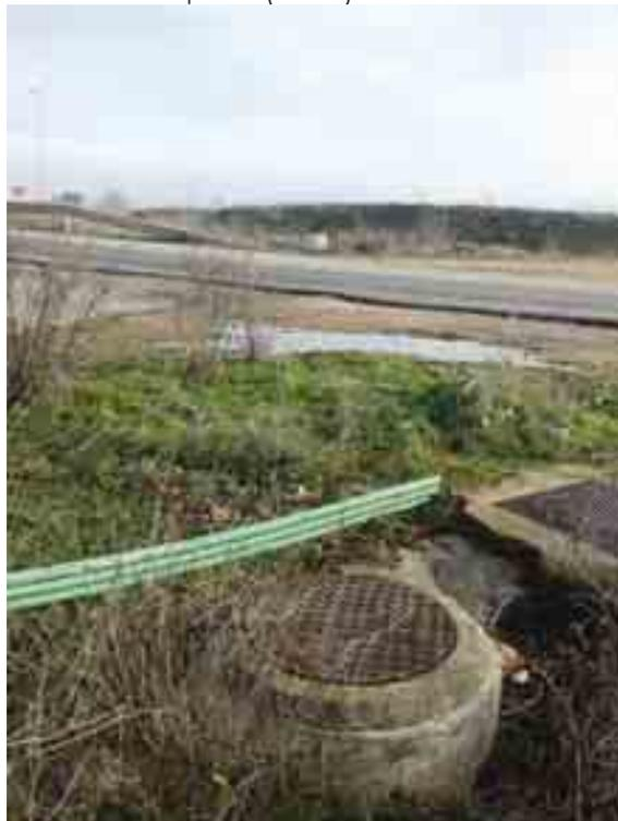
Pozo de entronque Colector de pluviales y de residuales a la salida de P.I.
