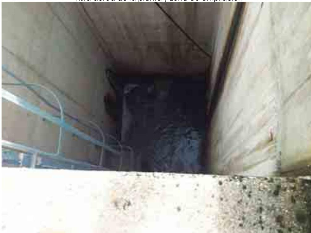
Obra de llegada. Colector de 800 mm común.
