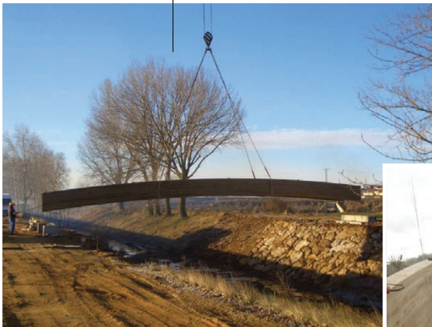
Montaje del tablero de la pasarela "in situ"
