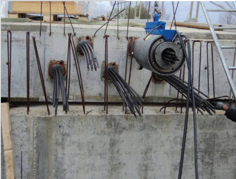
Tesado cables de acero
