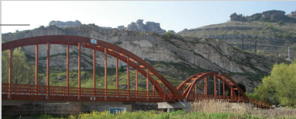
Vistas generales de la pasarela terminada
