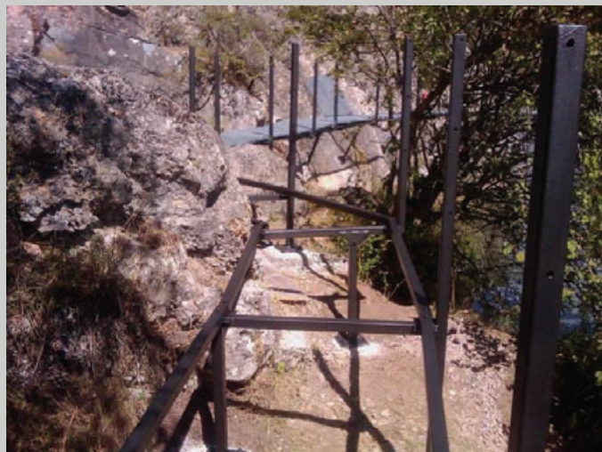
Perfiles metálicos colocados
