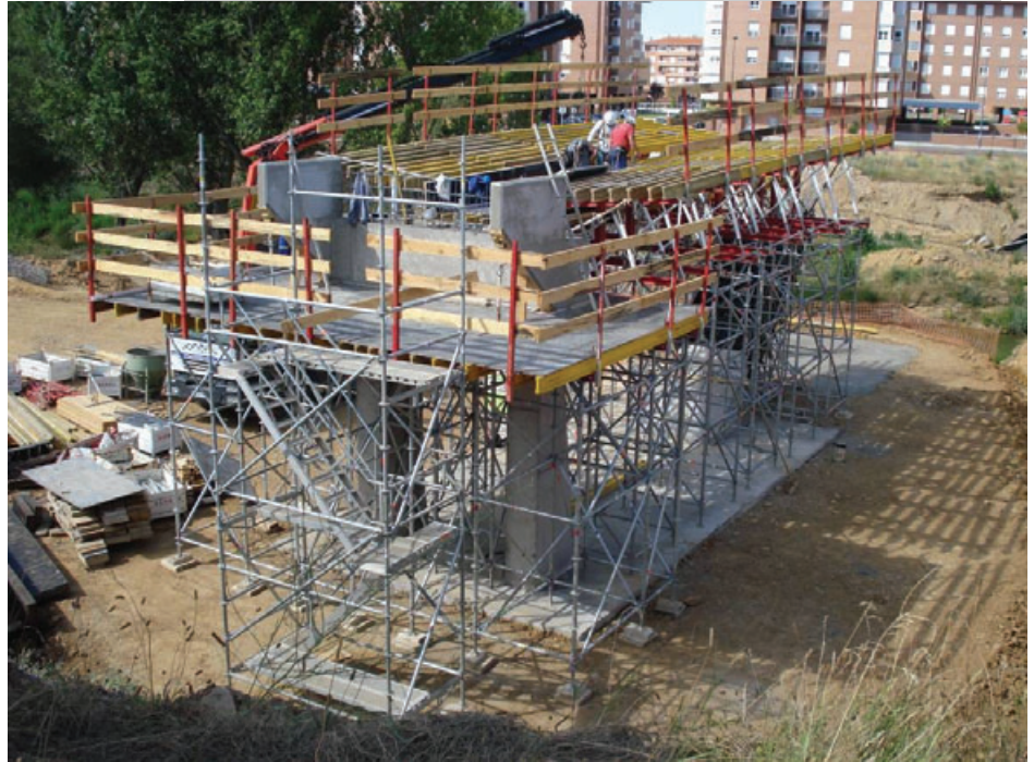
Ejecución Estribo y tablero margen izquierda
