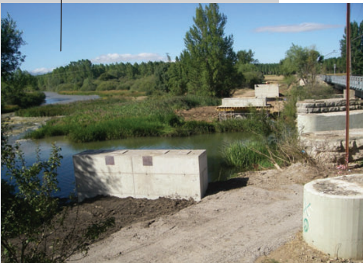
Cimentaciones de la pasarela vistas desde la margen izquierda
