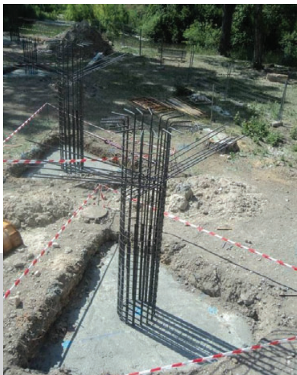
Armadura de las pilas
