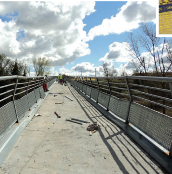
Hormigonado del tablero
