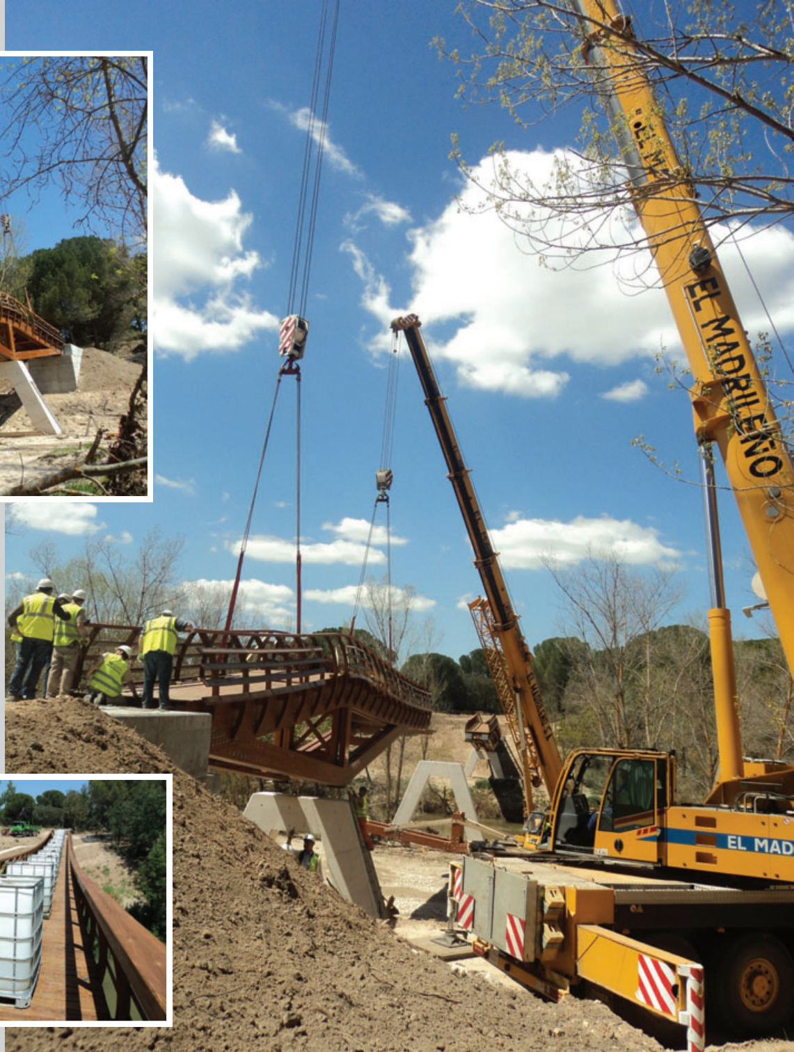
Prueba de carga estática
