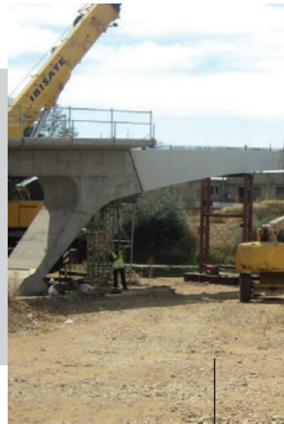
Colocación tramo metálico de la pasarela de aguas abajo
