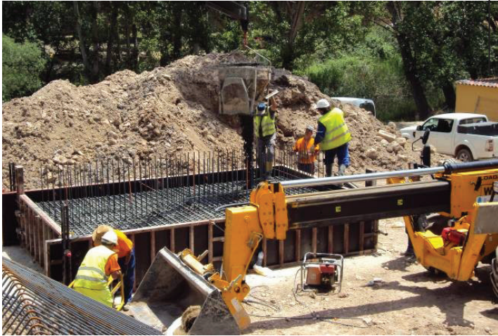
Zapata de apoyo en la margen derecha
