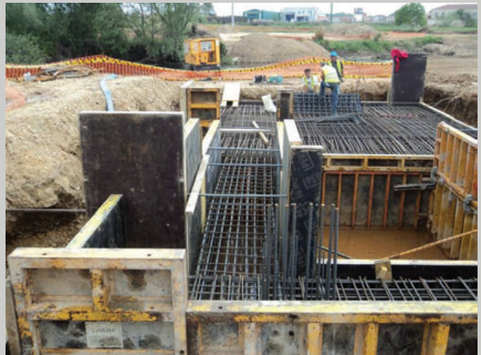
Ejecución de la zapata de la pasarela
