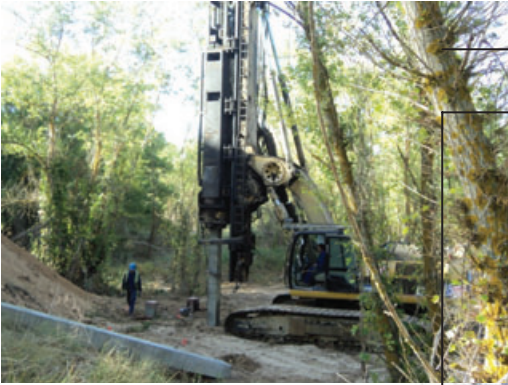
Pilotaje del estribo de la margen izquierda
