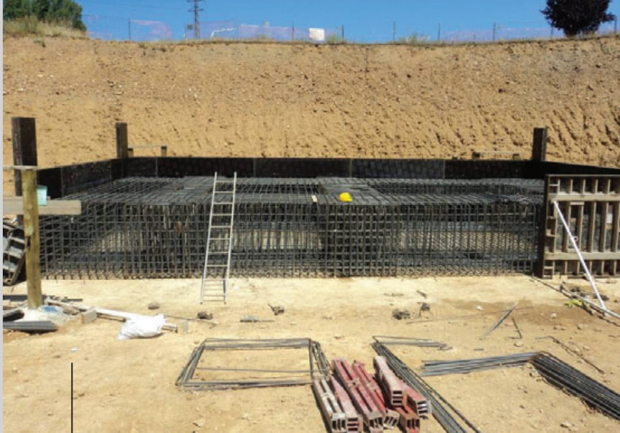
Zapata apoyo margen izquierda
