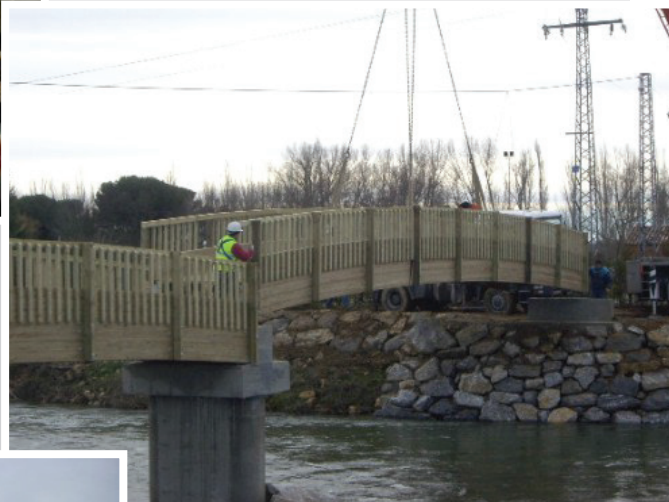
Posicionamiento del vano
