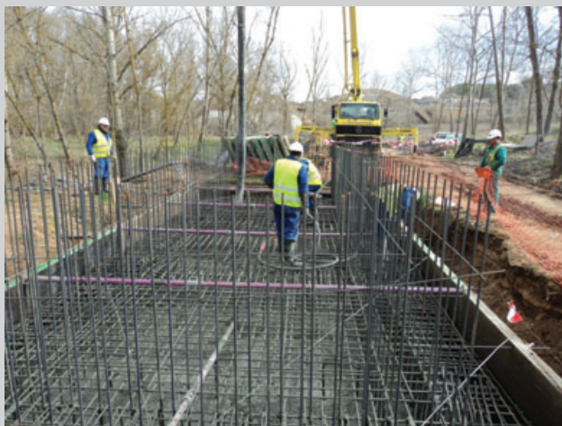
Hormigonado del encepado del estribo de la margen derecha
