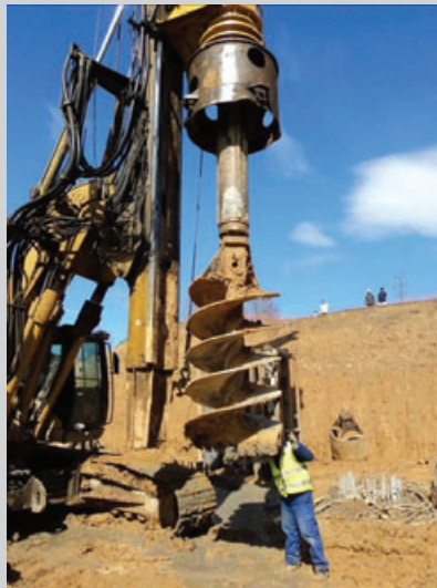
Perforación pilotes margen izquierda
