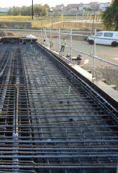
Ejecución del armado del tablero de la pasarela de aguas abajo
