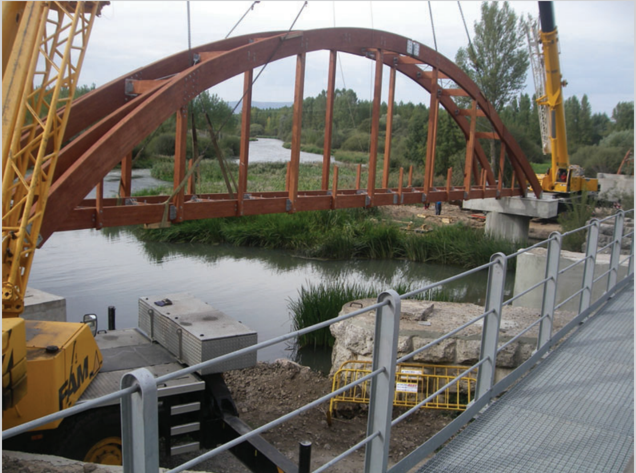
Colocación de uno de los arcos de la pasarela
