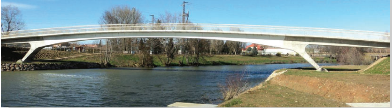
Vista general desde la margen izquierda de la pasarela de aguas abajo finalizada
