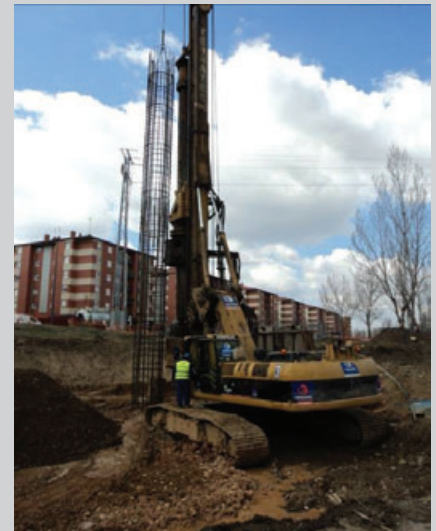
Ejecución armadura pilotes
