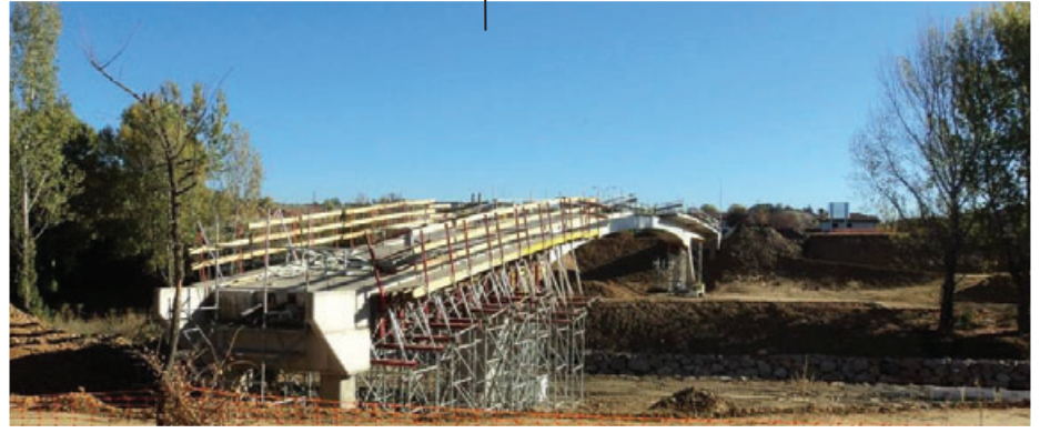
Pasarela con tablero hormigonado
