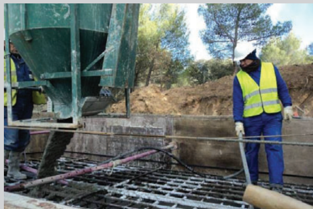
Hormigonado estribo margen izquierda
