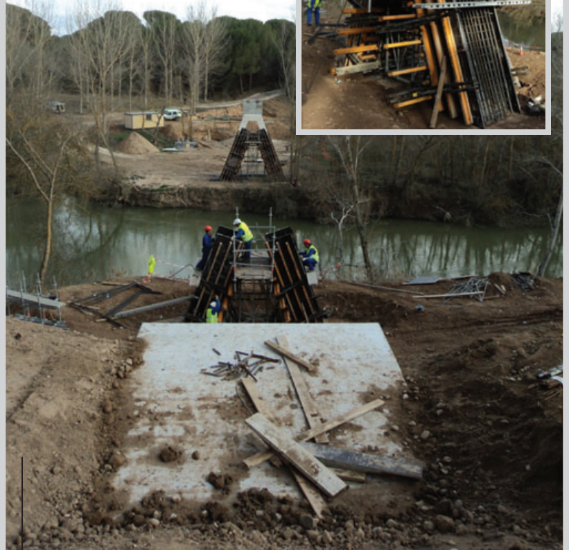
Alzados de las pilas y de los estribos desde la margen izquierda y detalle del armado y del encofrado de la pila de la margen derecha
