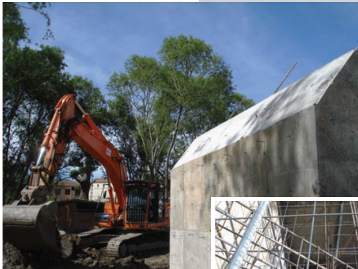
Zapata de la la margen izquierda de la pasarela ya hormigonada
