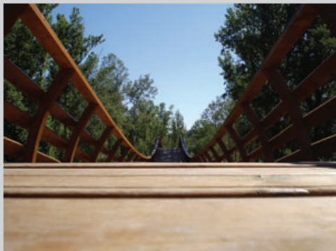
Vistas generales de la pasarela
