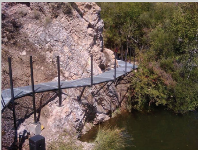
Pasarela con plataforma colocada
