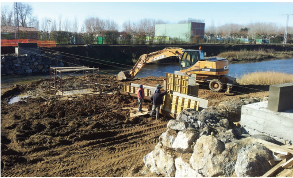
Construcción de los estribos y pila central
