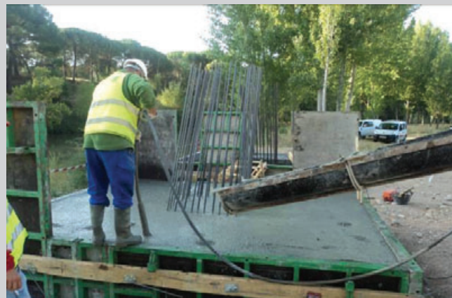
Hormigonado zapata margen derecha
