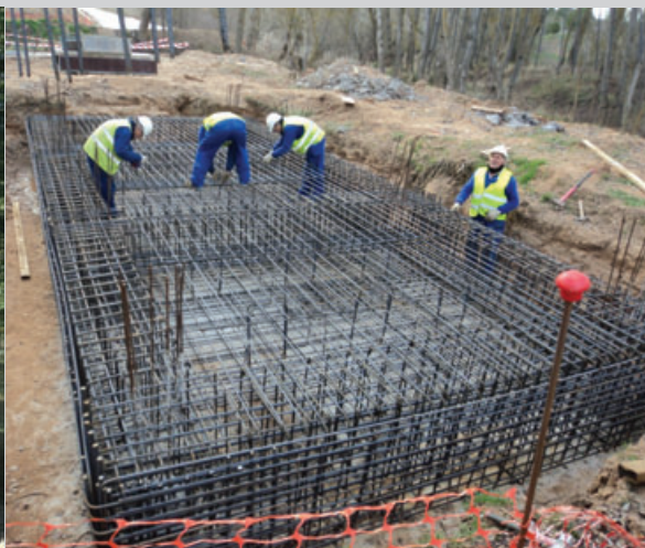
Armado del estribo de la margen derecha
