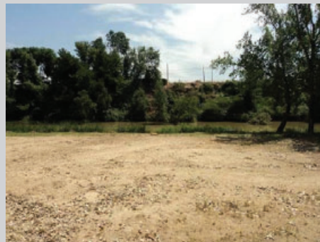
Inicio de la obra en la margen derecha
