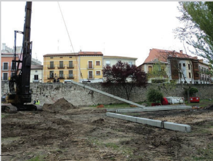
Ejecución de los pilotes
