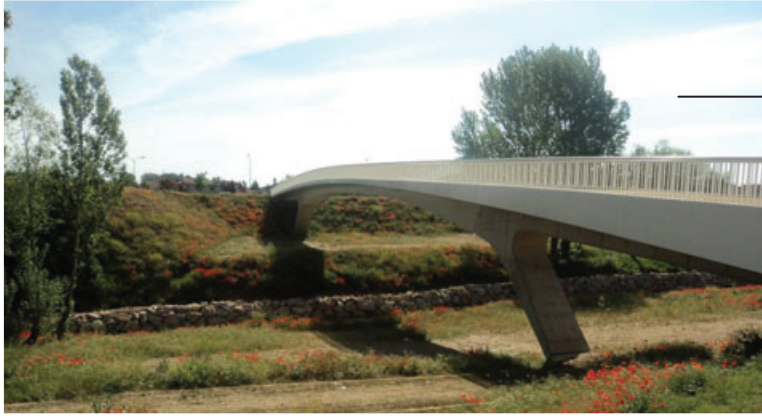
Vista general de la pasarela desde la margen derecha
