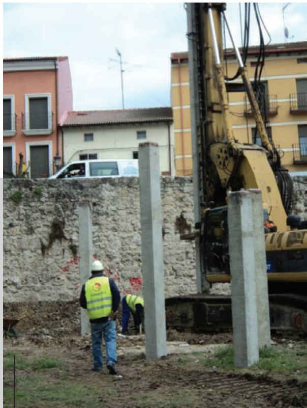
Pilotes hincados en el terreno
