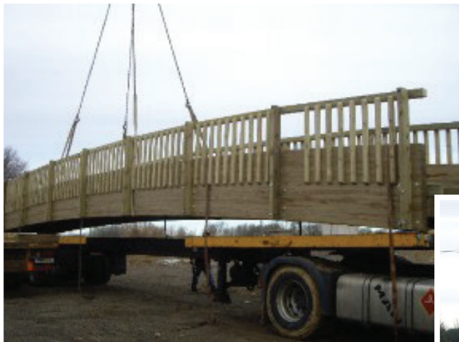
Transporte de una de las estructuras de la pasarela
