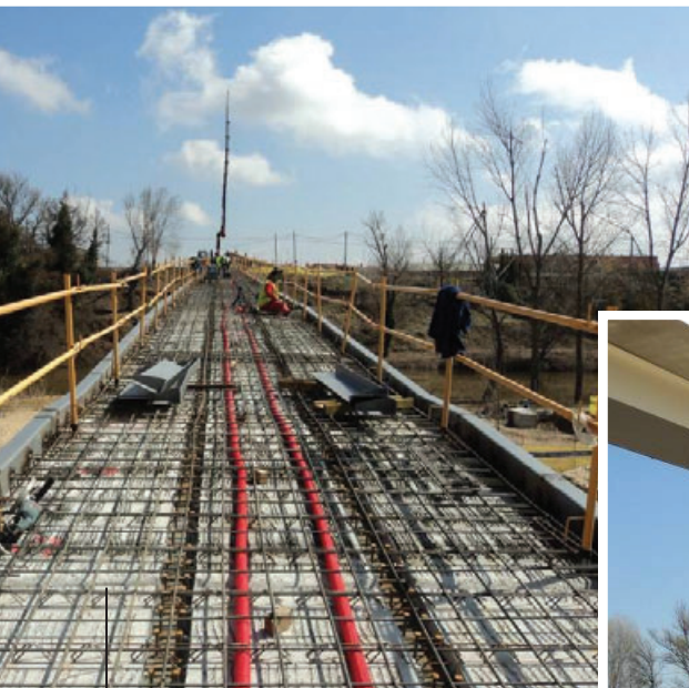
Prelosas y armado del tablero
