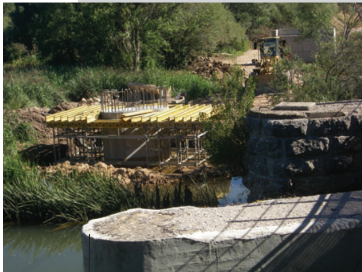
Ejecución del estribo de la margen derecha
