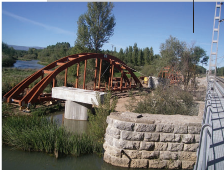
Preparación para la colocación de uno de los arcos de la pasarela
