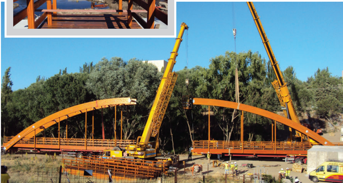
Vista de las maniobras de unión en obra de los dos tramos que componen la estructura de la pasarela
