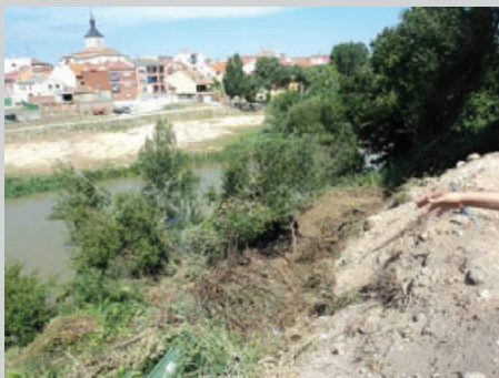
Inicio de la obra en la margen izquierda
