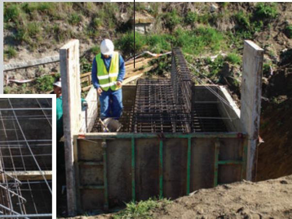
Detalle del armado de la pila de la rampa de acceso a la pasarela en la margen derecha
