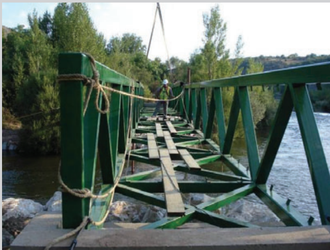
Operario supervisando colocación
