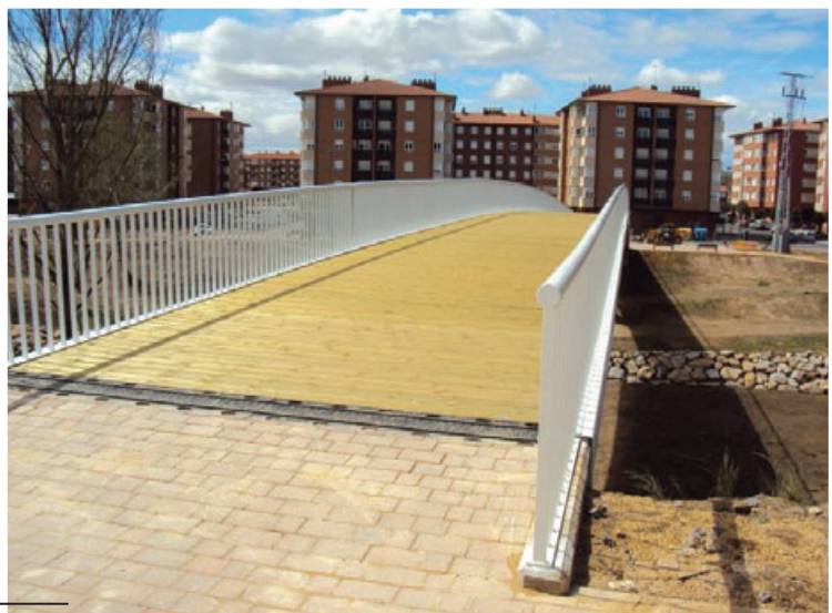
Vista de la pasarela finalizada desde el acceso de la margen izquierda
