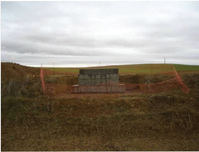
Vista general del estribo de margen derecha antes de protegerlo con escollera
