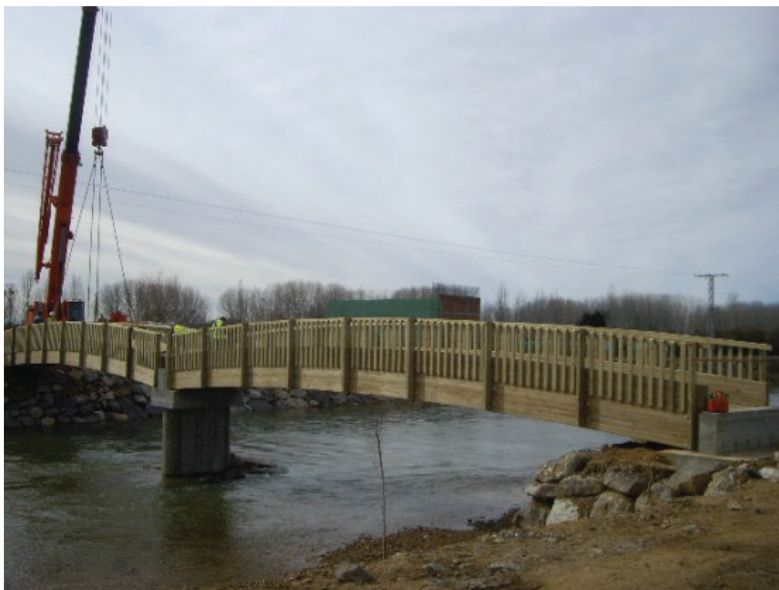
Colocación del vano y apoyo en estribo y pila
