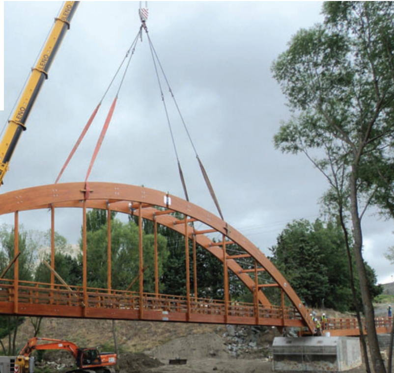
Alzado de la pasarela visto desde la margen izquierda del rio Adaja
