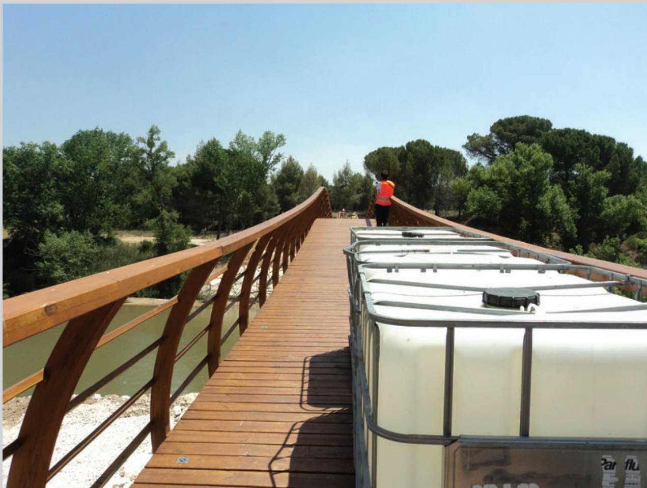
Colocación de los bidones de agua para la prueba de carga estática
