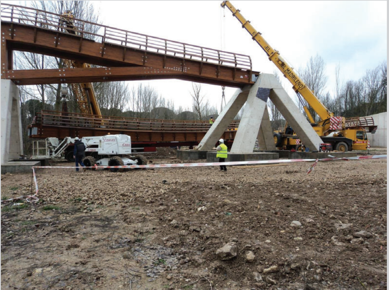
Colocación del tablero de la pasarela
