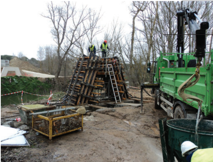
Encofrado del alzado de la pila de la pasarela de acceso en la margen derecho
