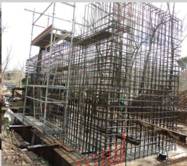
Armado del alzado del estribo de la margen derecha
