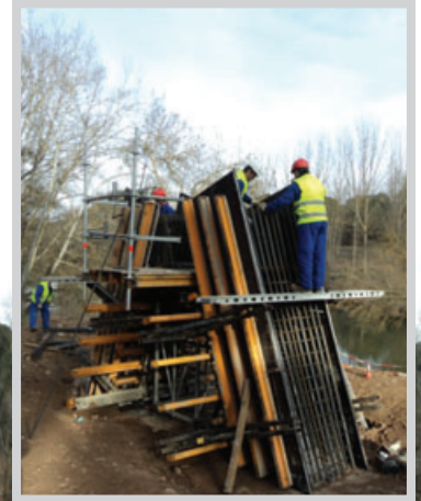
Armado del alzado del estribo de la margen izquierda
