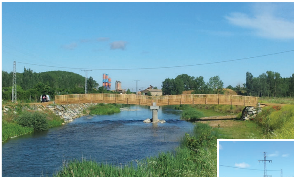
Vista frontal de la pasarela instalada
