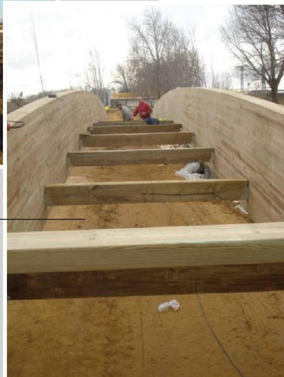
Alzado de la pasarela peatonal y colocación sobre los estribos
