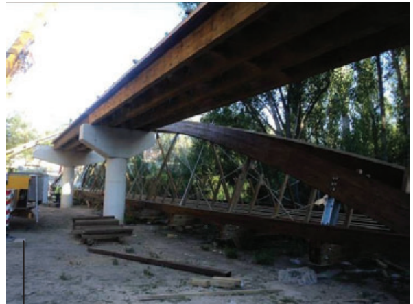
Colocación del tablero de la pasarela
