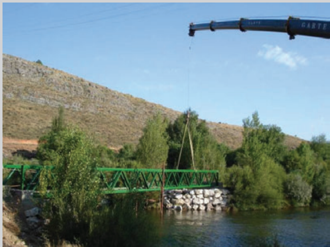
Colocación tramo metálico
