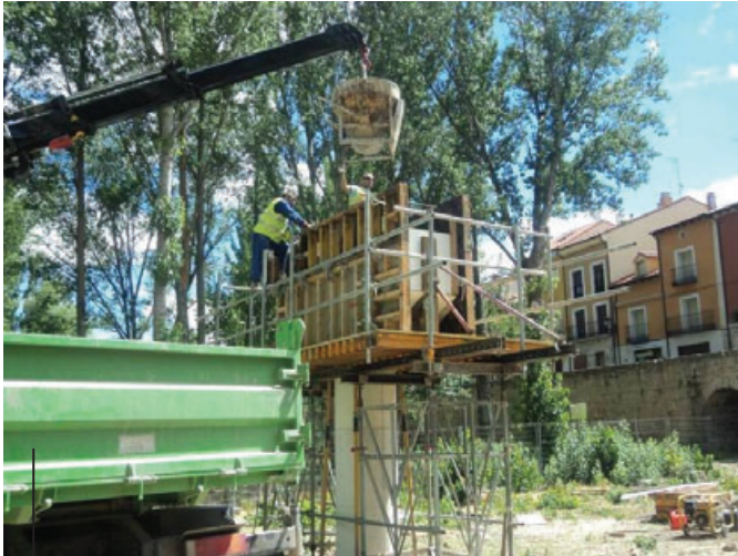
Ejecución del dintel de una pila en la margen derecha
