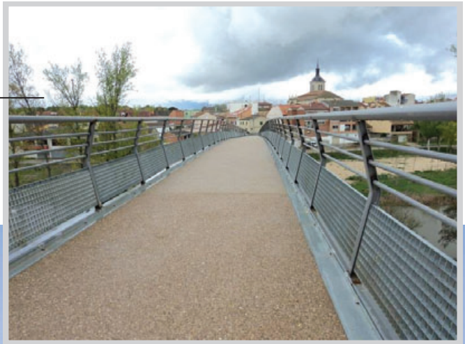
Detalle de la pasarela terminada desde la margen derecha
