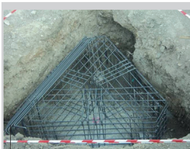
Zapatas de apoyo de las pilas
