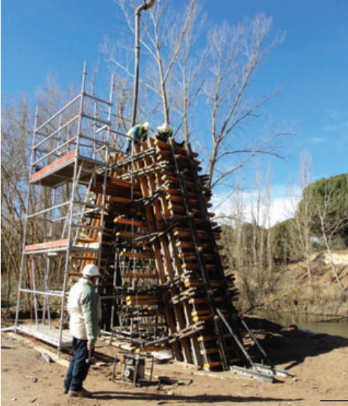
Alzados de las pilas y de los estribos desde la margen izquierda y detalle del armado y del encofrado de la pila de la margen derecha
