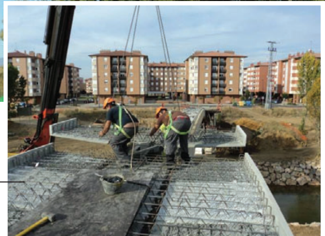
Colocación prelosas
