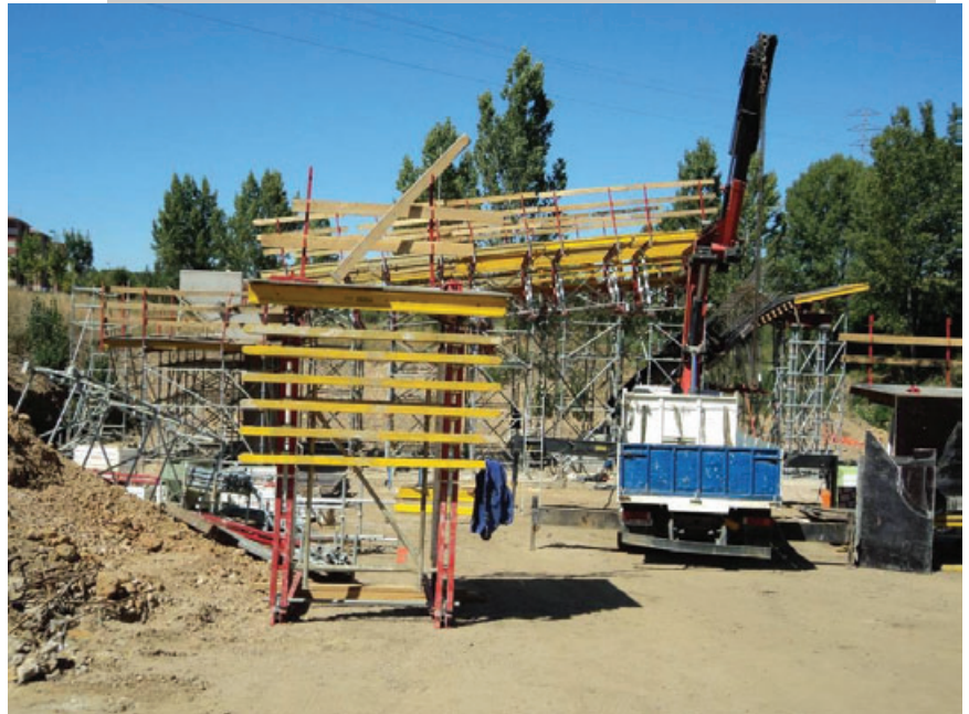
Ejecución Estribo y tablero apoyo margen derecha
