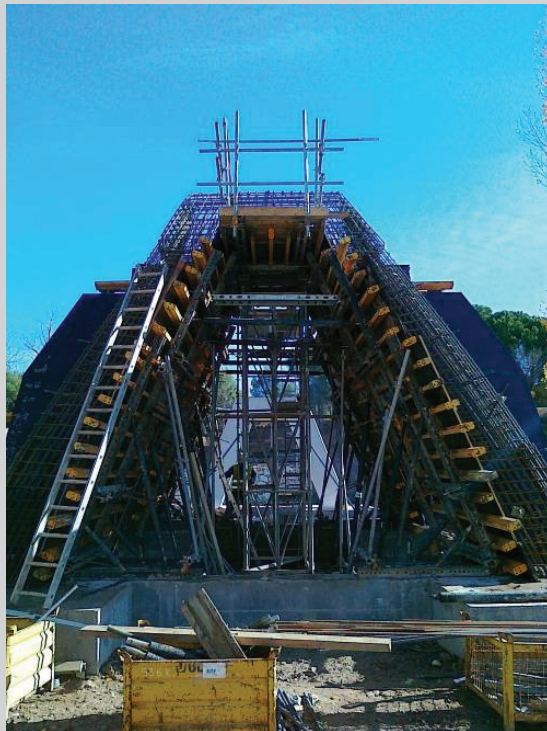
Armado alzado pila de la margen derecha
