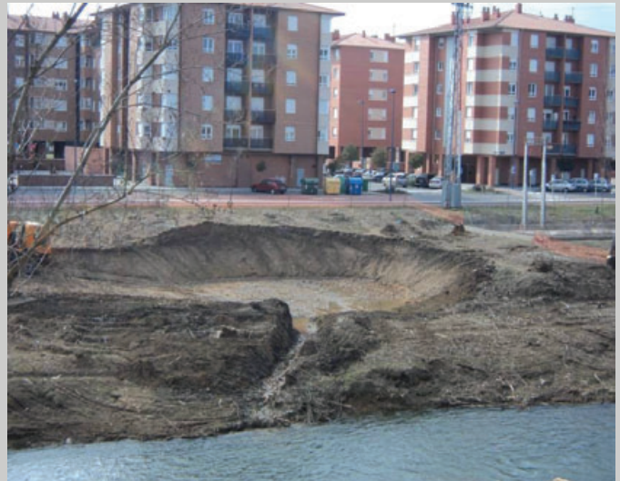
Excavación apoyo margen izquierda
