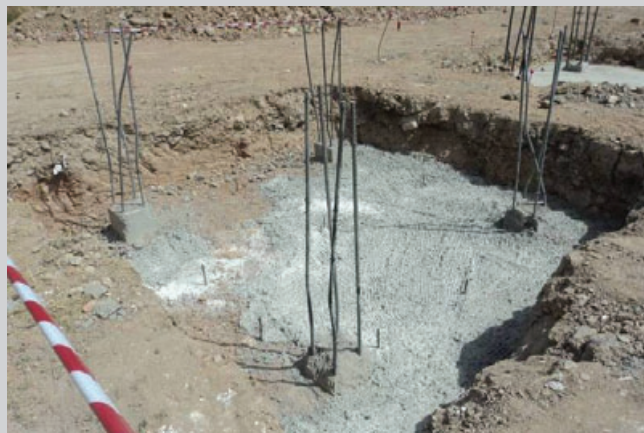
Pilotaje y hormigón de limpieza pila margen derecha
