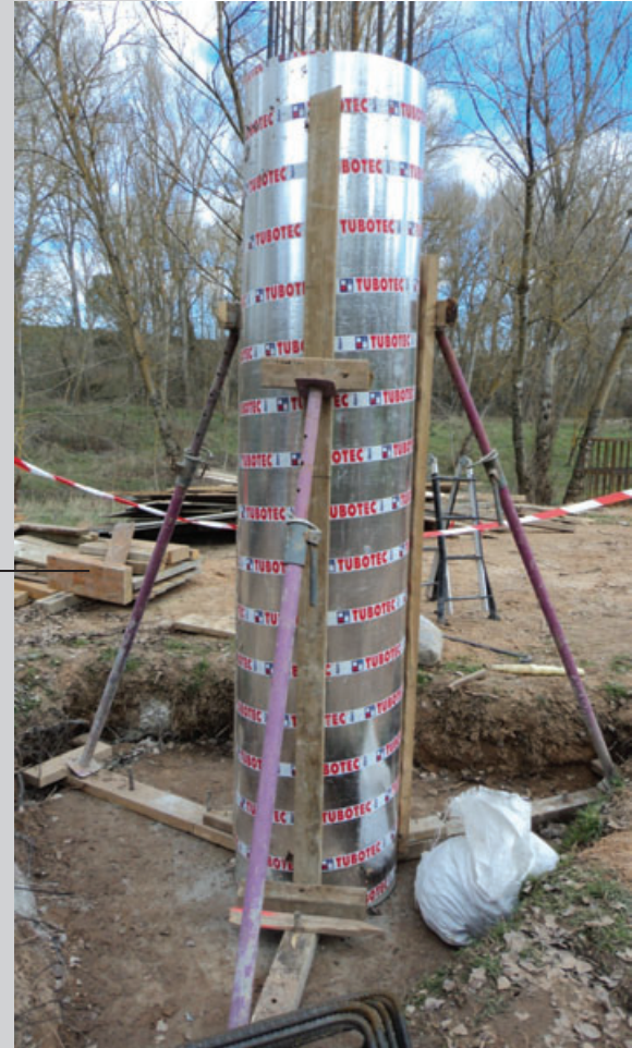
Encofrado del alzado de la pila de la pasarela de acceso en la margen derecho
