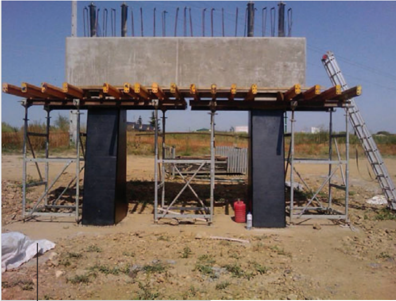
Ejecución del estribo de la pasarela de aguas arriba
