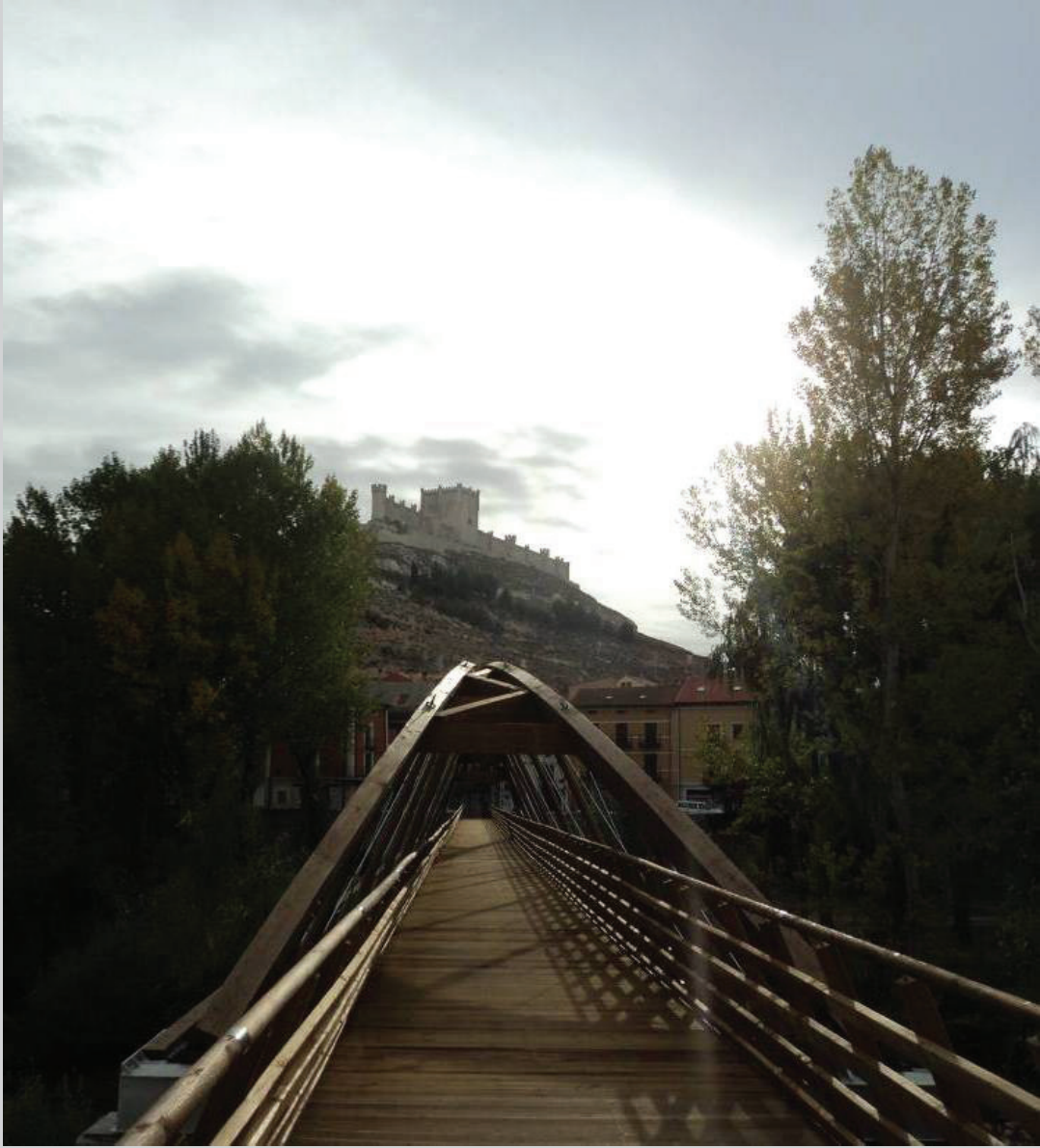
Vista general de la pasarela con el castillo de Peñafiel de fondo
