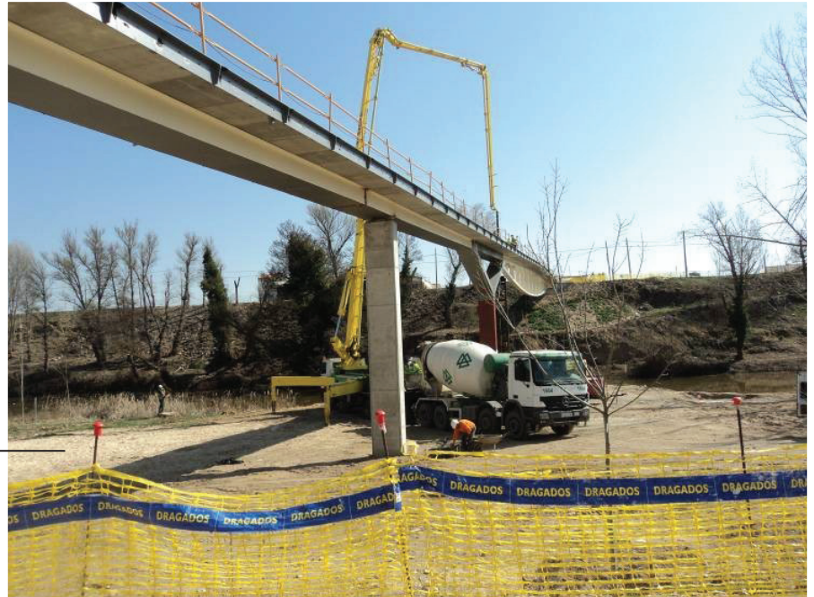
Hormigonado del tablero
