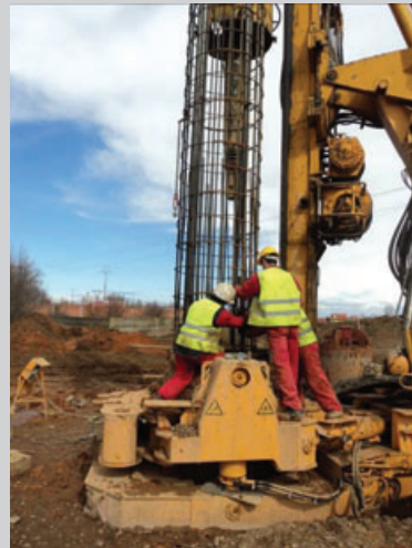
Colocación armadura pilotes
