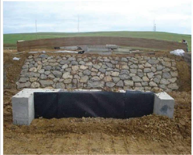
Estribos con trasdós impermeabilizado y protegidos con escollera
