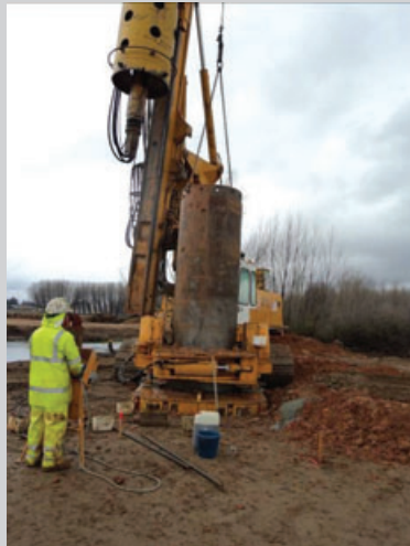
Ejecución de los pilotes
