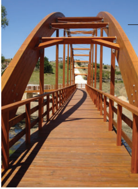
Detalle del arco de la pasarela con la subida a los Cuatro Postes de fondo
