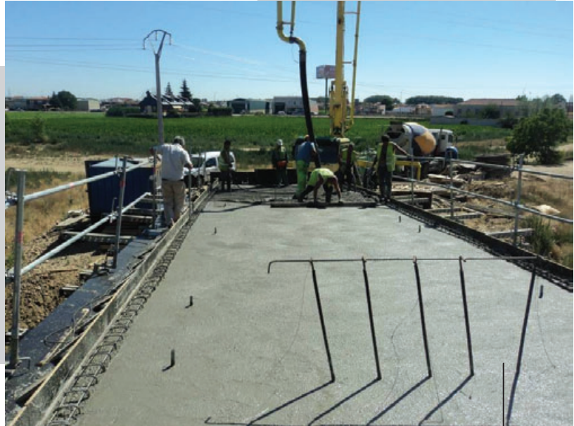
Hormigonado del tablero de la pasarela de aguas abajo
