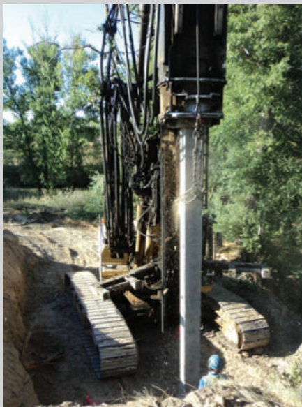
Pilotaje en la margen izquierda
