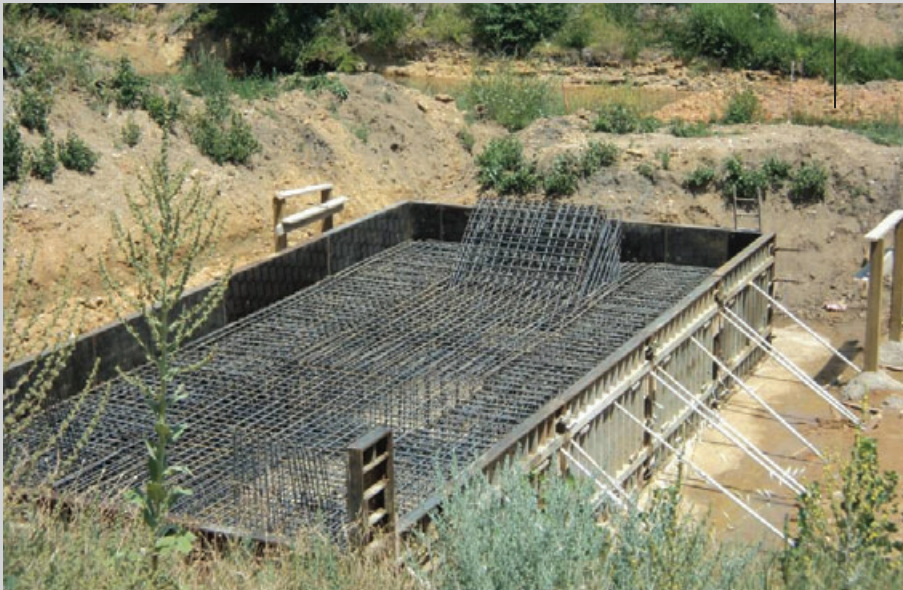
Zapata apoyo margen derecha
