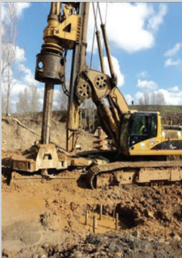
Perforación pilotes margen derecha
