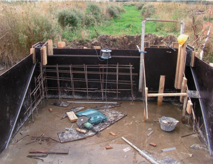
11-9-2008. Encofrado y hormigonado del azud del arroyo Cubillo.
