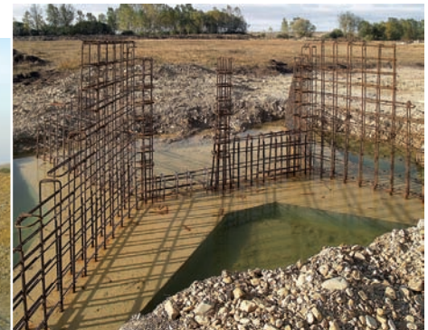
20-9-2007. Armazón de acero corrugado para la estructura de regulación de la laguna 3. Dos fases.
