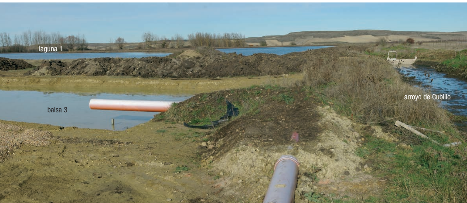
2-6-2009. Plantación de helófitos en las balsas de gravas.
