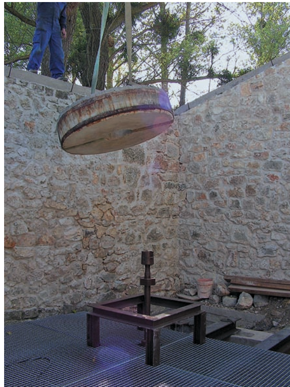
Restauración del mecanismo hidráulico de molienda.
