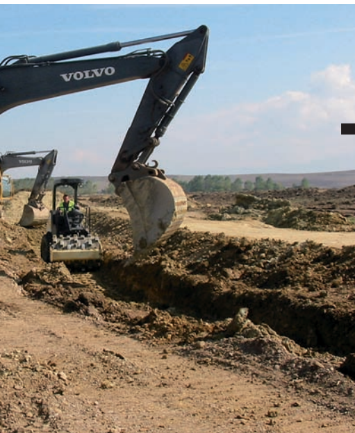
Pata de cabra compactando y amasando las capas de arcilla dentro del tación.
