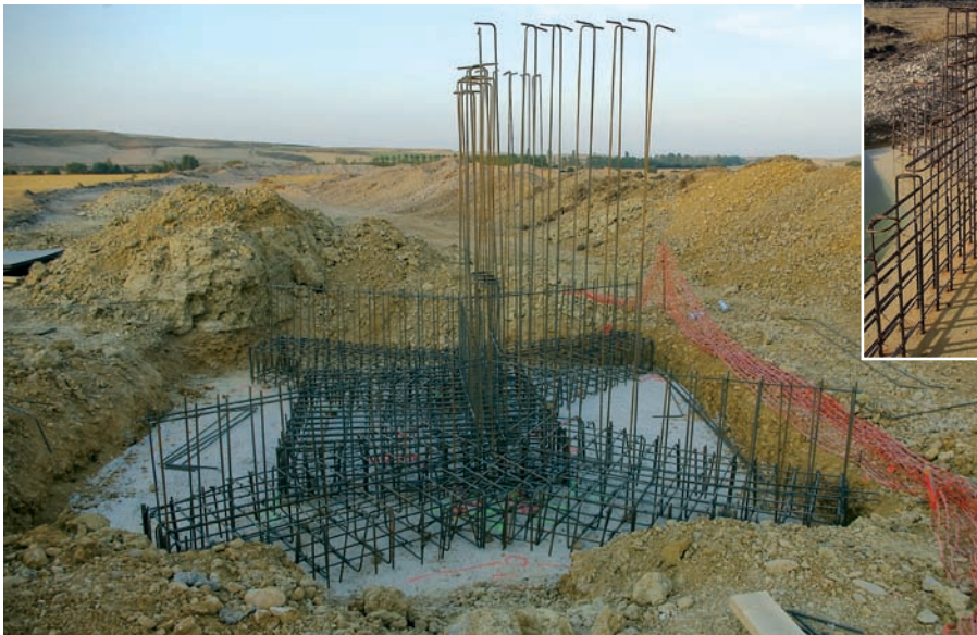
20-9-2007. Armazón de acero corrugado para la estructura de regulación de la laguna 3. Dos fases.
