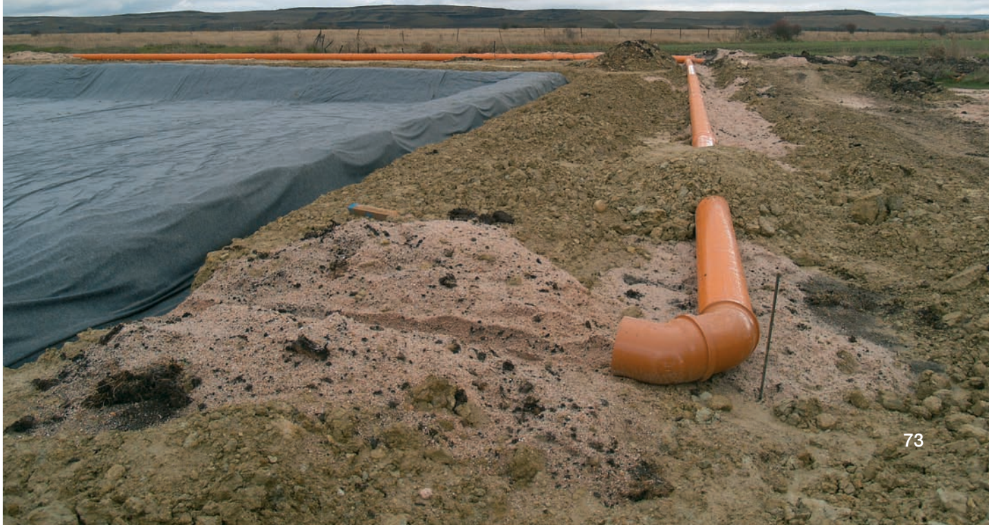
Diferentes momentos de la construcción del colector que llega a la fitodepuradora.
