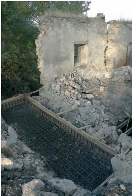
Cimiento del muro oeste.
