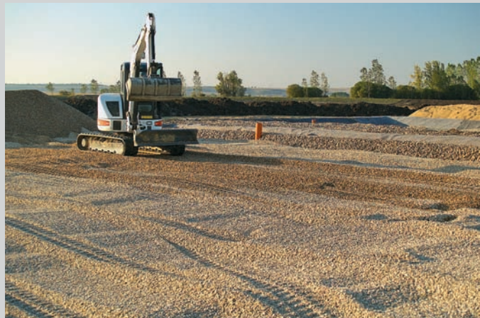
10-10-2008. Extendiendo el relleno granular.
