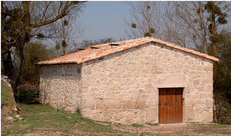
Caz del molino tras las obras de limpieza y adecuación.
