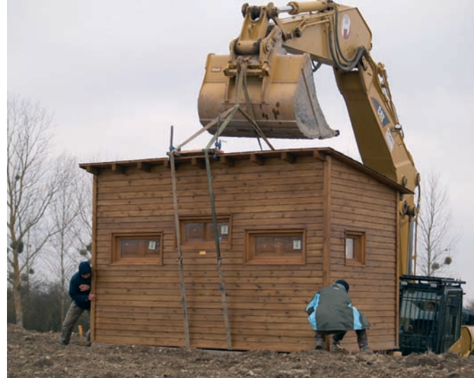
Distintas fases de la colocación del observatorio nº 2 sobre la solera de hormigón.
