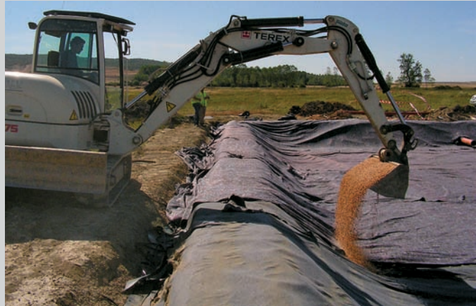
10-10-2008. Extendiendo el relleno granular.
