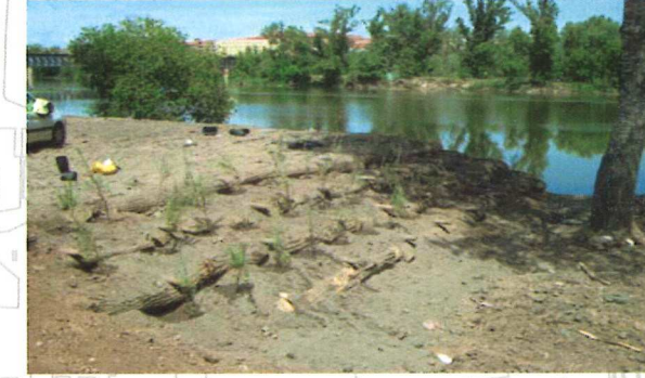
Obras de bioingeniería (muro Krainer)
