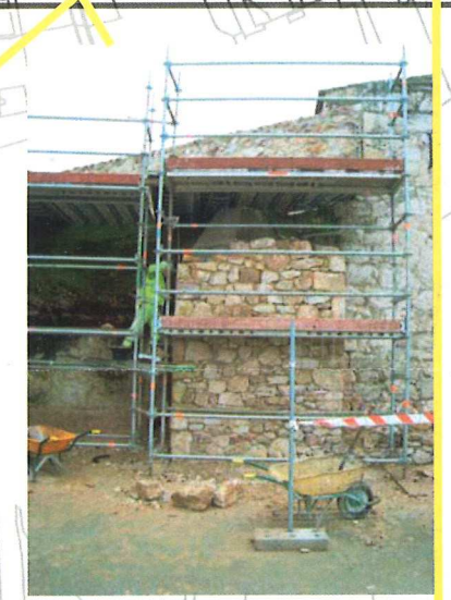
Adecuación de colector
