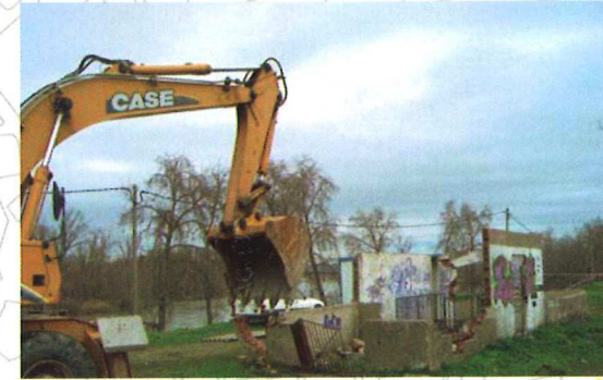
Derribo de antigua báscula
