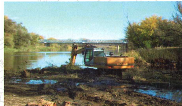
Retirada de sedimentos del cauce
