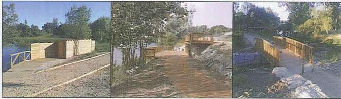
Como solución a la diferencia de cota existente, se ha construido, junto al antiguo muro de sillería del Molino de La Moral, una plataforma peatonal sustentada por pilotes de altura variable, formada por un entarimado de traviesas de pino y barandilla de postes verticales unidos por cuatro cables de acero equidistantes dispuestos horizontalmente. Toda la estructura se ha ejecutado en madera de pino de Soria tratada en autoclave.
