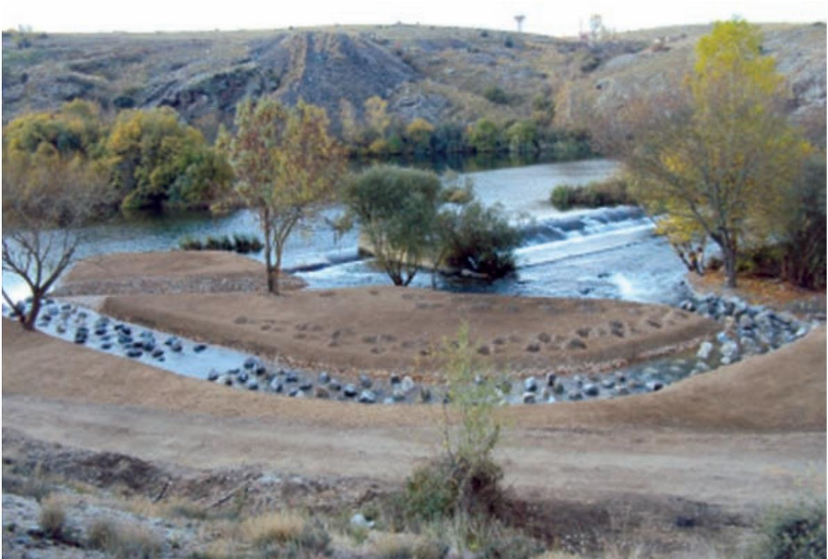
SA-0222 Construcción de un río artificial para el paso de peces en el azud de "El Marín" en el cauce del río Tormes. Salamanca.
