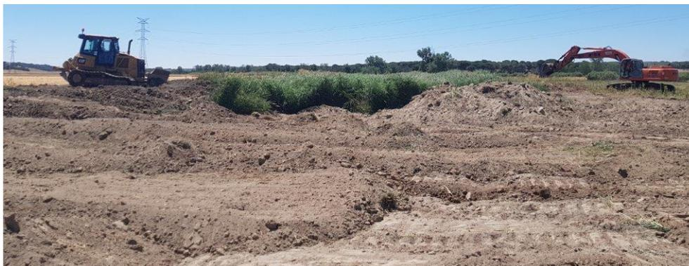
Eliminación de mota y vertido de la misma en el cauce del río Zapardiel. Estos ríos de llanura, muy transformados por todo tipo de presiones (extracciones de aguas superficiales y subterráneas, canalizaciones, dragados, ocupación por cultivos de las zonas inundables...) no reciben la atención debida, ya que tienen un potencial muy grande de laminación de avenidas recuperando parte de sus llanuras de inundación, así como la recuperación de hábitats fluviales y parafluviales de gran interés
