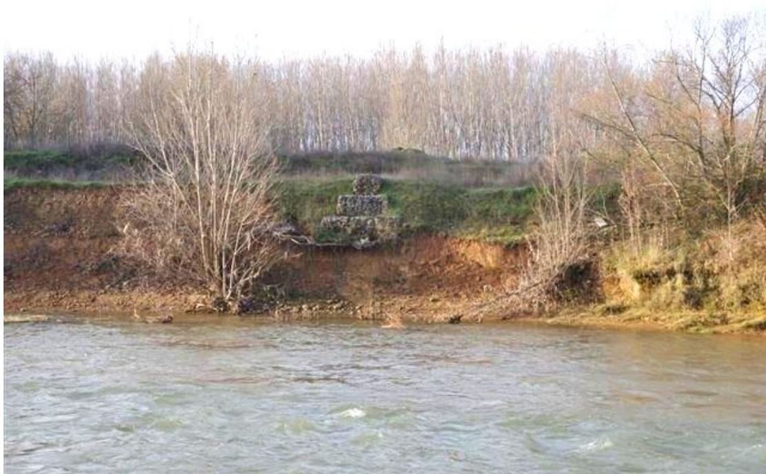
Incisión acelerada en el río Bernesga. La foto es muy elocuente ya que se observa un gavión que se construyó por debajo del lecho original, cuando ya se había producido una incisión notable, que ha quedado colgado ya que el río sigue incidiendo excavando las arcillas infrayacentes al aluvial de gravas y cantos rodados
