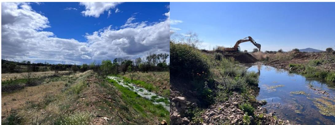
Cauce del Castrón canalizado y con mota y obras de inyección de sedimentos procedentes de la mota
