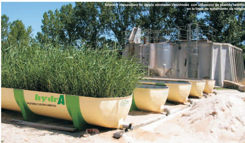
Estación depuradora de aguas residuales industriales con utilización de plantas helófitas en la línea de tratamiento de fangos.
