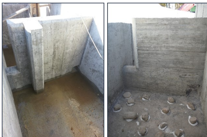
Figura 83. Lecho sin naturalizar (izquierda) y naturalizado mediante la fijación de piedras (derecha).
