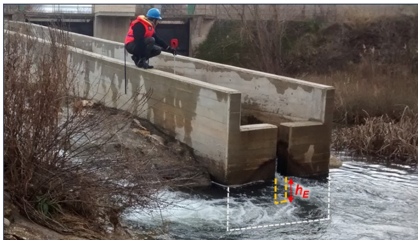
Figura 12. Esquematización de la profundidad en la entrada, donde en amarillo se representa el umbral del vertedero de entrada y en rojo la variable.
