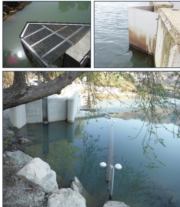
Figura 87. Ejemplos de diferentes elementos contra la entrada de elementos arrastrados por la corriente dentro de una escala.
