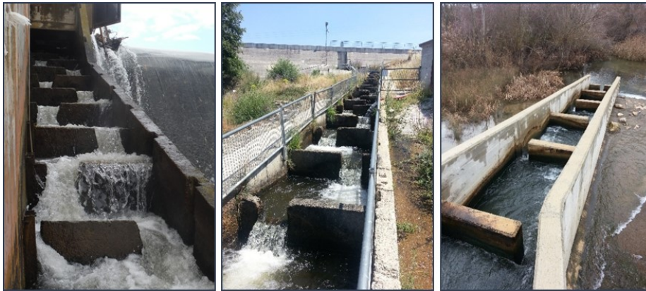
Figura 85. Escalas con diferentes tipos de resguardos laterales: demasiado reducidos (izquierda), inicialmente insuficientes, aunque solucionado mediante la posterior colocación de vallas (centro) y suficientemente grandes (derecha).
