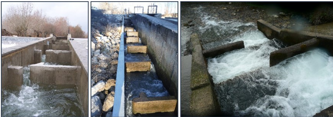
Figura 34. Elementos que conectan estanques con diferentes anchuras: hendiduras de 20 cm (izquierda), vertederos sumergidos también de 20 cm (centro) y vertederos libres de 133 cm de ancho (derecha).
