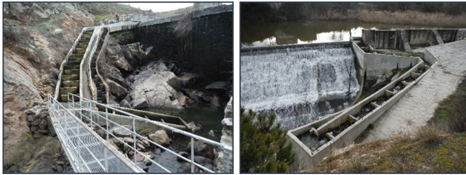
Figura 79. Pasarela (izquierda) y rampa en hormigón (derecha) que facilitan el acceso a dos pasos piscícolas.
