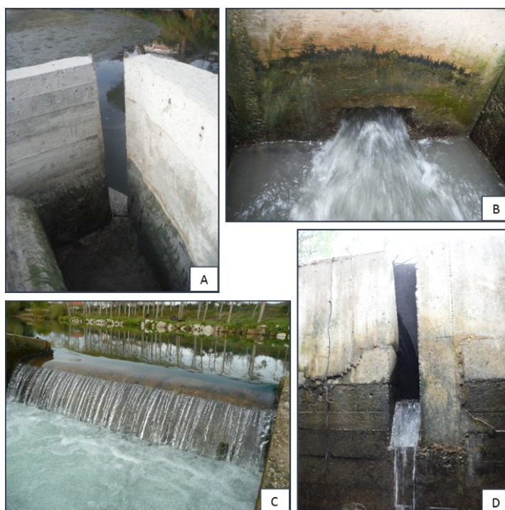
Figura 51. Tipos de salidas más frecuentes: hendidura vertical (A), orificio (B), vertedero libre (C) y vertedero sumergido (D).
