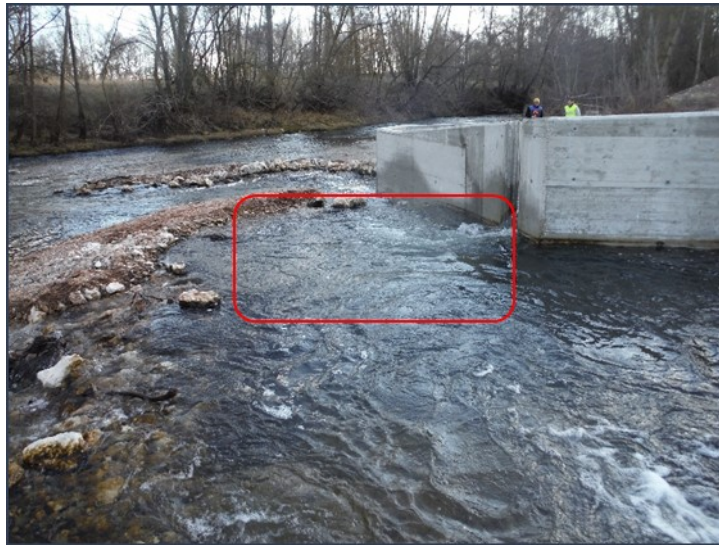
Figura 18. Vista de la poza que existe en el río antes de la entrada (en rojo) de una escala.
