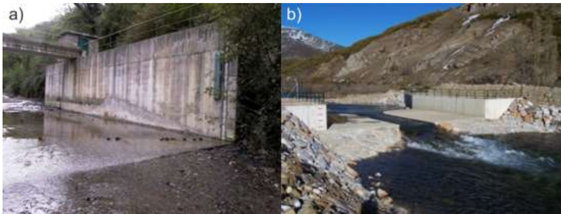
Figura 19. Cambio de estaciones tipo V-Flat por canal rectangular con vertido libre: Regata de Zebería, en la cuenca Bidasoa (a), y río Carrión en Triollo, Palencia (b).
