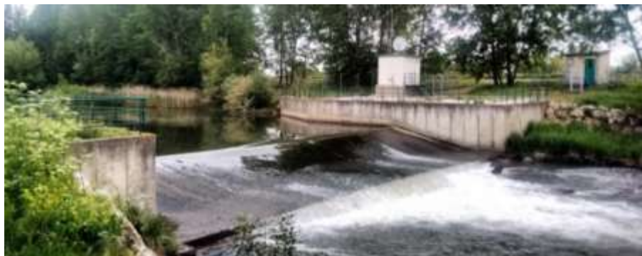
Figura 1. Estación de aforo V-Flat con descalce en el río Carrión en Villoldo, Palencia.
