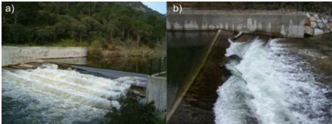
Figura 17. Colocación de deflectores sobre el paramento de aguas abajo: río Cofio, Toledo (a) ( http://saihtajo.chtajo.es ), y río Carrión en Velilla del Río Carrión, Palencia (b).
