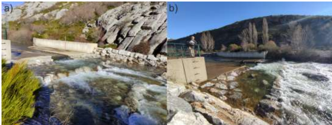
Figura 21. Construcción de prepresas para reducir el salto provocado por el descalce en la estación de aforos de Cardaño (a) y Triollo (b) (Palencia).
