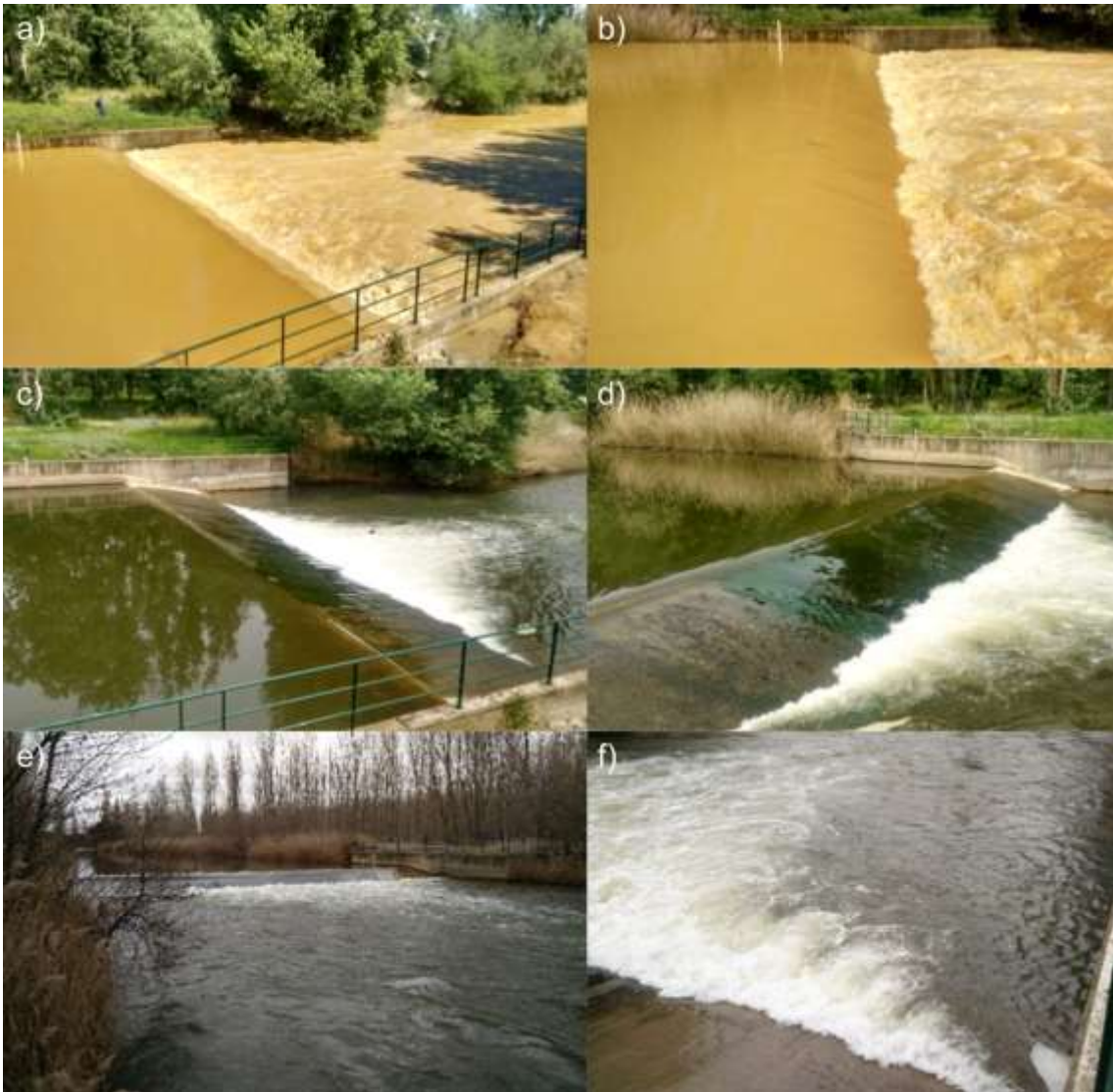
Figura 25. Vista de la estación de aforo en la que se observa el resalto hidráulico que se produce en el paramento y la distancia de nado con caudales altos (a y b) y con caudales bajos (c y d). Transición entre el lecho de la estructura y del río aguas abajo de la misma sin que se observe descalce (e y f).
