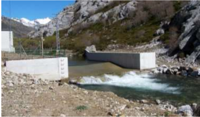
Figura 3. Estación de aforo V-Flat en el río Cardaño (Palencia), donde son patentes varios de los problemas de este sistema (descalce, profundidad insuficiente en el paramento, etc.) (actualmente modificada).
