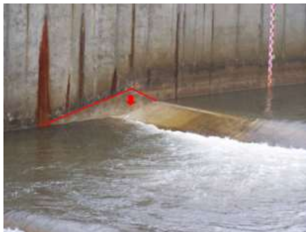
Figura 15. Rebaje de 0,30 m en la altura del vertedero V-Flat (marca del antiguo vertedero sobre la pared en rojo).
