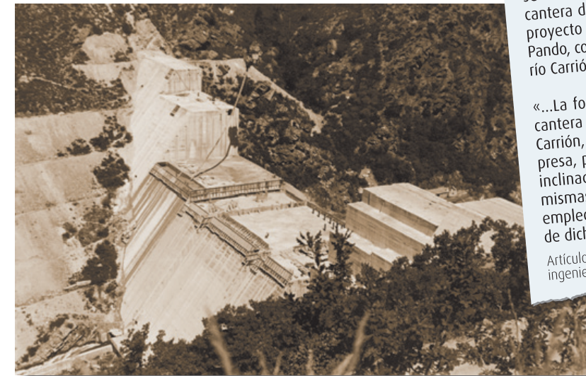
◀ Vista margen izquierda de la presa. Agosto 1957.
