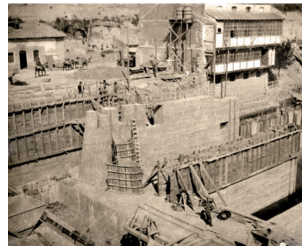
Preparando encofrados en el estribo izquierdo. Nótese el transporte de la época arriba a la izquierda.
