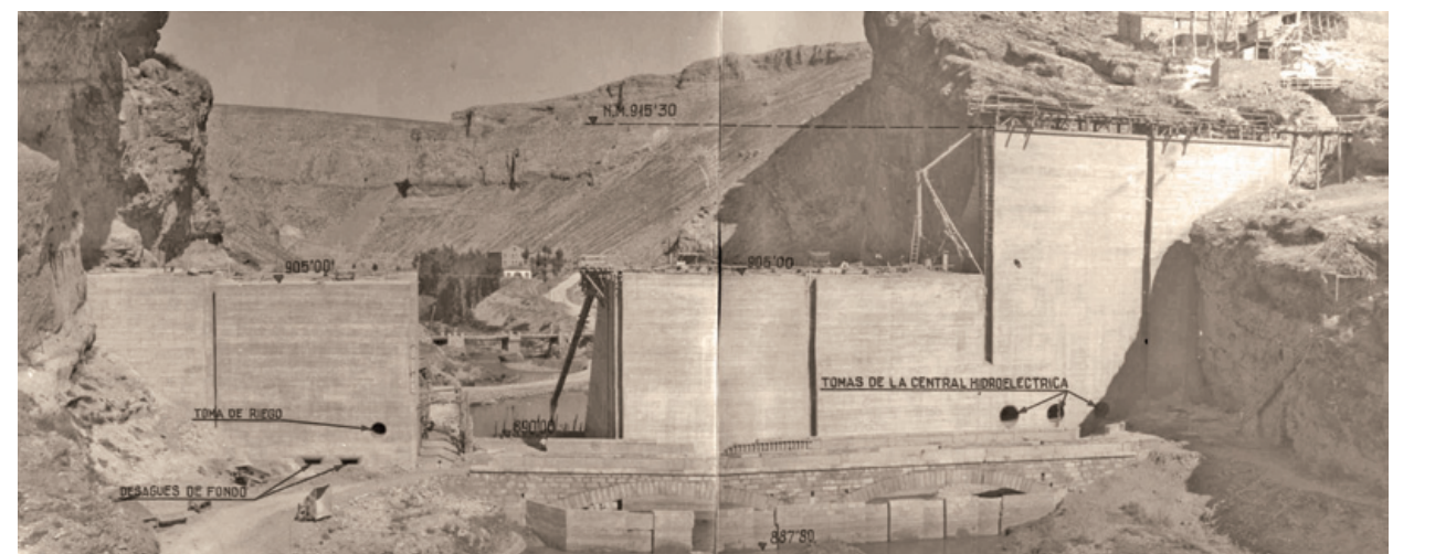
Foto de 1948 con anotaciones sobre la presa ▼
