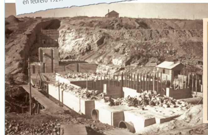
▲ Colocación de los desagües de fondo (1932).
