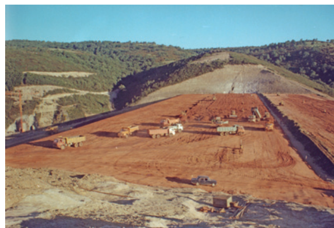
▲ Construcción del cuerpo de la presa (1977).
