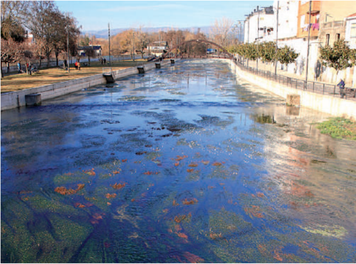
Río Támega. Verín. Ourense. Tramo canalizado.
