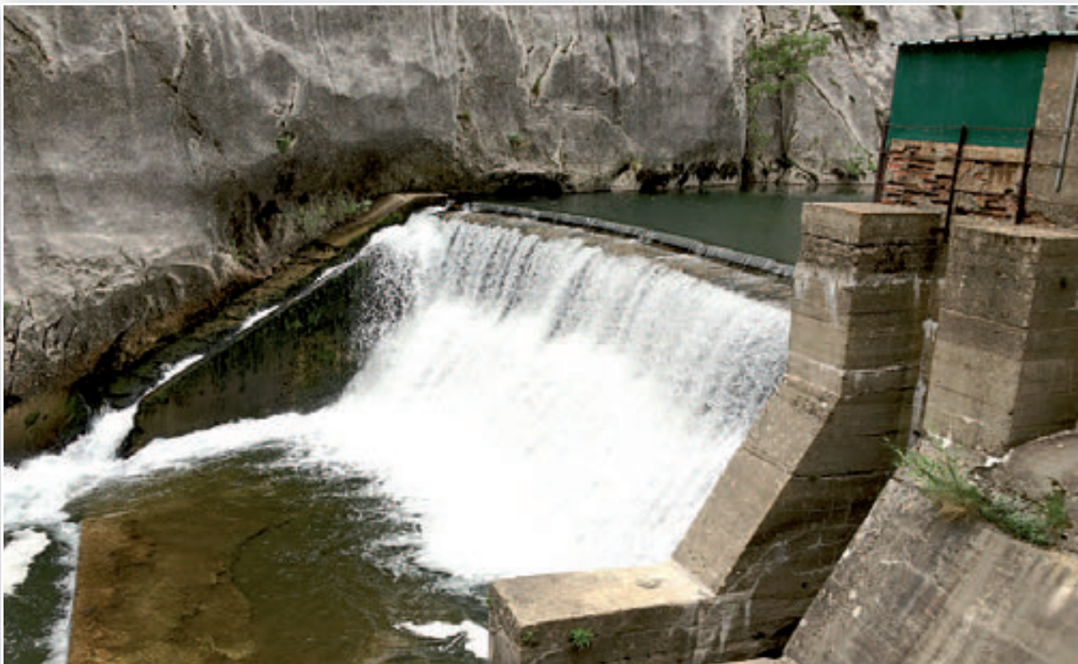
Río Torío. Vegacervera. León. Azud de una minicentral situado en las Hoces de Vegacervera.
