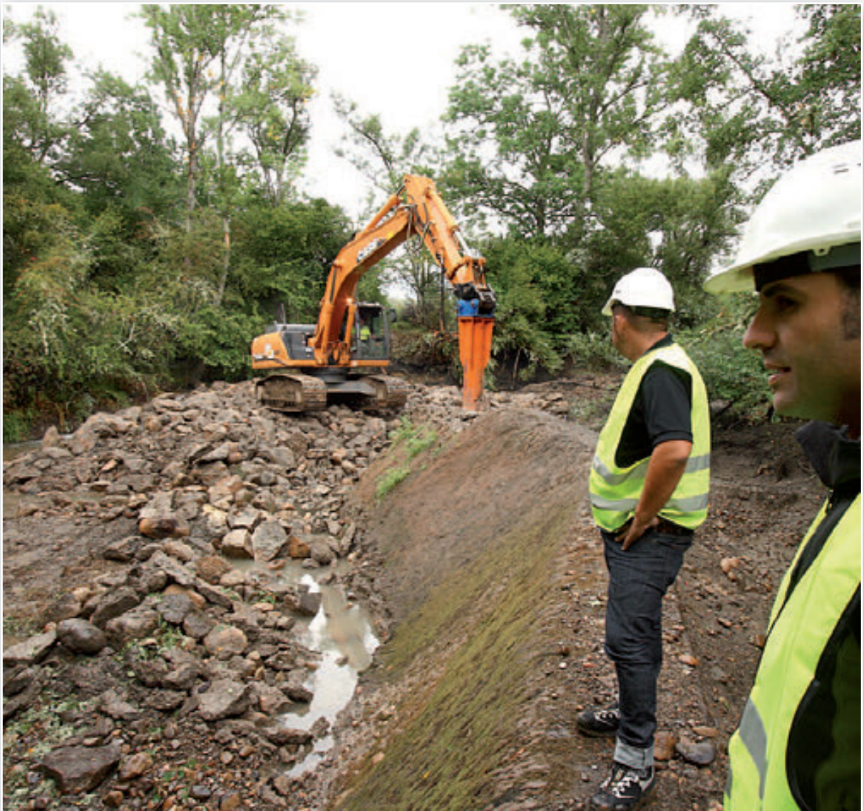
Río Cea. Soto de Valderrueda. León. Demolición de azud.
