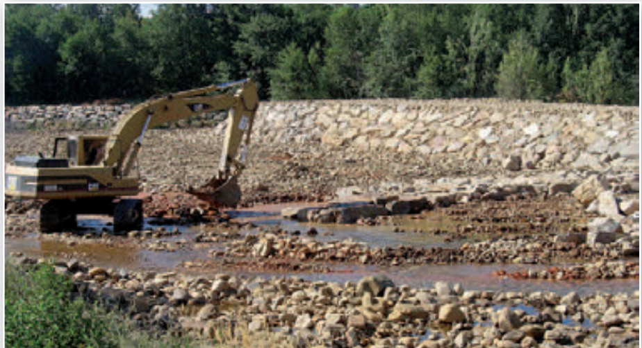
Río Eria. Castrocontrigo. León. Dragado del cauce y construcción de escollera.
