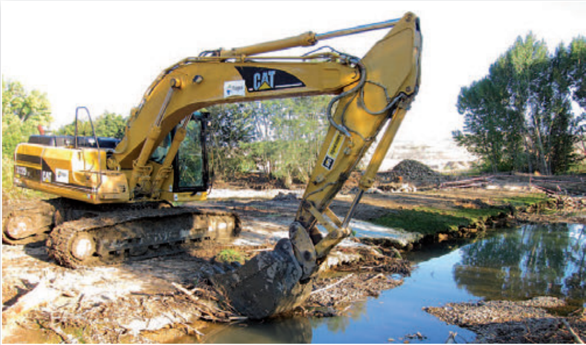
Río Carrión. Monzón de Campos. Palencia. Demolición de azud.
