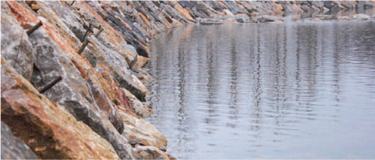
Río Torío. Garrafe de Torío. León. Escollera estaquillada.
