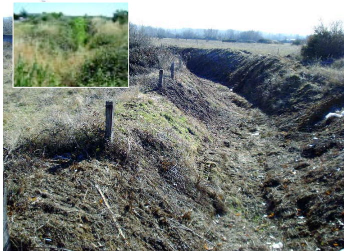
Limpieza del Arroyo del Lllamarlo (León). Antes y después.
