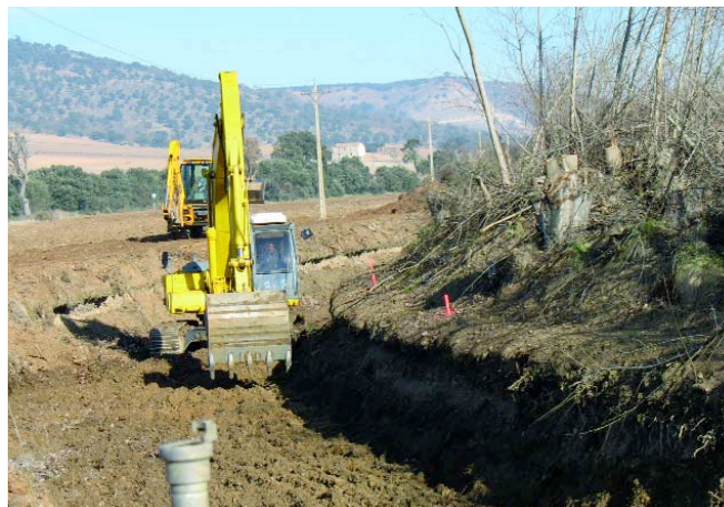
Modernización del Canal de Villalaco (Palencia).
