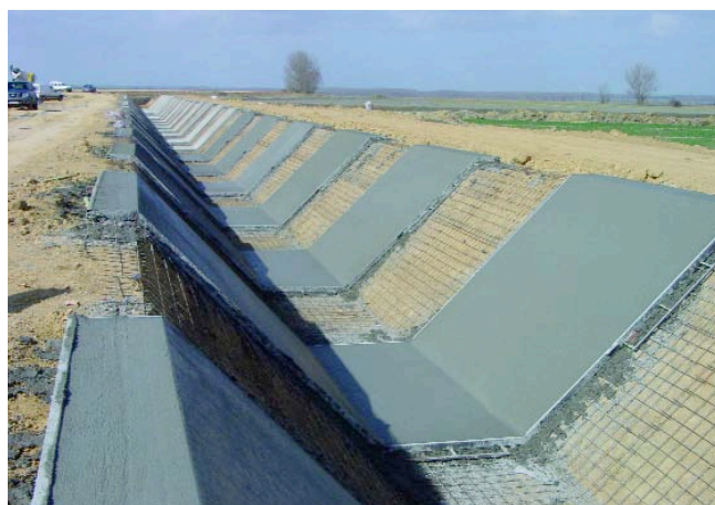
Hormigonado del Canal del Pisuerga a su paso por Támara (Palencia).
