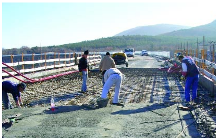
Hormigonado de las nuevas losas de coronación de la Presa de La Cuerda del Pozo (Soria).
