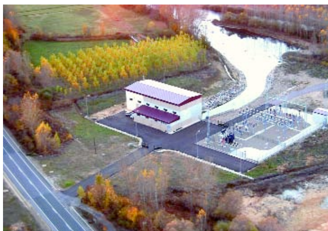
Central Hidroeléctrica Sahechores (León).
