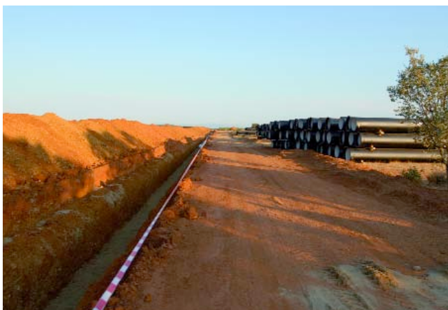
Obras del ramal principal del abastecimiento a Benavente a su paso por Arcos de la Polvorosa (Zamora).
