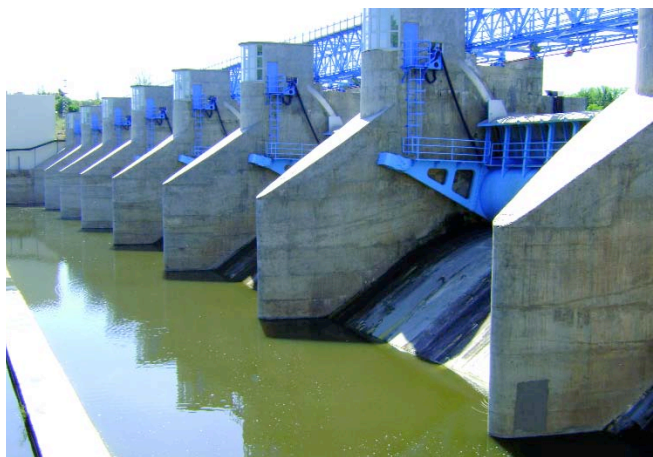
Sustitución de puertas en el azud de Villagonzalo (Salamanca).
