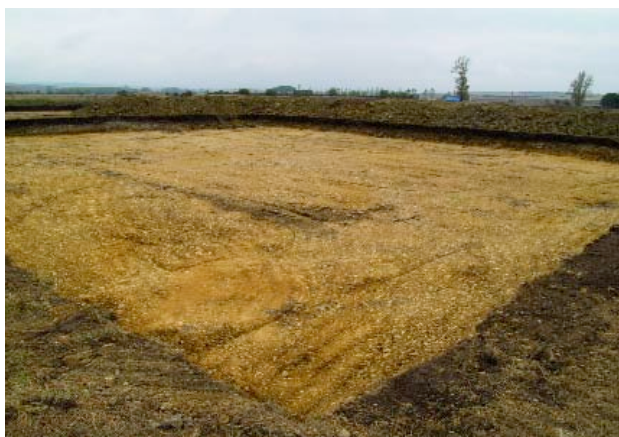
Balsa nº 1 de depuración biológica en Atapuerca (Burgos).
