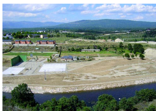
Vista general de la actuación en el tramo urbano del río Tera en Puebla de Sanabria (Zamora).
