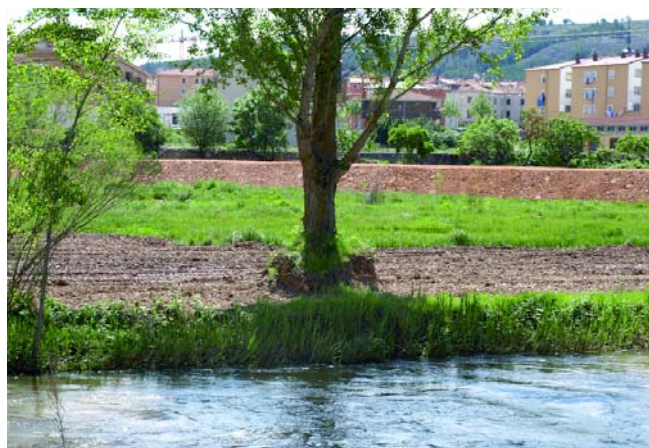
Defensa contra avenidas. El Burgo de Osma (Soria).
