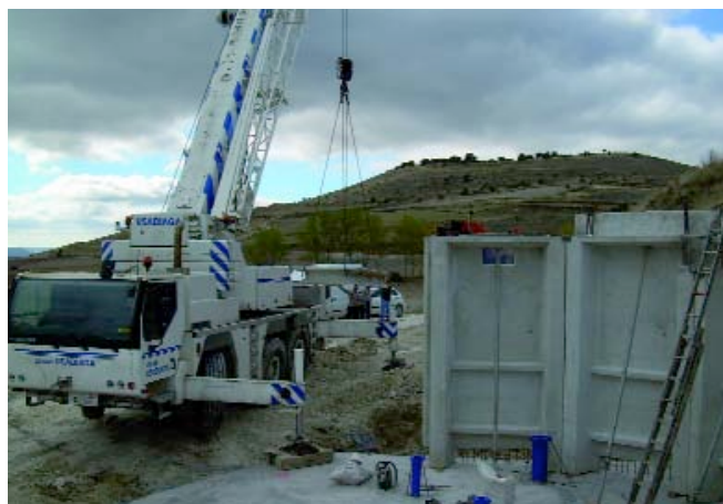
Montaje del depósito prefabricado en Mahamud (Burgos).
