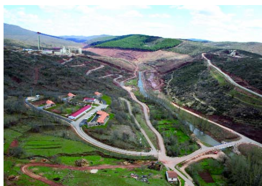
Poblado y planta de hormigonado de la futura Presa de Castrovido (Burgos).
