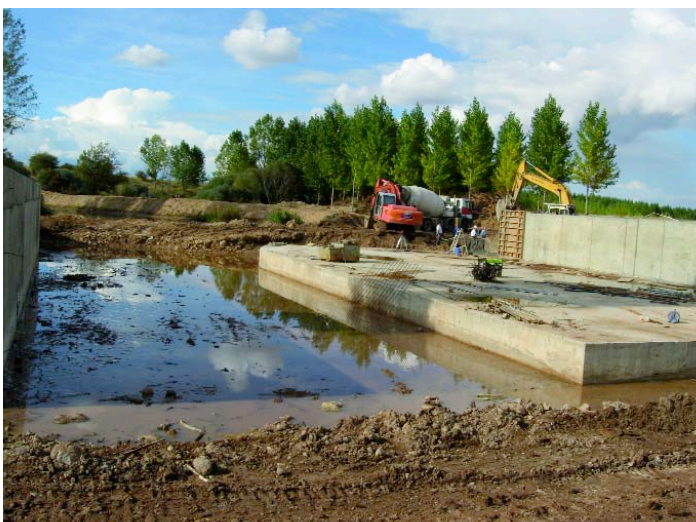
Estación SAIH en construcción en el río Duero (Soria).
