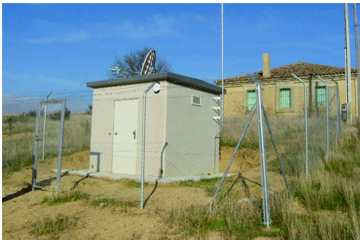
Punto de Control en Canal de Castilla (Palencia).
