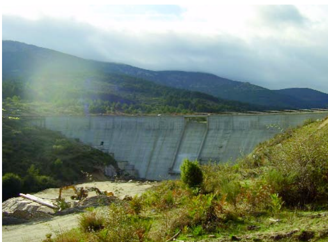
Vista general de la presa del río Ceguilla (Segovia).
