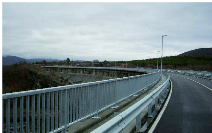
Obra finalizada del andén volado de la presa de La Cueva del Pozo (Soria).
