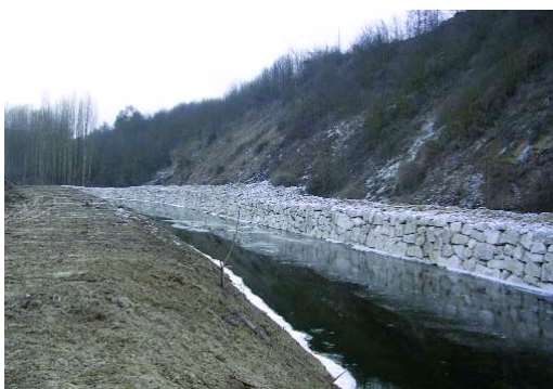
Construcción de muro de protección en el término municipal de Coca (Segovia).
