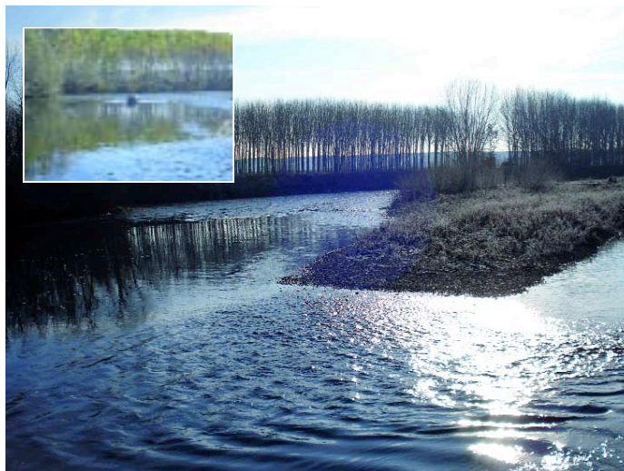
Retirada de obstáculos en cauce en San Cristóbal de Entreviñas (Zamora). Antes y después.
