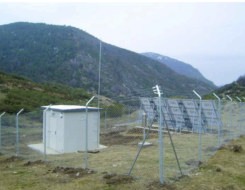
Pluvionivómetro en el Puerto de Señales (León).
