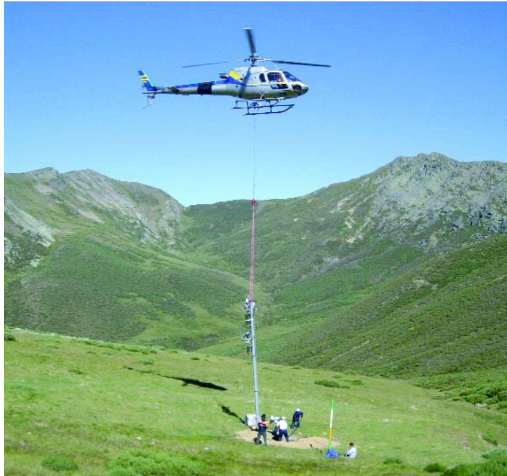
Colocación de un telenivómetro.
