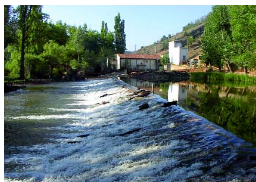
Actuaciones en el entorno del río Duero (Soria).
