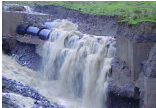
Obra de emergencia del trasvase del río Curueño (León). Situación de la rotura.
