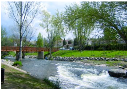
Pasarela sobre el río Eresma a su paso por Segovia.
