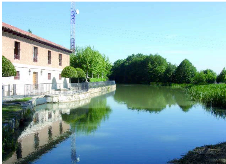
Centro de Proceso de Cuenca en la Esclusa 42 (Valladolid).
