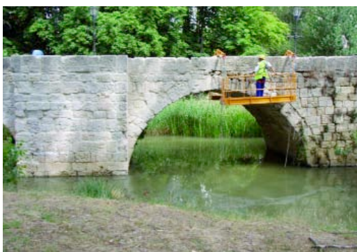
Rehabilitación del puente de Puente de Puentecillas (Palencia).
