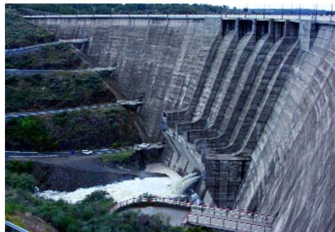
Vista general de la Presa de Irueña (Salamanca).
