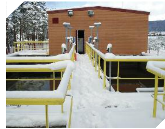
Foto 7.23. Depuradora nevada en Duruelo de la Sierra (Soria)
