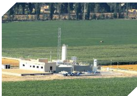
Foto 7.19. Vista general de la estación depuradora en Tudela de Duero (Valladolid)
