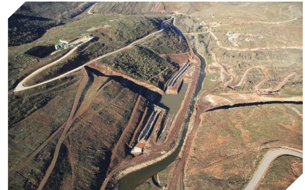
Foto 1.3. Vista aérea de la obras de construcción de la Presa de Castrovido (Burgos)
