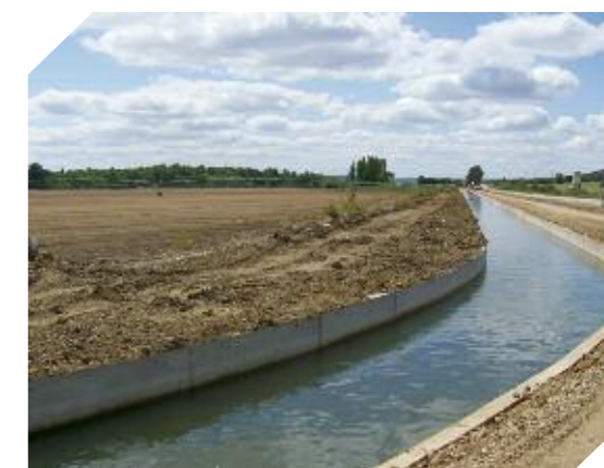
Foto 7.9. Modernización en el tramo 2º del Canal de Villalaco (Palencia)
