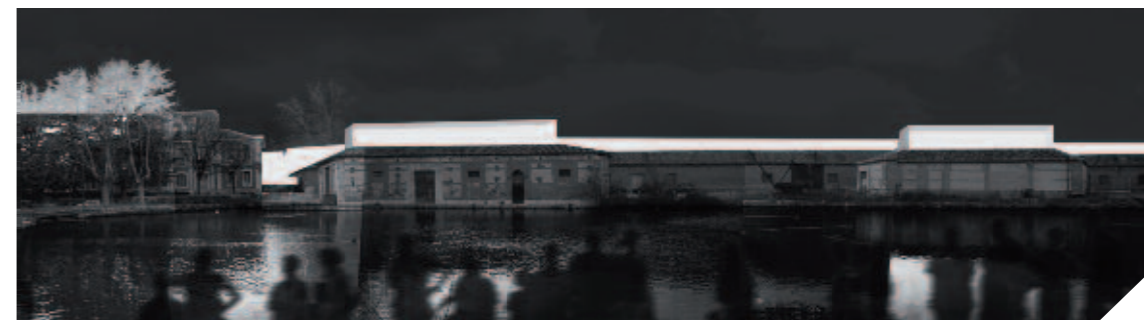
Vista nocturna de la dársena de Valladolid
