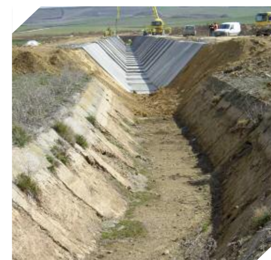
Foto 7.12. Construcción del canal de sección trapecial en Támara de Campos (Palencia)
