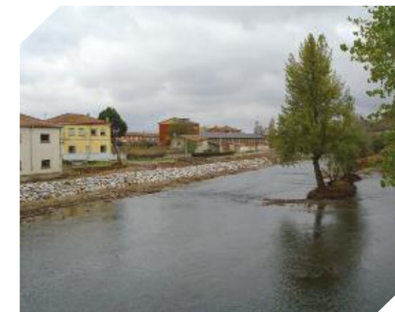
Foto 6.13. Acondicionamiento de la margen izquierda del río Pisuerga a su paso por Alar del Rey (Palencia)
