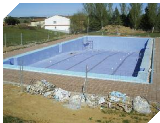
Foto 7.26. Construcción de una piscina en El Bodón como obra accesoria a la Presa de Iruña (Salamanca)
