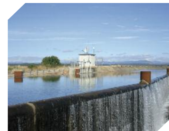
Foto 7.29 Punto de Control en el Canal del Alto Payuelos (León)
