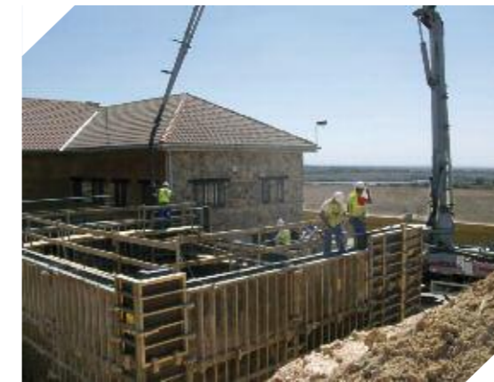
Foto 7.17. Construcción de filtros de la ETAP de Maderuelo de la Mancomunidad de La Atalaya (Segovia)
