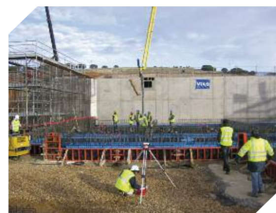
Foto 7.21. Construcción de los decantadores de la ETAP en Sitrama de Tera (Zamora)
