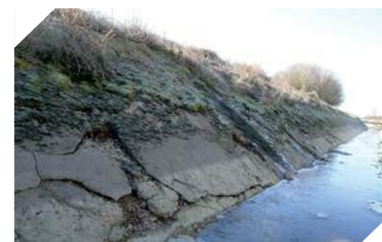
Foto 7.15. Roturas severas en los paños de la margen izquierda del Canal del Órbigo (León)
