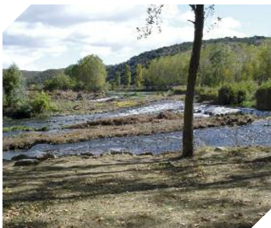
Foto 6.14. Rehabilitación del azud de regulación en la entrada de agua al Canal de Castilla en Alar del Rey (Palencia)
