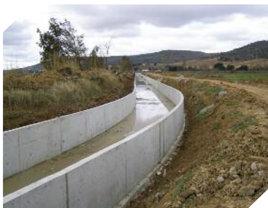
Foto 7.10. Modernización en el tramo 3º del Canal de Villalaco (Palencia)
