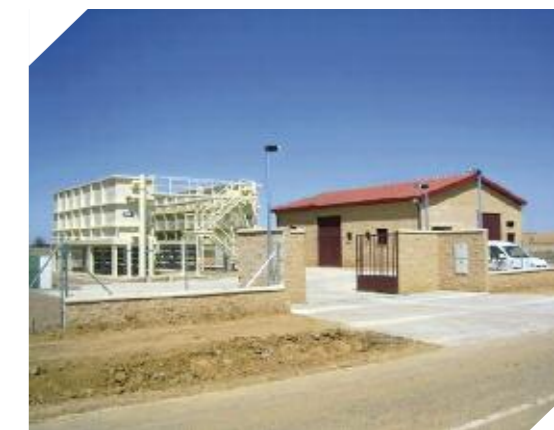
Foto 7.22. Vista exterior de la ETAP en Cabezón de Valderaduey (Valladolid)
