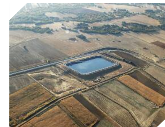
Foto 7.13. Vista aérea de la balsa de regulación A5 en Villacalbuey-Villamol (León)
