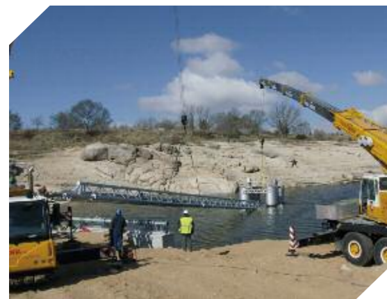
Foto 7.16. Obra de la toma para suministro de agua a las fuentes del Palacio de La Granja (Segovia)
