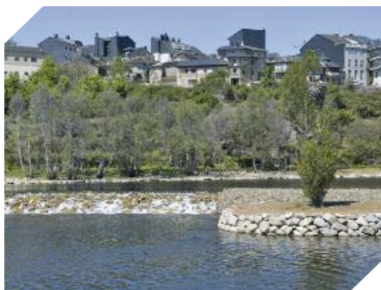
Foto 6.4. Azud de El Pinar reconstruido en Puebla de Sanabria (Zamora)
