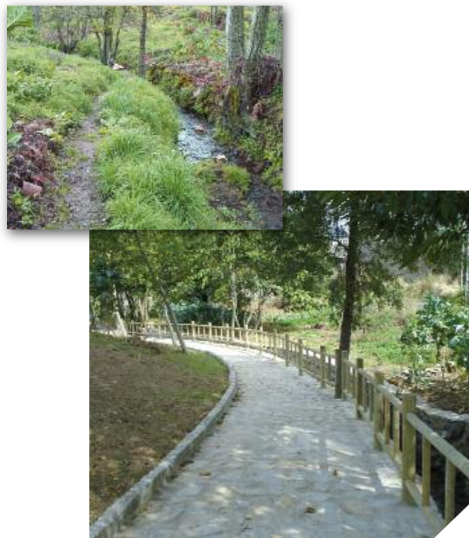
Fotos 6.17. Recuperación ambiental del río Arzadegós en el término municipal de Vilardevós (Ourense). Antes y después.
