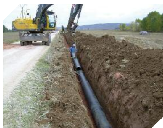
Foto 7.20. Colocación de tubería de conducción
