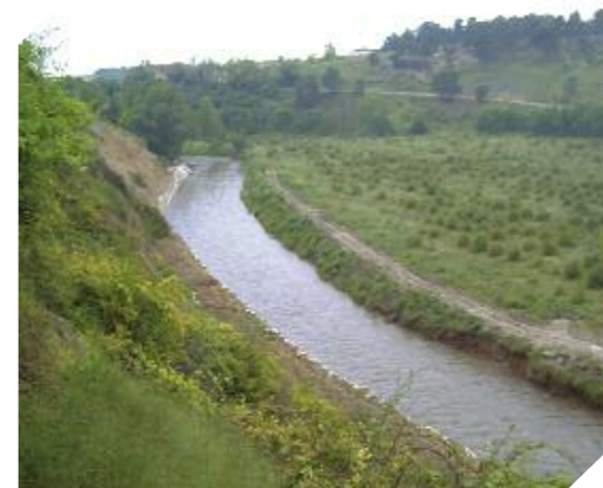
Foto 6.8. Construcción de muro de protección en Torre de San Nicolás, término municipal de Coca (Segovia)
