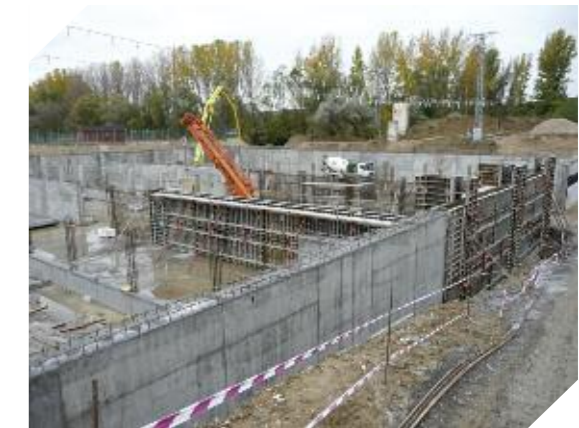
Foto 7.25. Construcción del tanque de tormentas en Palencia
