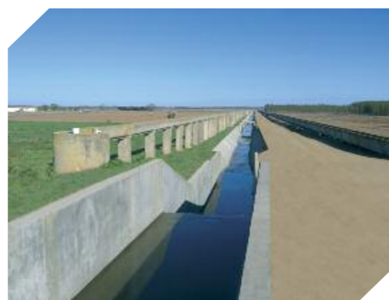
Foto 7.11. Revestimiento del desagüe final del Canal del Esla en el término municipal de Benavente (Zamora)
