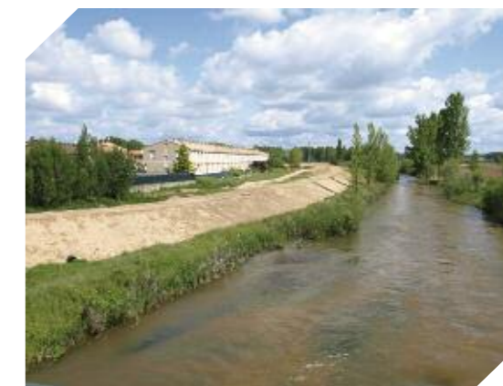
Foto 6.9. Defensa contra avenidas en El Burgo de Osma (Soria)
