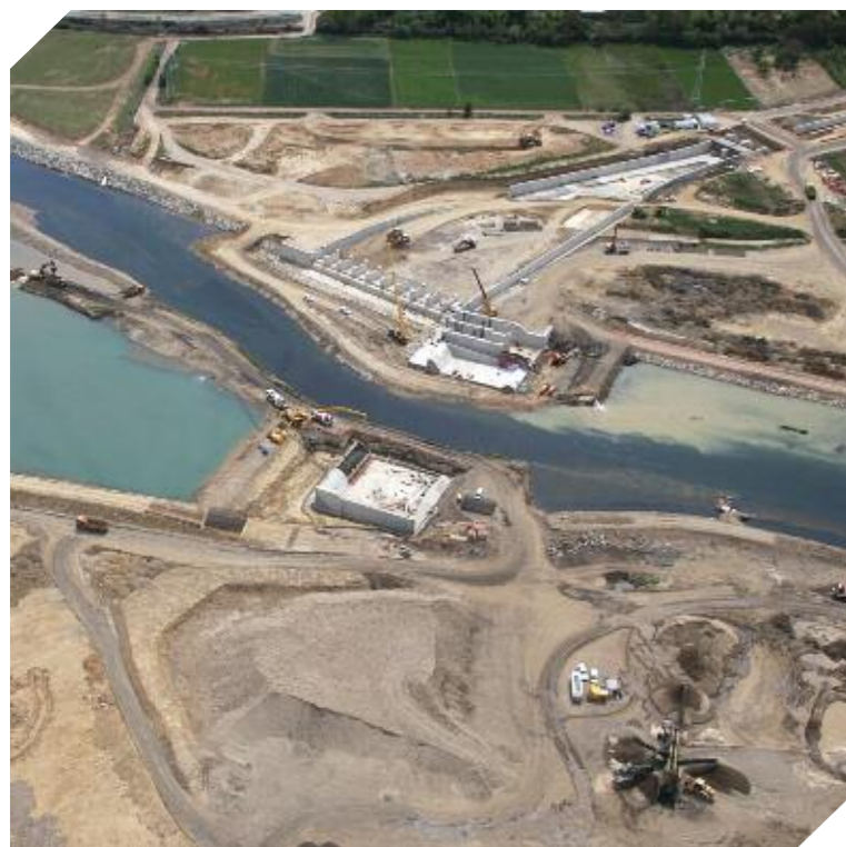
Foto 1.1. Obras del Canal Bajo de Los Payuelos (León)
