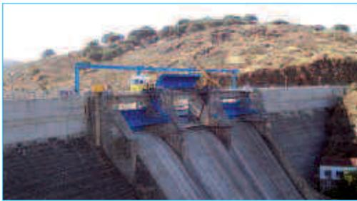
Foto 7.25. Trabajos de instalación de nuevas compuertas, tipo Taintor, en la presa del Águeda (Salamanca).
