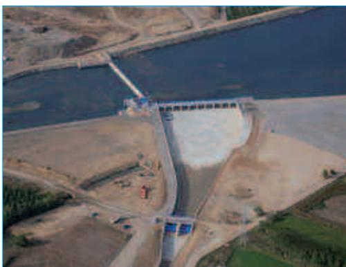
Foto 7.13. Vista aérea de la construcción del azud de toma en el río Esla del Canal Bajo de los Payuelos en Sahechores (León).
