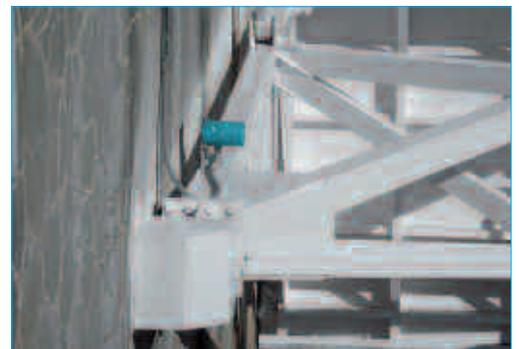
Foto 5.3. Sensor de control de apertura de compuerta.
