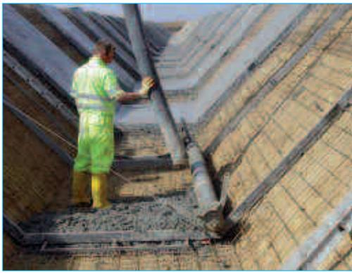
Foto 7.12. Reconstrucción del Canal del Pisuerga en Támara de Campos (Palencia).
