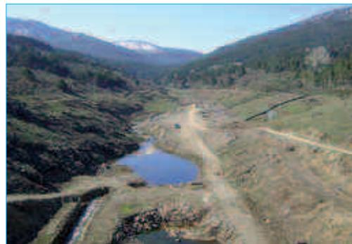
Foto 7.19. Deforestación del vaso de la presa del río Ceguilla.
