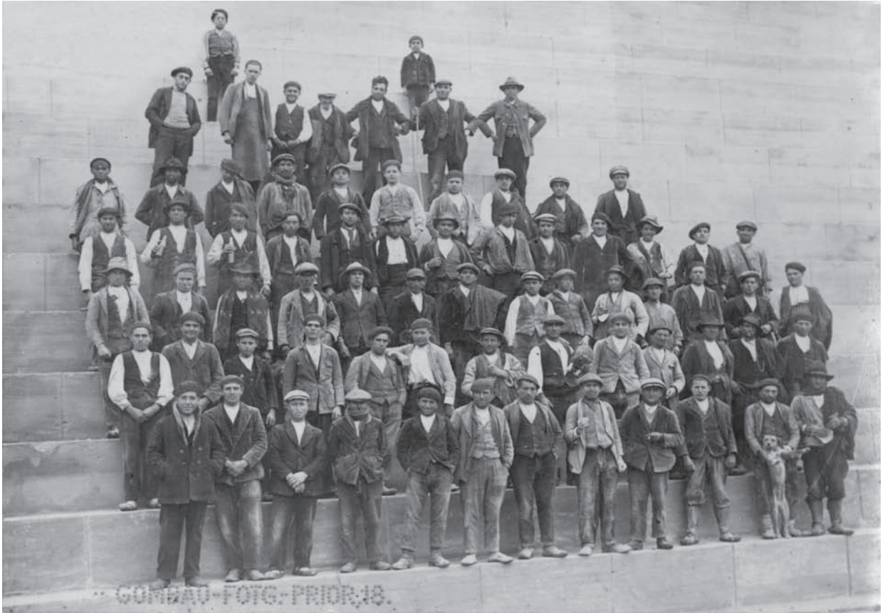
Trabajadores de la presa del Águeda (Salamanca), 1931.
