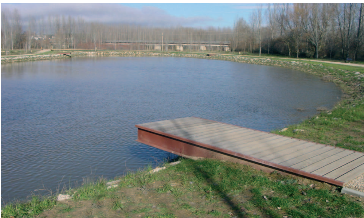
Actuaciones de Aguas del Duero, S.A. en Almazán (Soria).
