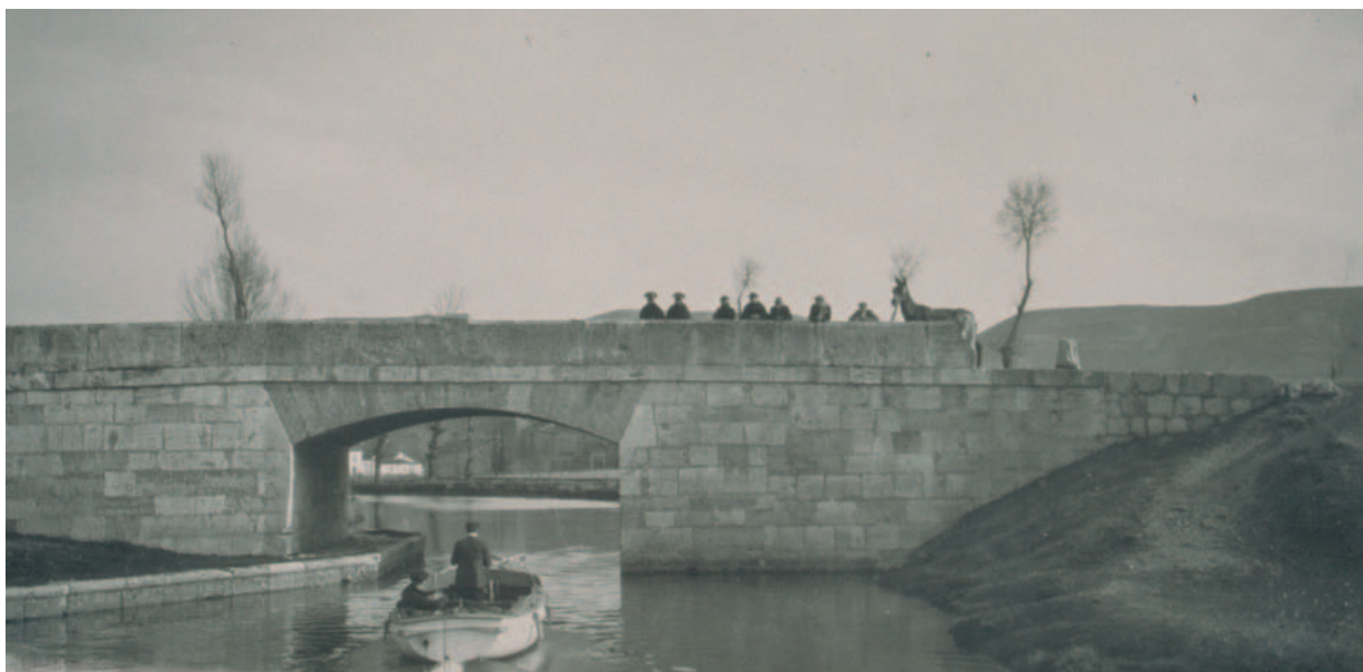
Canal de Castilla: Ramal Sur. Puente de Palazuelos en Cabezón de Pisuerga (Valladolid).
