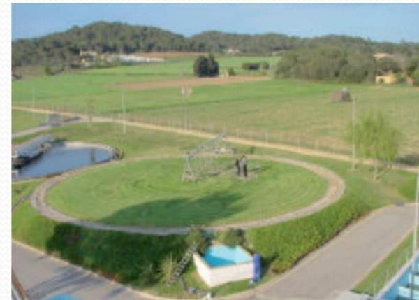
Filtros de arena → Adecuados para vertidos estacionales, al igual que otros procesos basado en la filtración (filtros turba, humedales subsuperficiales...).
