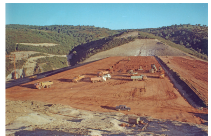
▲ Construcción del cuerpo de la presa (1977).
