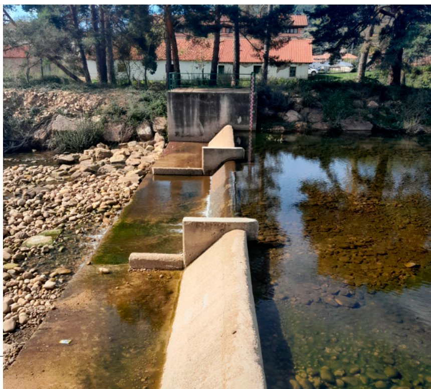
Figura 14. Vertedero de pared gruesa en Revinuesa (Soria).
