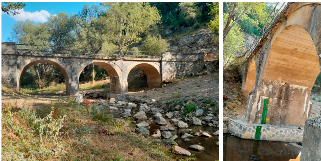
Figura 11. EA en cauce natural aprovechando el puente existente, en Vañes (Palencia).
