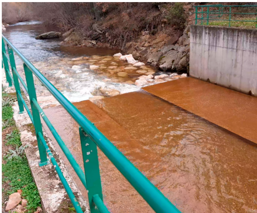
Figura 13. Encauzamiento con canal sensible central en Molinos de Duero (Soria).
