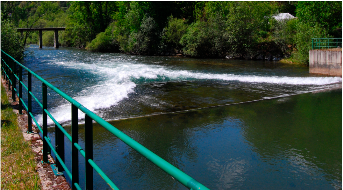
Figura 15. Vertedero tipo V-flat, en el río Esla en Las Salas, antes de su sustitución por su perjuicio sobre la piscifauna.
