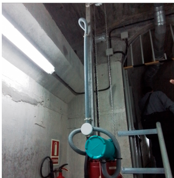
Figura 7. Sistema de cadena y polea sobre válvula con encoder óptico(verde). Interior del encoder.
