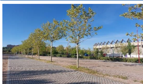
SUD entorno del estadio José Zorrilla, pavimento permeable. Fuente: Ayuntamiento de Valladolid.
