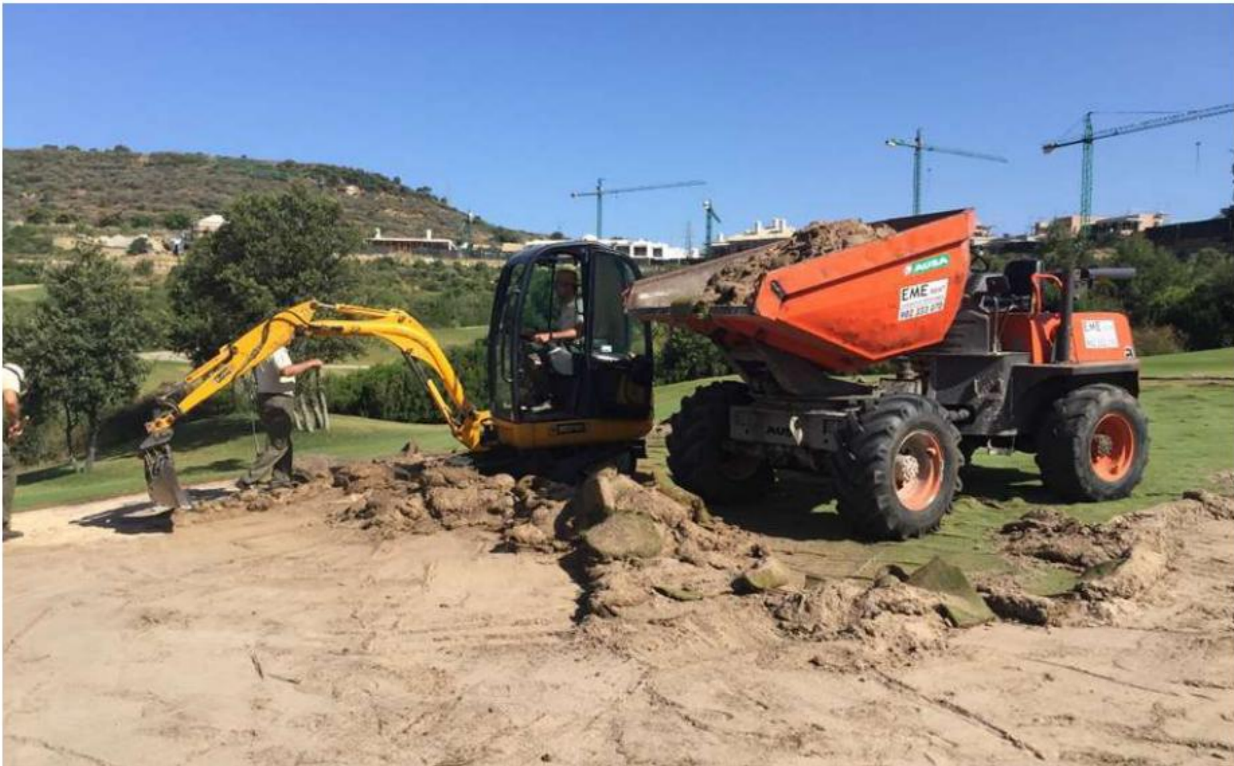
Trabajos de retirada de la capa superficial en un green.
