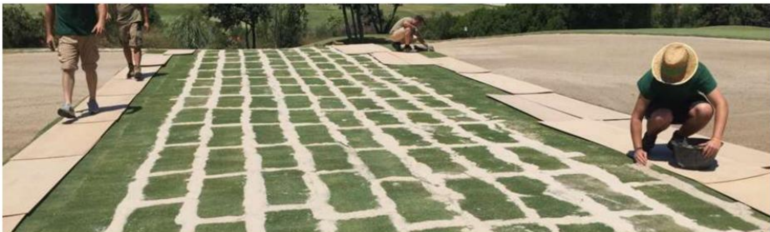
Colocación de los tepes de Bermuda enana.
