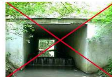
Figura 10.3. Escalón en el interior del drenaje que supone un obstáculo para el movimiento de fauna acuática. Foto: J. Dufek.
