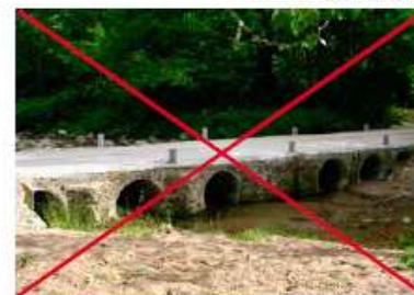
Figura 10.2. Drenajes situados en un badén que dificultan el paso de peces. Foto: F. Navás.
