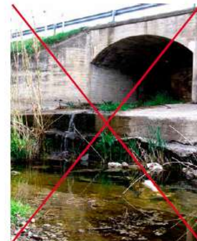
Figura 10.5. Socavación de la base de la estructura que ha generado un desnivel insalvable para la fauna acuática. Foto: M. Clavero.
