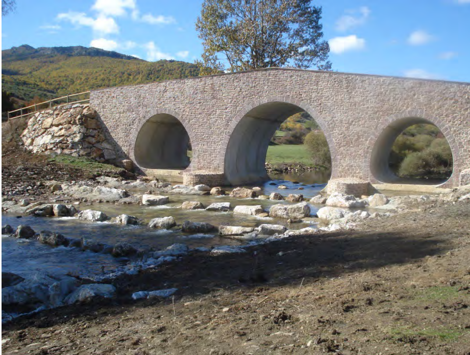
Puente San Salvador de Cantamuda (río Pisuerga, Palencia)
