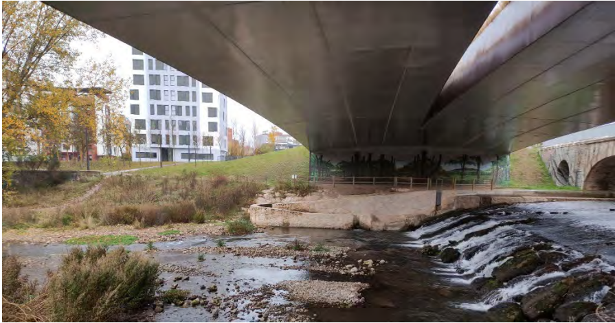
Puente Bulevar (río Arlanzón, Burgos)
