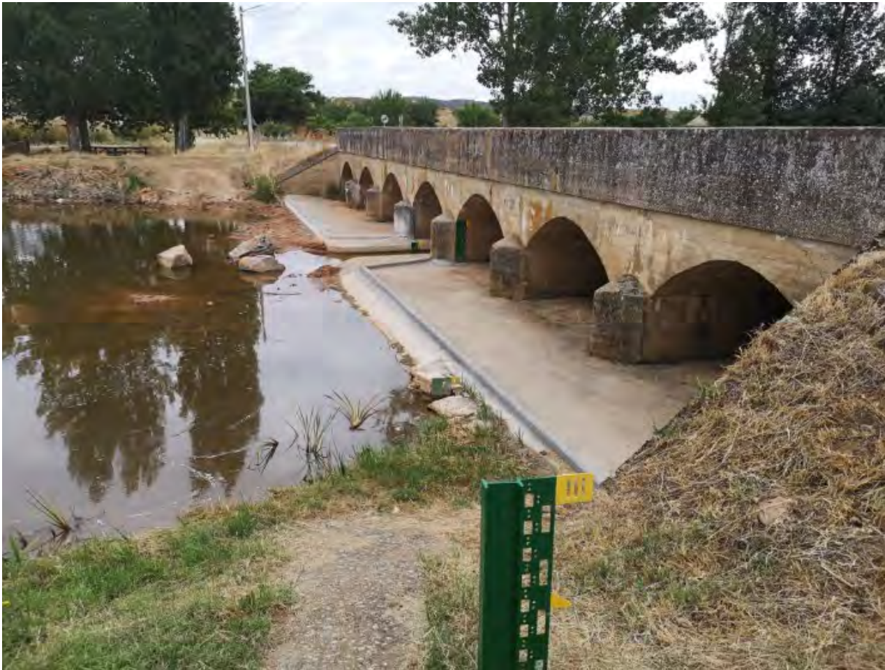
Puente y aforo de Brime de Urz (arroyo Almucera, Zamora)
