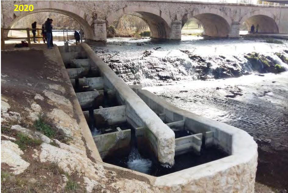
Puente Bulevar (río Arlanzón, Burgos)
