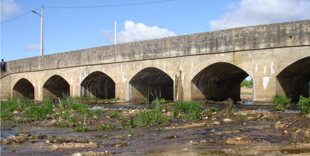
Puente y aforo de Brime de Urz (arroyo Almucera, Zamora)
