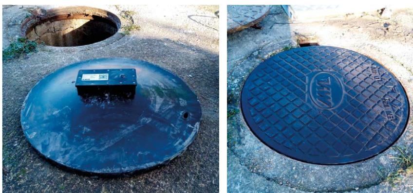
Ilustración 57. Monitorización de los eventos (VDSS), instalado en la tapa de composite (para zonas de poca cobertura) de un pozo de registro. Fuente: Hidrostack.
