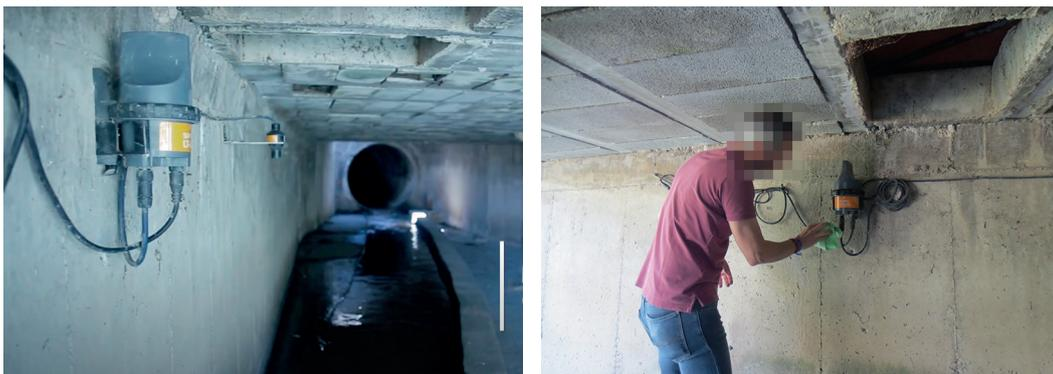
Ilustración 19. Caudalímetro: Conjunto de sensor de nivel por ultrasonidos (US) sin contacto + Registrador de datos SOFREL LT-US (Data logger), sin alimentación eléctrica, en un aliviadero. Fuente: LACROIX SOFREL.
