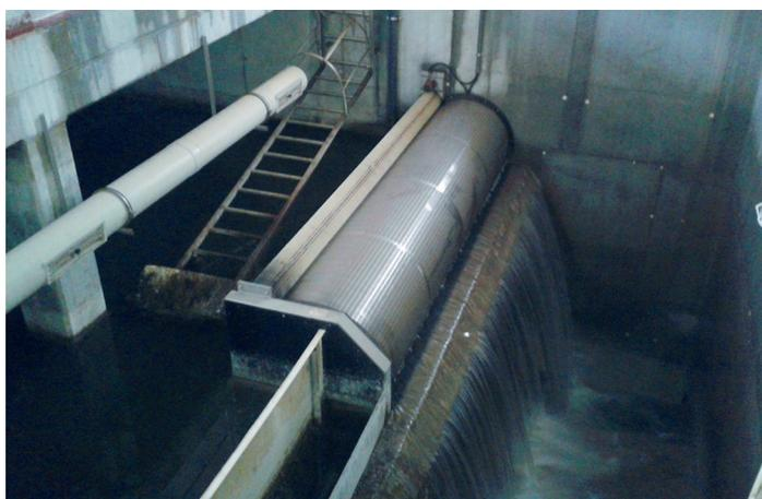
Ilustración 28. Filtro-Tamiz rotativo (Modelo FluidRotor) (DN 1.200 mm; L 4 m) con devolución de los sólidos gruesos y flotantes al colector. Recomendado para caudales elevados ( $\leq 1.300$  l/s-m). Fuente: CleanWater.
