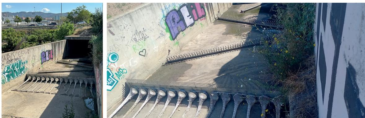
Ilustración 36. Sistema combinado con grapas y un deflector equipado con 14 mallas High-Strength en Riera La Salut. Sant Feliu de Llobregat (Barcelona). 04/05/2023. Fuente: Tecnoconverting.
