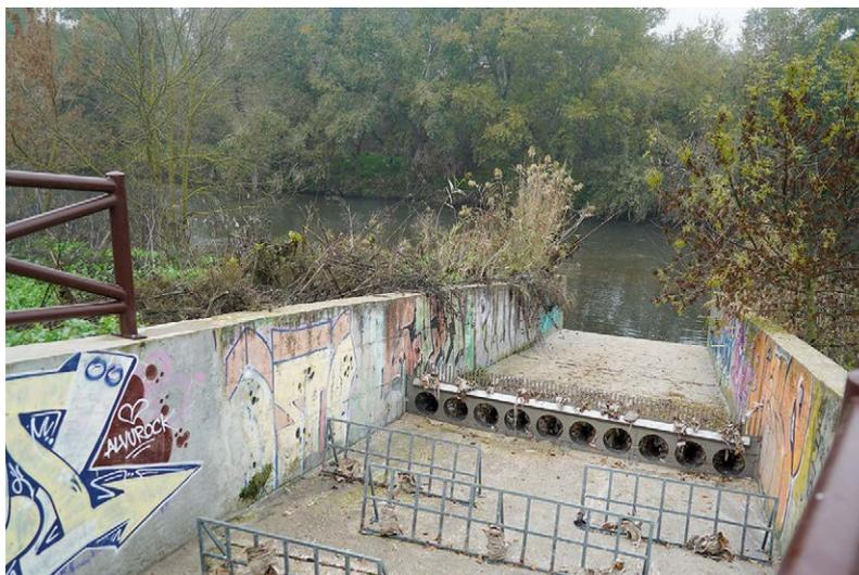
Ilustración 18. Obra de incorporación a cauce a la salida de aliviadero. Fuente: Canal de Isabel II S.A.M.P.
