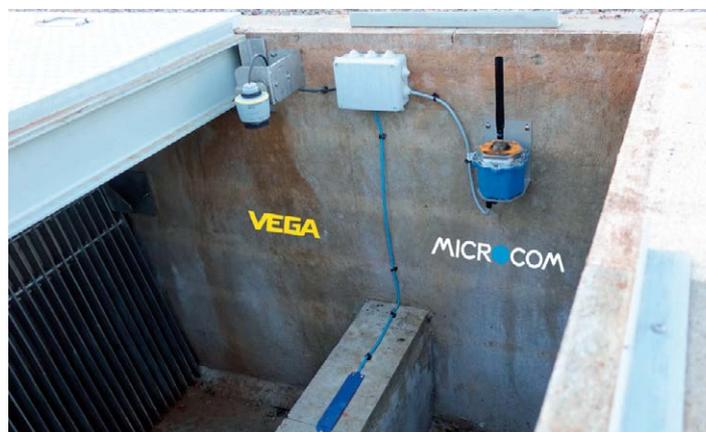
Ilustración 54. Monitorización del sistema de saneamiento de Castellón para el control cuantitativo de los vertidos por desbordamientos del sistema de saneamiento en episodios de lluvia. Fuente: Ayuntamiento de Castellón.
