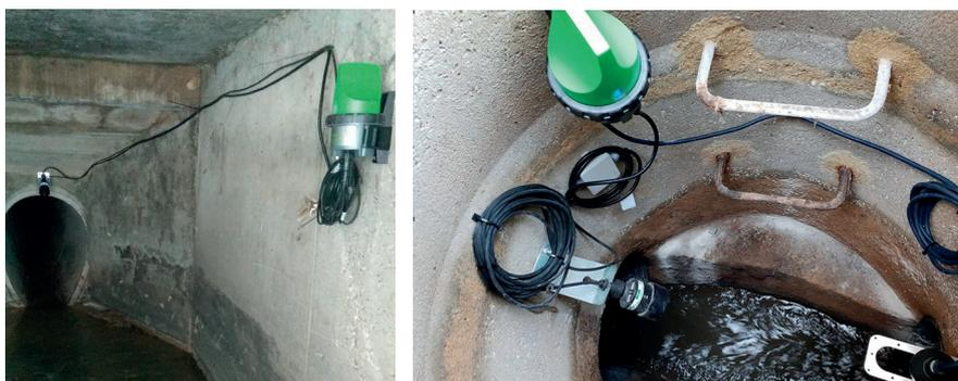
Ilustración 14. Caudalímetro con tecnología Radar: Conjunto de sensor de nivel por ultrasonidos (US) sin contacto + Sensor de velocidad Radar VRad-i sin contacto + Registrador de Datos SOFREL LT-US (Data Logger) + Caja estanca de conexión. Se puede calcular el caudal a partir de la fórmula  $\text{Caudal} = \text{Velocidad} \times \text{Área mojada}$ . Fuente: LACROIX SOFREL.
