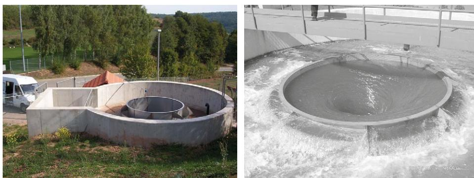
Ilustración 63. Tanque de tormentas sedimentador o compacto, por efecto vórtice, en tiempo seco (izquierda) y funcionando en un episodio de lluvia (derecha) creándose el efecto ciclón. Construidos en hormigón armado *in situ*. Alemania. Fuente: CleanWater.
