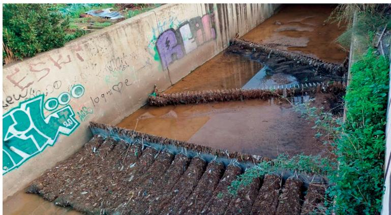
Ilustración 37. Retención de sólidos gruesos y flotantes tras un episodio de lluvia en el sistema combinado con grapas y un deflector equipado con 14 mallas High-Strength en Riera La Salut. Sant Feliu de Llobregat (Barcelona). Fuente: Tecnoconverting.
