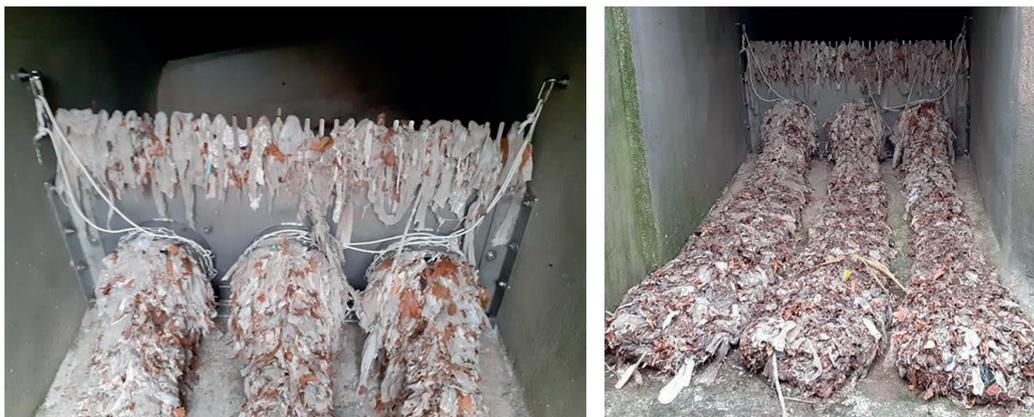
Ilustración 35. Retención de sólidos gruesos y flotantes mediante 3 cestas TecnoGrabber® en un colector del sistema de saneamiento. Sabadell (Barcelona). Río Ripoll. 21/10/2020. Fuente: Tecnoconverting.
