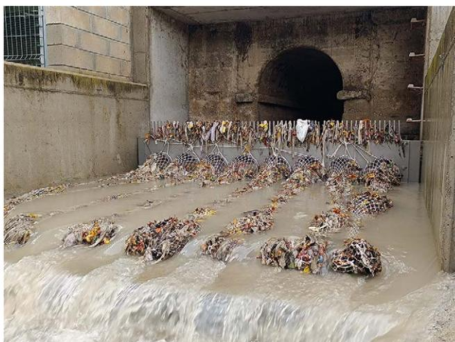
Ilustración 79. Vertido por desbordamientos del sistema de saneamiento en un episodio de lluvia y retención de sólidos gruesos y flotantes mediante 8 cestas TecnoGrabber®. 17/10/2024. Navarclés (Barcelona). Fuente: Tecnoconverting.
