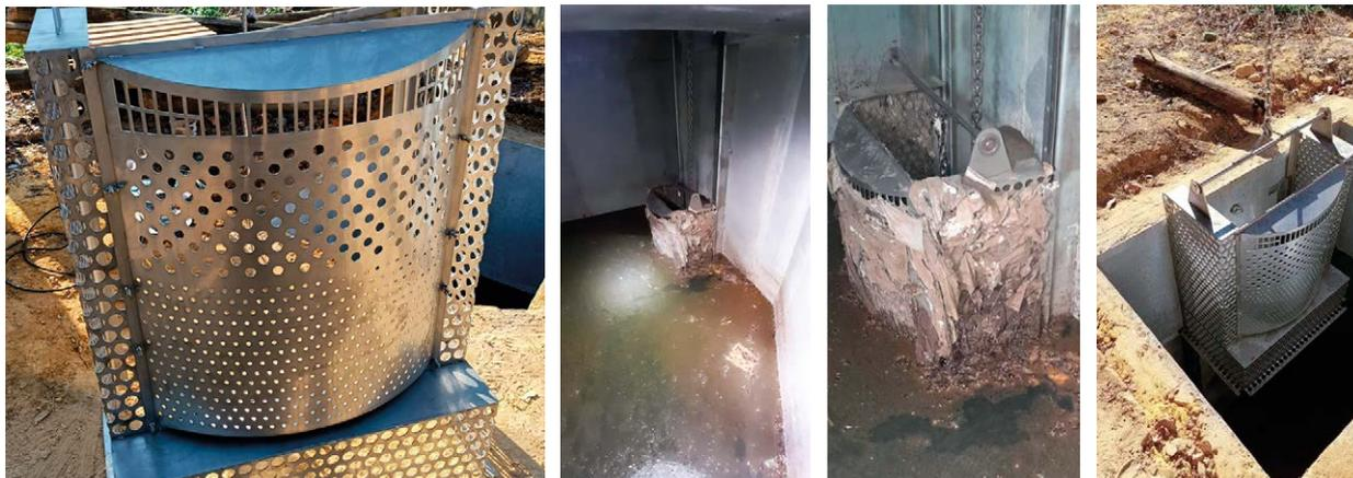
Ilustración 78. Sistema de retención de sólidos gruesos y flotantes mediante cesta inoxidable perforada, con rebose superior para que no entre en carga el sistema de saneamiento (Gis 168: Próximo a la Avda. Tren de los Panaderos). Alcalá de Guadaíra (Sevilla). Fuente: EMASESA.
