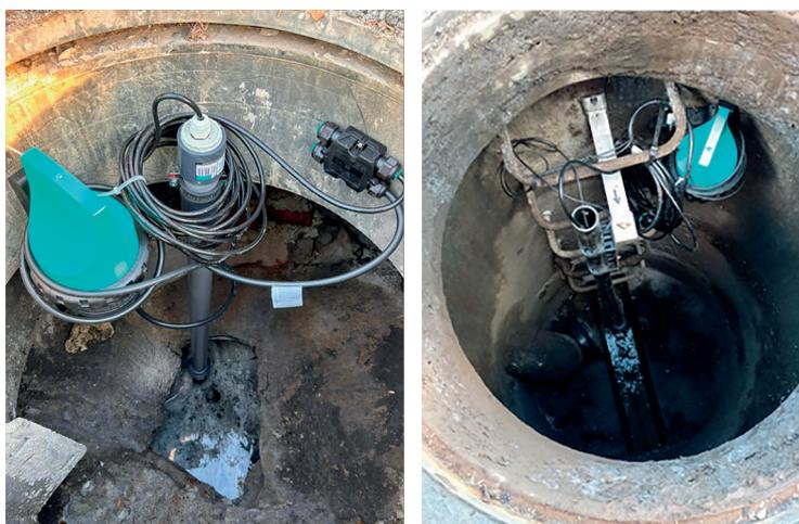
Ilustración 17. Conjunto: Sensor de conductividad [salinidad; Sólidos disueltos (TDS)] + Registrador de datos DL4W (Data logger). Fuente: LACROIX SOFREL.
