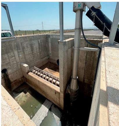
Ilustración 26. Tamiz de aliviadero tipo tornillo en espiral (Modelo CWi-OVF). Los sólidos gruesos y flotantes se extraen mediante tornillo vertical a contenedor. Fuente: CleanWater.
