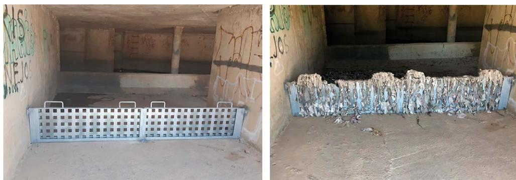
Ilustración 80. Sistemas de retención de sólidos gruesos y flotantes en el aliviadero Felipe González. Limpieza manual. Dos Hermanas (Sevilla). Fuente: EMASESA.
