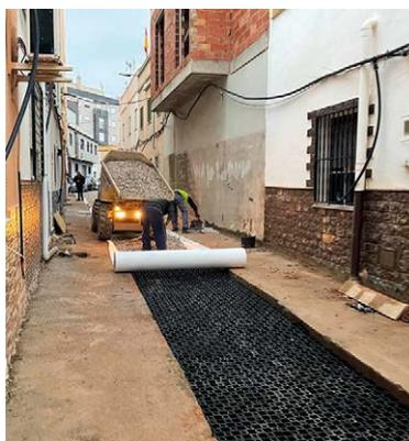
Ilustración 89. Instalación de pavimento permeable (SUDS) en un entorno urbano consolidado. Barrio Corell en Almassora (Castellón). Año 2022. Fuente: Eiffage Construcción.
