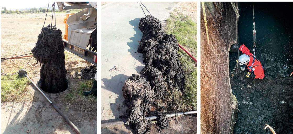
Ilustración 51. Retirada de toallitas higiénicas que provocan atascos en el sistema de saneamiento (acción correctiva). Fuente: EMA-SESA.
