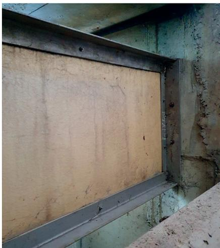
Ilustración 38. Muro vertedero y chapa deflectora del aliviadero Pilón 6 Treflería (Gijón). Fuente: Empresa Municipal de Aguas de Gijón, S.A.U.
