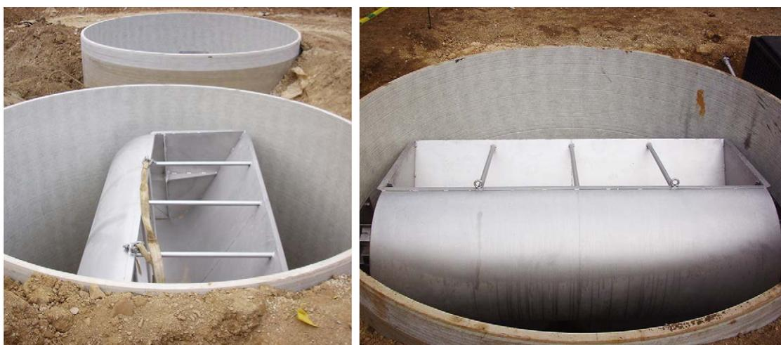
Ilustración 41. Limpiador basculante en un tanque de tormenta tubular / prefabricado modular (AmiStorm Tank). Fuente: Hidros-tank.
