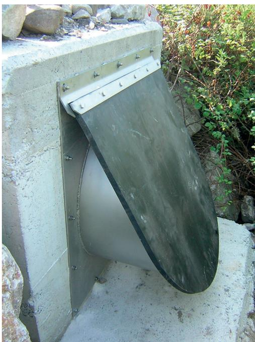
Ilustración 25. Clapeta antirretorno circular. Modelo FluidSwing RM con un DN de 600 mm e instalada en el exterior de un tanque de tormentas para evitar que el agua del río/cauce se introduzca en la infraestructura. Asturias. Fuente: CleanWater.
