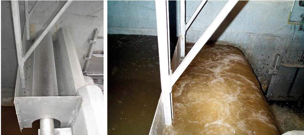
Ilustración 72. Evolución del funcionamiento de un tamiz de aliviadero de limpieza automática tipo PAS (con energía y orificios con un diámetro  $\varnothing$  nominal de 6 mm) y pantalla deflectora de flotantes, durante un episodio de lluvia e instalados en un sistema de saneamiento unitario. Tras el episodio el tamiz vuelve a estar operativo y limpio. Alemania. Fuente: HidroStank.
