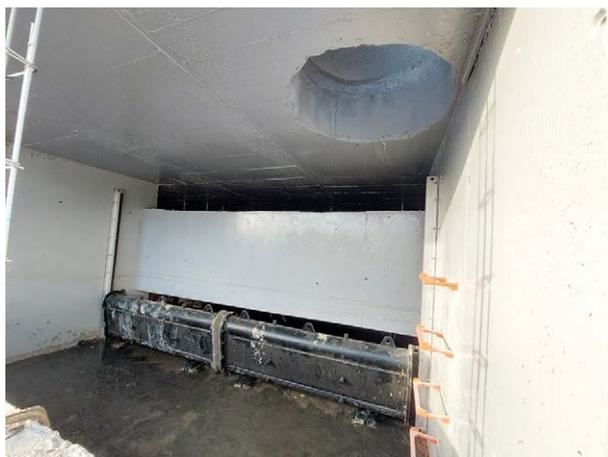
Ilustración 70. Pantalla deflectora y aliviaderos flexibles. Aliviadero N-IV La Motilla. Sevilla. Fuente: EMASESA.
