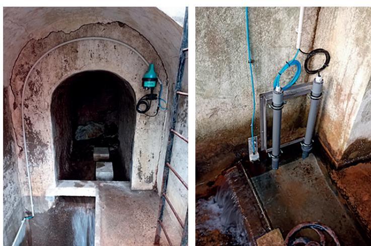
Ilustración 18. Control cuantitativo y cualitativo de los VDSS: Conjunto de sensor de nivel por ultrasonidos (US) para medir el caudal, sin contacto + Sonda de pH (pH; Redox; temperatura) + Sonda de conductividad [salinidad; Sólidos disueltos (TDS)] + Registrador de datos SOFREL DL4W-HP (DL4W/LT-US) (Data logger). Fuente: LACROIX SOFREL.
