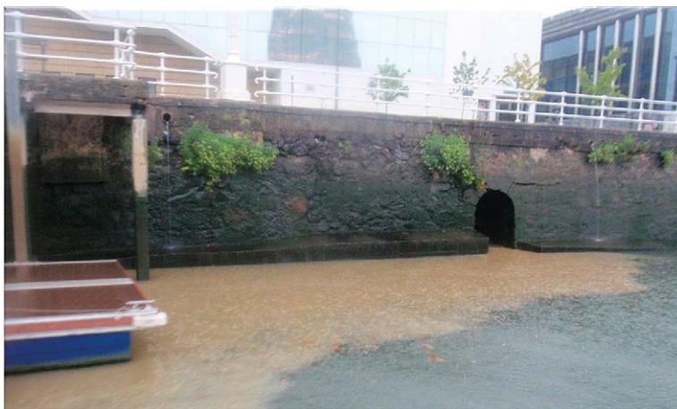
Ilustración 4. Contaminación asociada a un punto de vertido por desbordamiento del sistema de saneamiento (PDSS) en episodios de lluvia en Ría urbana. Fuente: MITECO.
