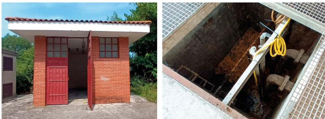
Ilustración 20. Caseta y cámara de bombas del bombeo del aliviadero Pinzales 1 (Gijón). Fuente: Empresa Municipal de Aguas de Gijón, S.A.U.
