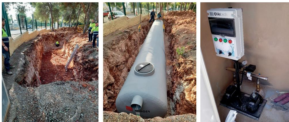
Ilustración 9. Excavación e instalación de un depósito de 25 m³ para almacenamiento de agua pluvial e instalación de bombeo para su aprovechamiento en el riego de los jardines y baldeo de las terrazas del Club Social. «Plan Verdea SbN. Renaturalización del entorno construido». Puçol (Valencia). Fuente: Club de Campo Los Monasterios de la Urbanización Valle R. Los Monasterios.
