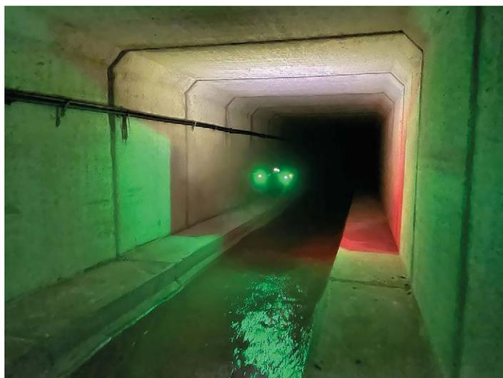
Ilustración 23. Inspección mediante dron autónomo en el colector Laminador Gavia Alta. Madrid. Fuente: Canal de Isabel II S.A.M.P.
