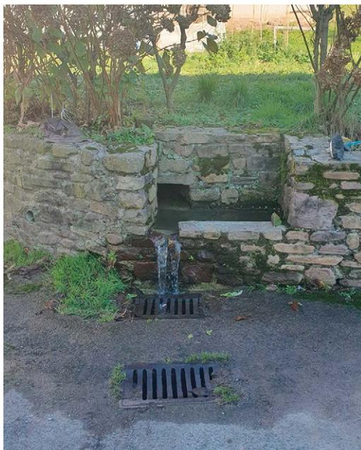
Ilustración 25. Hay que evitar la entrada de aguas limpias al sistema de saneamiento, promoviendo su desconexión fluvial.
