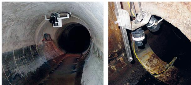
Ilustración 12. Control cuantitativo de los VDSS: Conjunto de sensor de nivel por ultrasonidos (US) sin contacto + Sensor de velocidad Radar VRad-i sin contacto. Fuente: LACROIX SOFREL.
