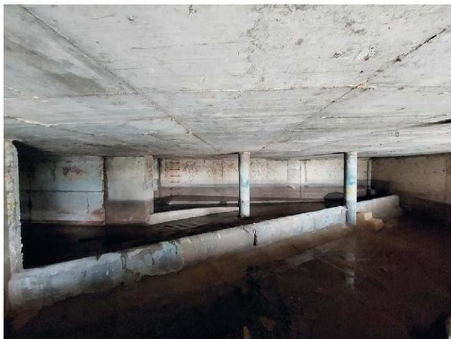
Ilustración 19. Detalle de muretes de alivio en desbordamientos de sistemas de saneamiento unitario. Fuente: EMASESA.
