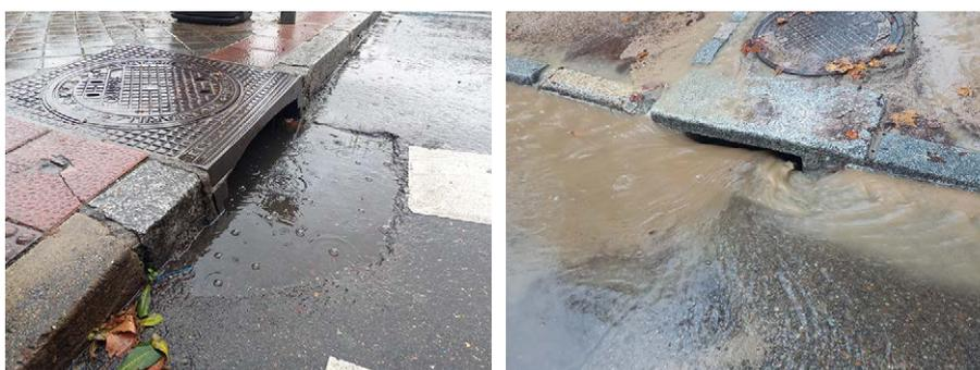
Ilustración 45. Entrada de escorrentía pluvial urbana al sistema de saneamiento a través de imbornales. Fuente: MITECO.
