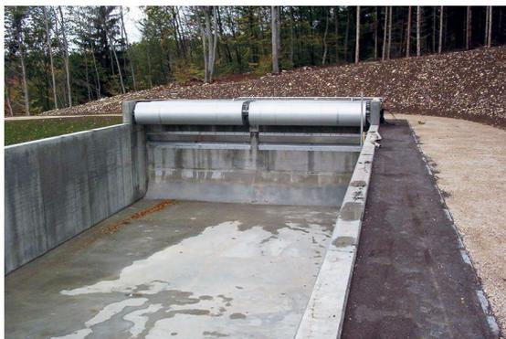
Ilustración 22. Tanque de tormentas rectangular sedimentador (Clarificador). El regulador de caudal de alivio se localiza al fondo para lograr una velocidad horizontal constante en la estructura, favoreciendo la decantación. Se retiene un volumen determinado de agua y se trata por sedimentación antes de su vertido, reduciendo la contaminación de los VDSS en episodios de lluvia. Alemania. Fuente: CleanWater.
