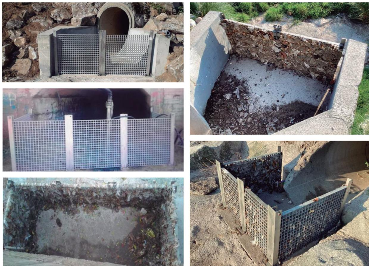
Ilustración 30. Rejillas en incorporación a cauce. Fuente: Consorci Besòs Tordera.
