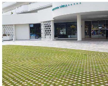
Ilustración 91. Pavimentos permeables (o drenantes). Pieza que crea una superficie de césped a la vez que soporta las cargas de vehículos. Fuente: Breinco.
