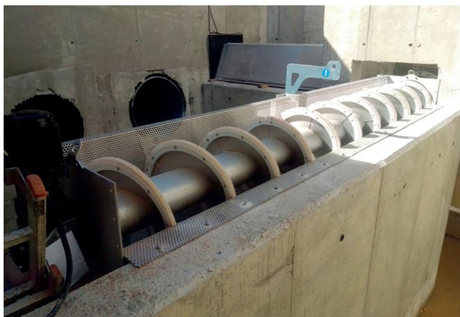
Ilustración 27. Tamiz de aliviadero tipo tornillo en espiral, montado aguas abajo. Gestión localizada de los residuos a una arqueta adyacente. Al fondo, aliviadero flexible para verter un elevado caudal (l/s-m) y que no entre en carga el sistema de saneamiento. Fuente: CleanWater.
