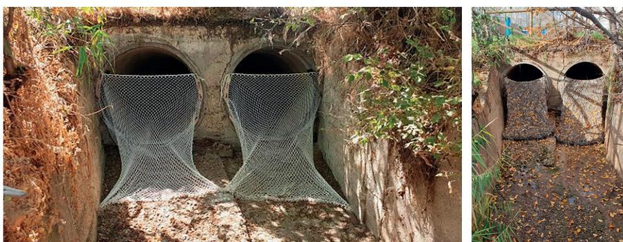
Ilustración 44. Retención de sólidos gruesos y flotantes mediante la instalación de 2 cuellos (acero inoxidable AISI-316) para colectores de 1.500 mm de diámetro con 2 cestas TecnoGrabber®, gestionados por la «Sociedad Española de Ornitología» (SEO BirdLife) en el sistema de saneamiento de Coslada (Madrid), que vierte al río Jarama. Fuente: Tecnoconverting.
