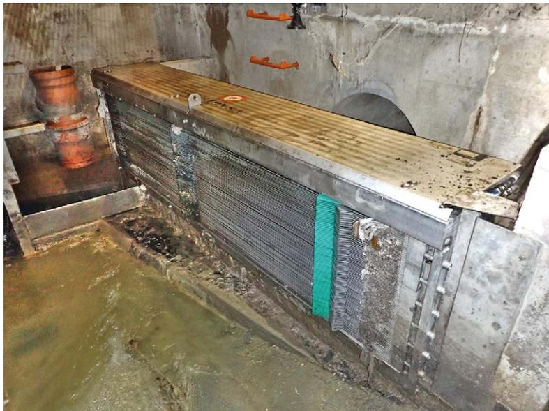
Ilustración 73. Ejemplo de reja equipada con sonda radar. Fuente: Consorcio de Aguas Bilbao Bizkaia.
