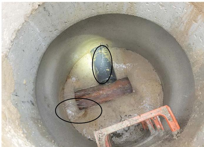
Ilustración 24. Infiltración en un pozo de registro (aguas parásitas). Fuente: HidroStank.
