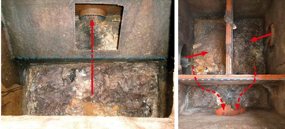
Ilustración 65. Adecuación de infraestructuras. Ejemplo de arquetas sifónicas como medida de retención de sólidos gruesos y flotantes en origen del sistema de saneamiento. Gestión localizada de residuos. Fuente: EMASESA.
