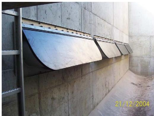
Ilustración 58. Clapetas antirretorno alargadas. Fuente: CleanWater.
