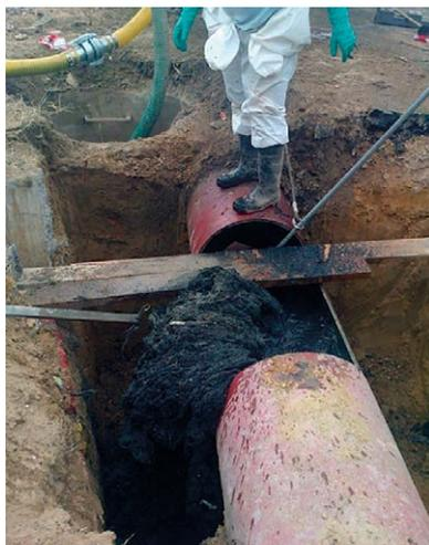
Ilustración 101. Retirada de toallitas higiénicas que provocan atascos en el sistema de saneamiento (acción correctiva). Fuente: EMASESA.
