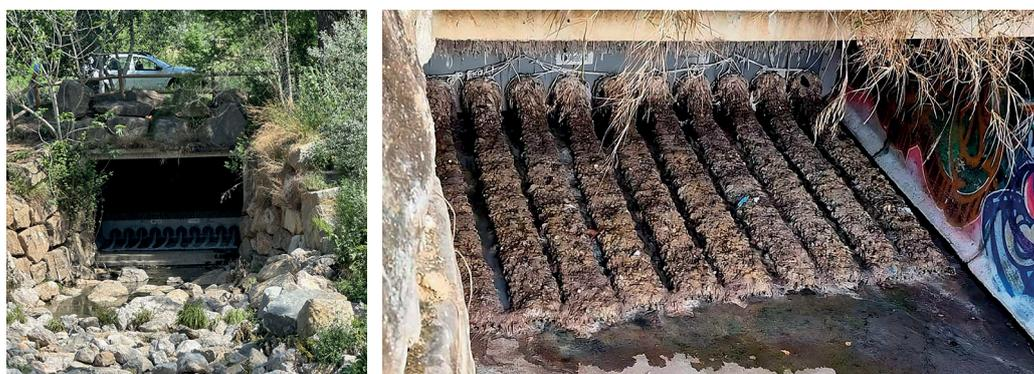
Ilustración 34. Retención de sólidos gruesos y flotantes mediante la instalación de 10 cestas TecnoGrabber®. Rubí (Barcelona). Fuente: Tecnoconverting.
