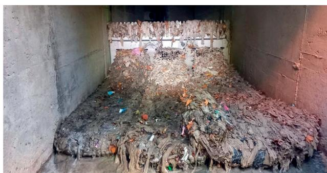
Ilustración 32. Retención de sólidos gruesos y flotantes mediante 3 cestas del modelo de alto rendimiento TecnoGrabber® (entradas rectangulares y mallas High-Strength). Manresa (Barcelona). Fuente: Tecnoconverting.
