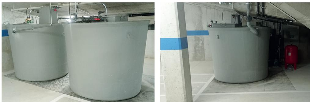
Ilustración 6. Reutilización de las aguas grises de un edificio de 25 viviendas, para rellenar las cisternas de los inodoros. En la planta subterránea del edificio de 25 viviendas se instaló la estación de reciclaje GREM 2500 VS (sistema vertical formado por 2 equipos capaces de regenerar 2.500 litros/día). Vilanova i la Geltrú (Barcelona). 2022. Fuente: ACO Remosa.
