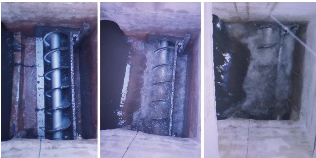
Ilustración 105. Tamiz en espiral instalado en el aliviadero Río Seco del sistema de saneamiento de Castellón. Malla de paso de 10 mm, 2,10 m de largo y 0,5 m de diámetro. El tornillo sin fin dispone de unas escobillas que retiran los sólidos de la malla de paso y los conduce a otra arqueta independiente. En dicha arqueta se retiran los sólidos mediante camión cuba. Cortesía del Ayuntamiento de Castellón.
