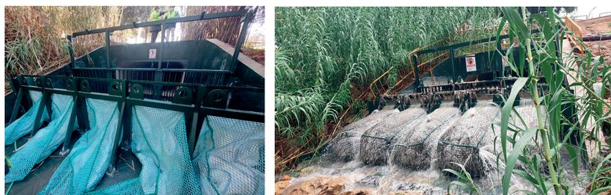
Ilustración 45. Sistema de retención de sólidos gruesos y flotantes con rebose superior para que el sistema de saneamiento no entre en carga. Los barrotos autolimpiables atrapan los primeros sólidos (toallitas higiénicas y papeles) y las bolsas desechables el resto de los sólidos menos voluminosos. Aliviadero Camino de las Aceñas o Cercadillos (Gis 100). Río Guadaíra. Alcalá de Guadaíra (Sevilla). Fuente: EMASESA.
