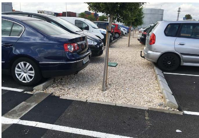
Ilustración 95. Zanja de infiltración en el aparcamiento de una nave logística en Riba-roja de Túria (Valencia). Año 2018. Fuente: Green Blue Management S.L. (Grupo TYPSA).
