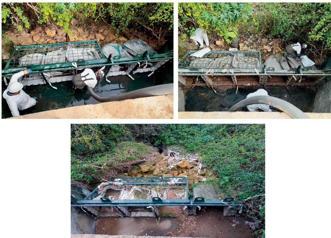
Ilustración 11. Tareas de limpieza tras un VDSS (acción correctiva) en el aliviadero Camino de Retama, junto al Puente Jesús Nazareno (Gis 170). Consta de un sistema de retención de sólidos gruesos y flotantes con reboso superior para que el sistema de saneamiento no entre en carga: Las rejas atrapan los primeros sólidos (toallitas higiénicas y papeles) y las bolsas desechables el resto de los sólidos menos voluminosos. Alcalá de Guadaíra (Sevilla). Fuente: EMASESA.
