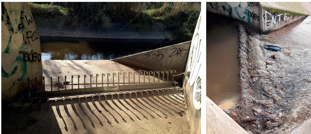
Ilustración 31. Rejas de retención. Retención de sólidos gruesos y flotantes mediante Grapas TecnoGrabber®. Sant Feliu de Llobregat (Barcelona). Fuente: Tecnoconverting.
