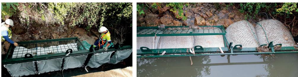
Ilustración 46. Sistema de retención de sólidos gruesos y flotantes con rebose superior para que el sistema de saneamiento no entre en carga: Las rejas atrapan los primeros sólidos (toallitas higiénicas y papeles) y las bolsas desechables el resto de los sólidos menos voluminosos. Aliviadero junto al Puente Jesús Nazareno (Gis 170). Alcalá de Guadaíra (Sevilla). Fuente: EMASESA.
