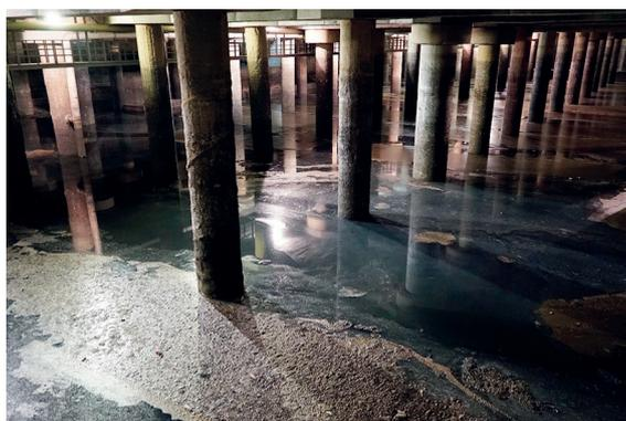
Ilustración 20. Ejemplo de tanque de tormentas. Fuente: Canal de Isabel II S.A.M.P.
