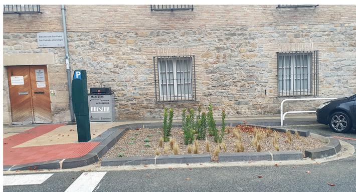
Ilustración 53. Paso peatonal permeable. Instalado en la calle Virgen del Río (Pamplona). Año 2020. Fuente: Hidrostack.
