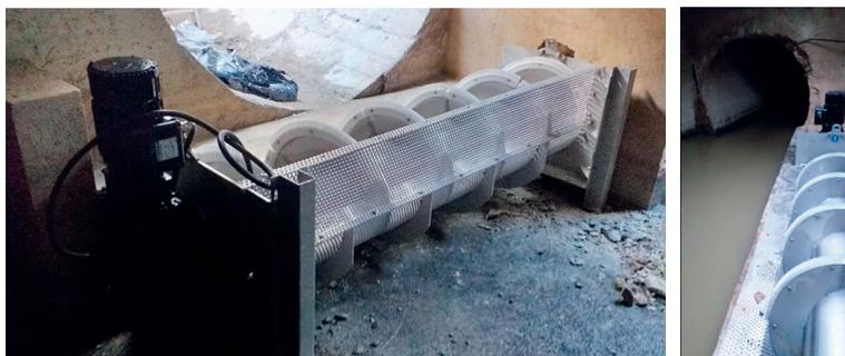
Ilustración 43. Tamices en espiral instalados en aliviaderos del sistema de saneamiento de Castellón. Fuente: Ayuntamiento de Castellón.
