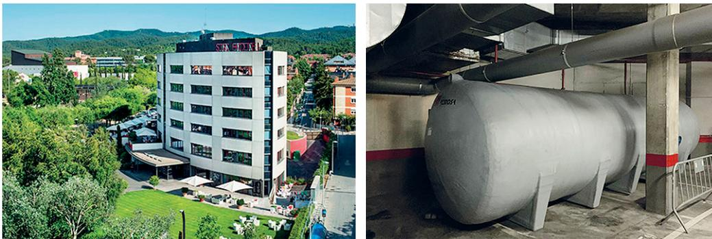
Ilustración 4. Reutilización de aguas pluviales en el Hotel El Sant Cugat para el riego por aspersión y goteo. El equipo consta de un filtro (retiene y separa partículas de suciedad, hojas y pequeños animales que pueden ser arrastrados con el agua de lluvia) y un depósito de almacenamiento del agua filtrada, localizado en el garaje subterráneo del hotel, con recirculación continua y control de cloro. Sant Cugat del Vallès (Barcelona). 2023. Fuente: ACO Engineering.
