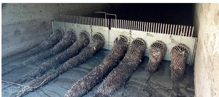
Ilustración 33. Retención de sólidos gruesos y flotantes mediante la instalación de 8 cestas TecnoGrabber® en el Canal de l'Aviació. Prat de Llobregat (Barcelona). 04/05/2023 Fuente: Tecnoconverting.
