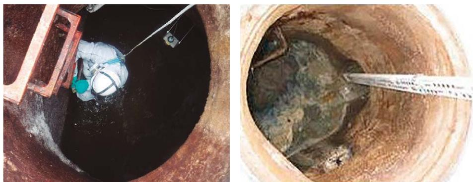
Ilustración 22. Inventario de la red de alcantarillado: conjunto de tareas para determinar la estructura y las características específicas de una red. Fuente: SOCADE.
