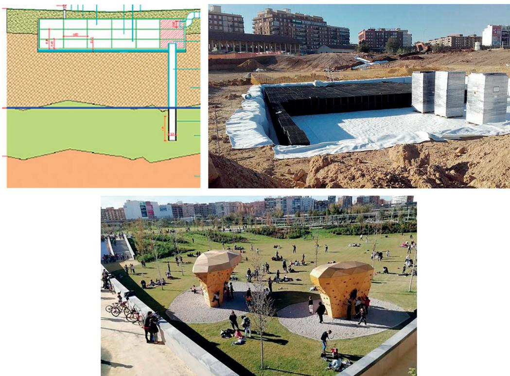
Ilustración 56. SUDS: Zanjas y pozos de infiltración. Parque Central de Valencia. La escorrentía pluvial llega al depósito una vez ha sido captada y filtrada por las zanjas drenantes. Fuente: «Ciclo Integral del Agua» del «Ayuntamiento de Valencia».
