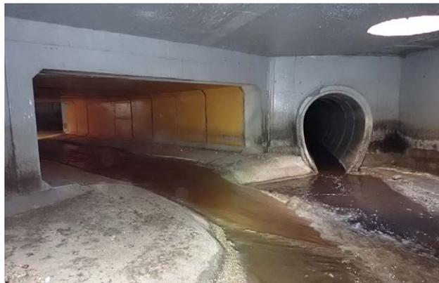
Ilustración 66. Adecuación de infraestructuras. Cámaras de interconexión en grandes colectores. Fuente: EMASESA.
