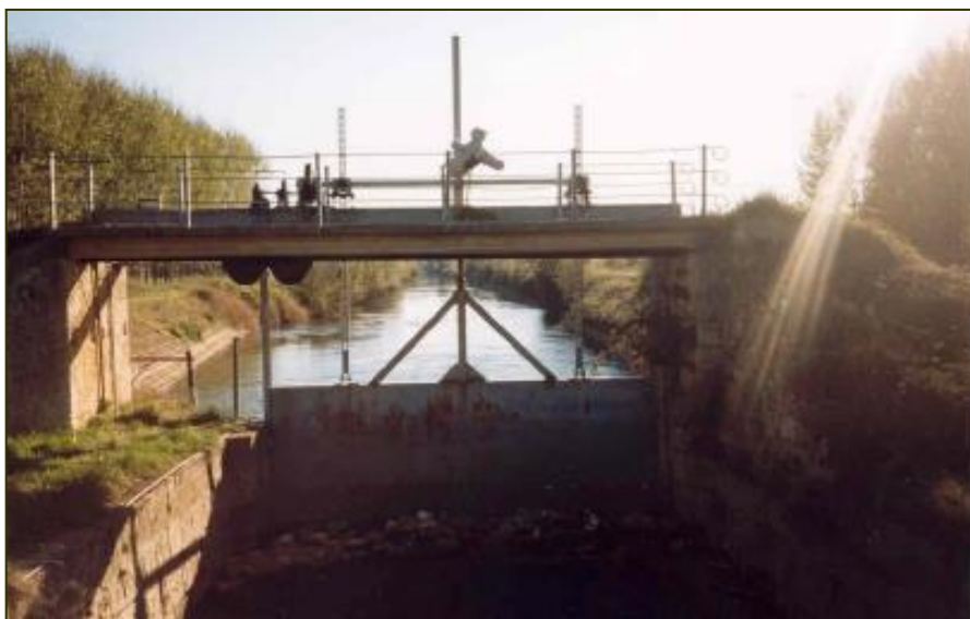
Figura 13. Presa de Calahorra (Palencia).
