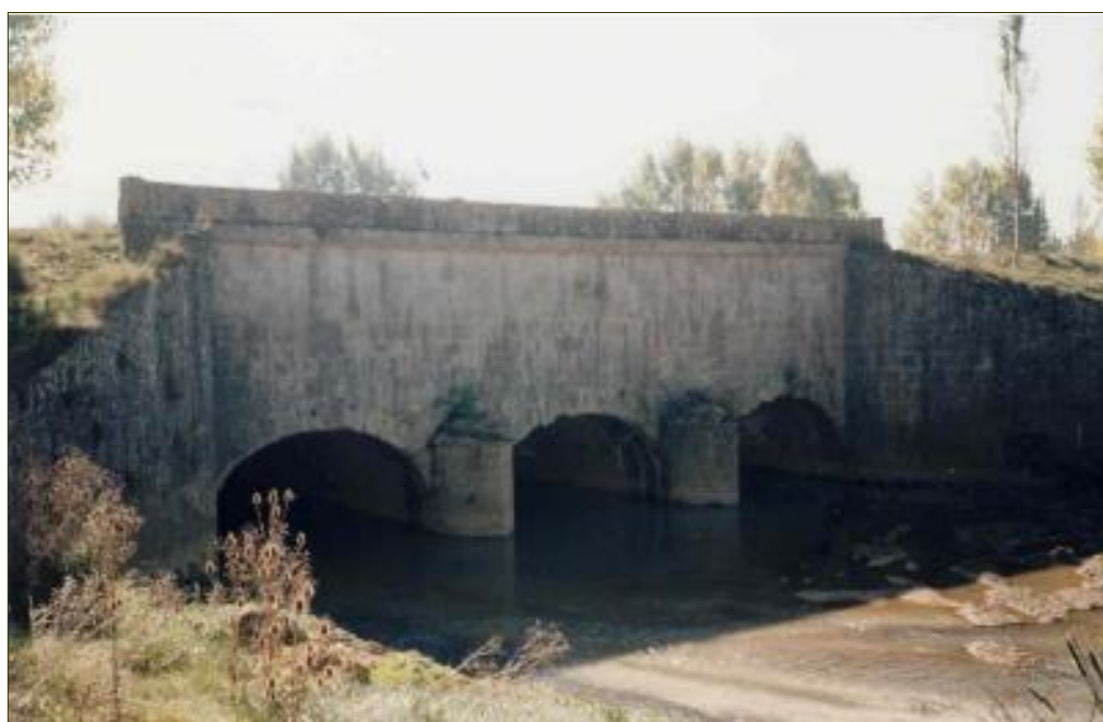
Figura 3. Acueducto de Ucieza (Palencia)
