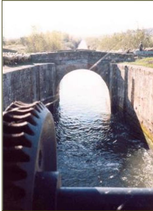
Figura 16. Puente en Esclusa 7 (Palencia).
