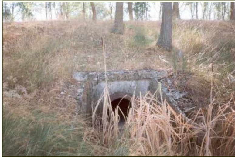
Figura 4. Alcantarilla del Arroyal (Palencia)
