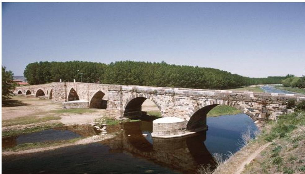
Figura 27. Puente de Hospital de Órbigo (León)
