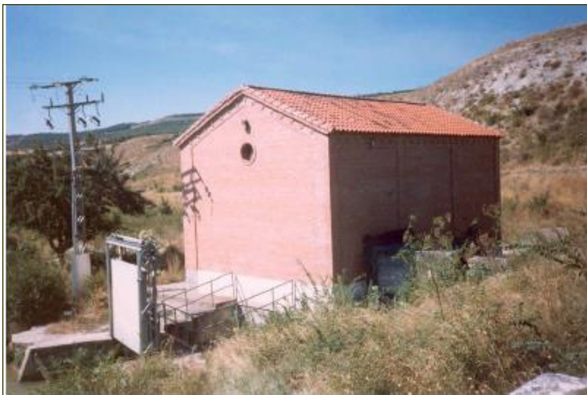
Figura 22. Central hidroeléctrica en las esclusas 34-35-36.
