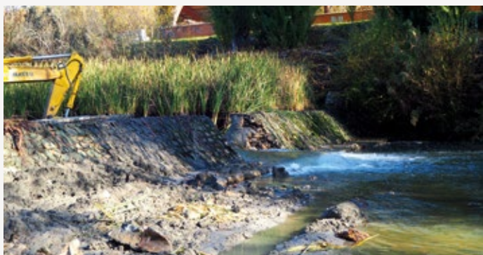
FIGURA 42 Demolición parcial del azud para vaciado del remanso y construcción de la atagüa
