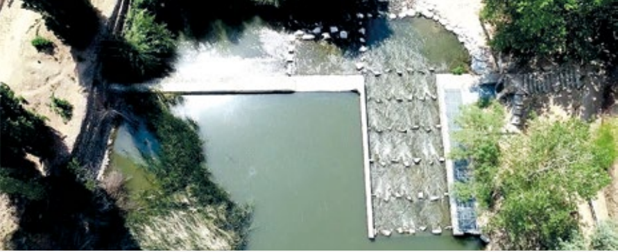
FIGURA 33 Vista aérea de la obra ya finalizada (vuelo dron 2019)
