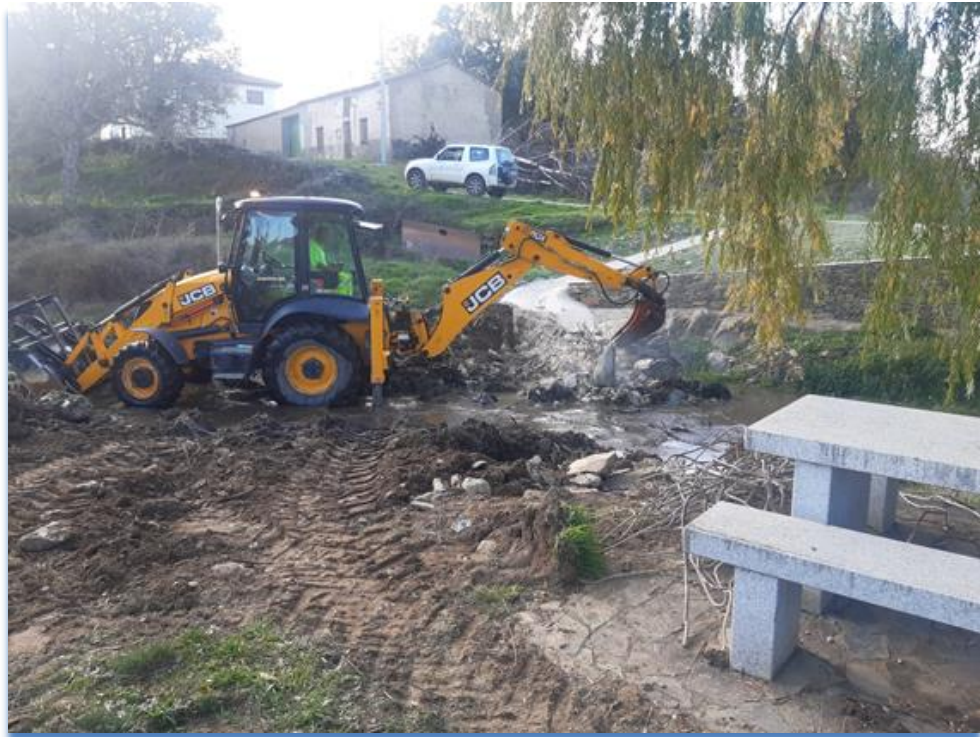
Foto 14. Demolición de un azud en el río Huebra (Salamanca). Fuente CHD
