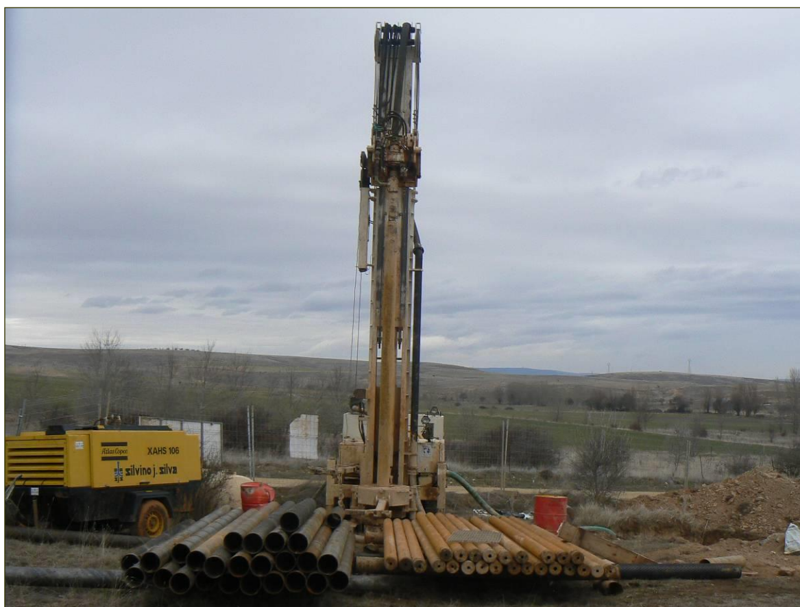
Figura 14. Trabajos de construcción de sondeos para el desarrollo de los programas de seguimiento del estado de las masas de agua subterránea en la cuenca española del Duero
