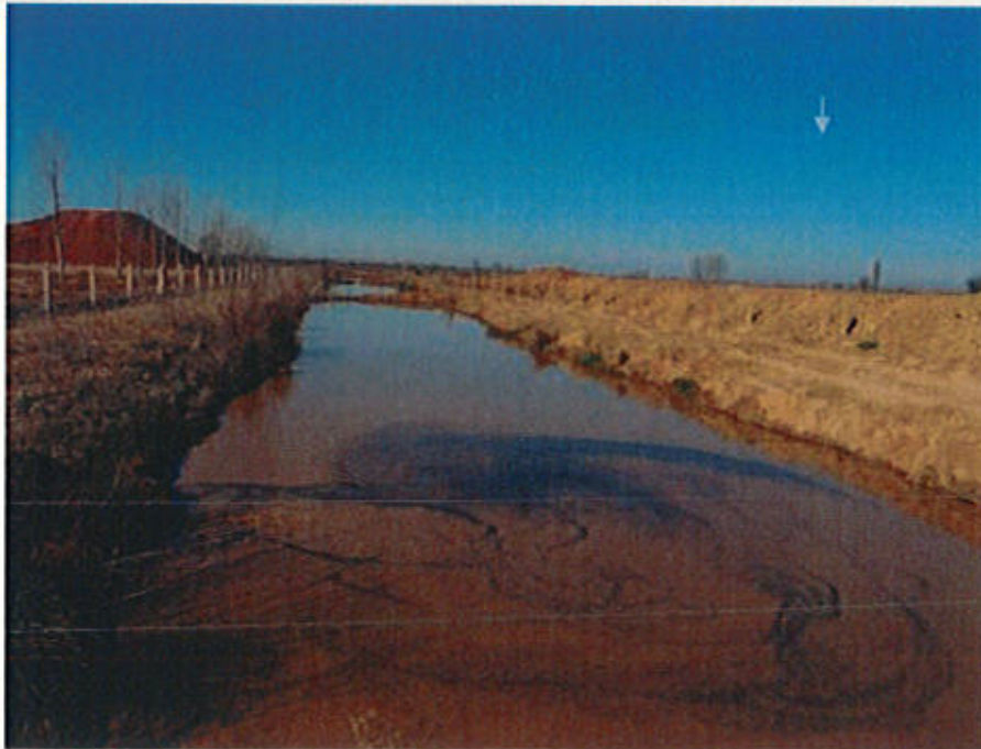
Ilustración 40: Balsa decantación de lodos
