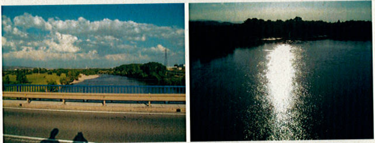
Ilustración 35: Acumulación de gravas en el Ebro a su paso por Castejón
