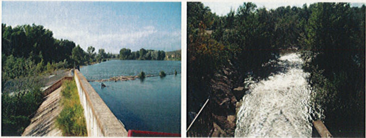
Ilustración 36: Azud del canal de la central hidroeléctrica de Sargantuda
