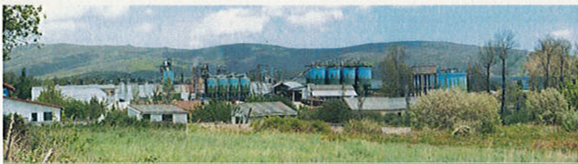
Ilustración 28: Vista general de una planta de tratamiento
