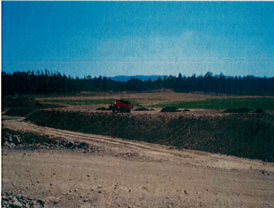
Ilustración 22: Movimiento de tierras
