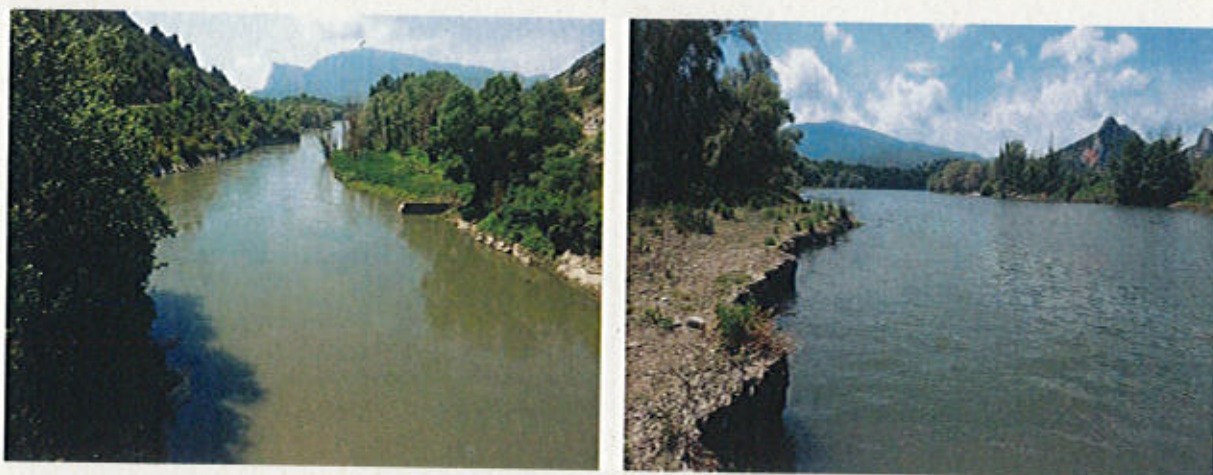
Ilustración 321: Fotos de las áreas que han sido objeto de extracción - Cola de embalse canalizada y acondicionada por la actividad extractiva
