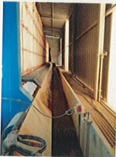
Ilustración 44: Filtro-Prensa para tratamiento de lodos
