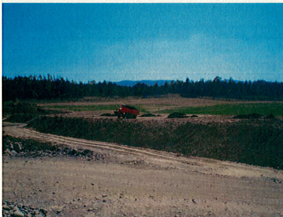
Ilustración 22: Movimiento de tierras
