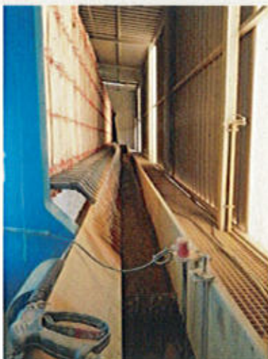
Ilustración 44: Filtro-Prensa para tratamiento de lodos
