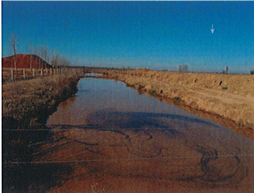
Ilustración 40: Balsa decantación de lodos
