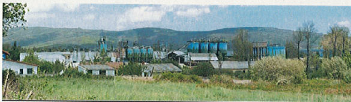
Ilustración 28: Vista general de una planta de tratamiento
