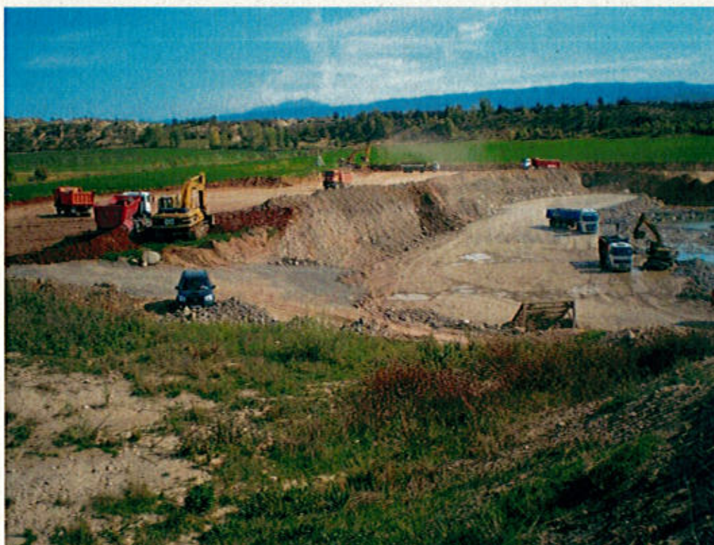
Ilustración 7: Gravera activa simultaneando actividades de rehabilitación y explotación
