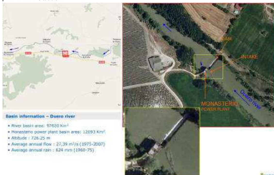
Figura núm. 1. Localización y vista aérea de la C.H. Monasterio. Fuente: Spanish Hydro Power Plants – Main Technical Characteristics.
