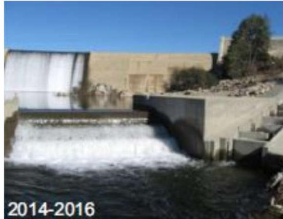
Figura 4. Rebaje de atracción hacia la escala de pees en el azud de amortiguación.
