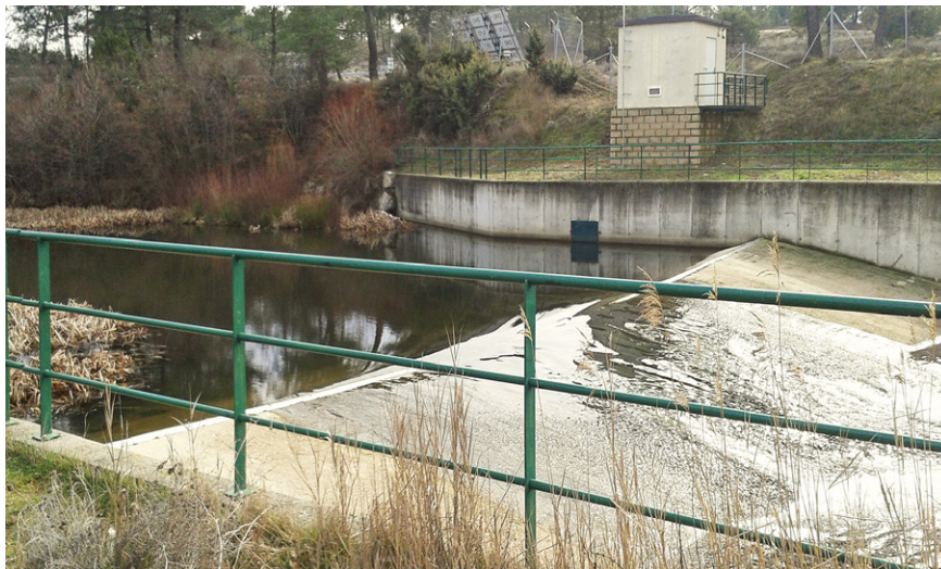
Foto 3. Río Cega. Captación y azud de la recarga del Carracillo.
